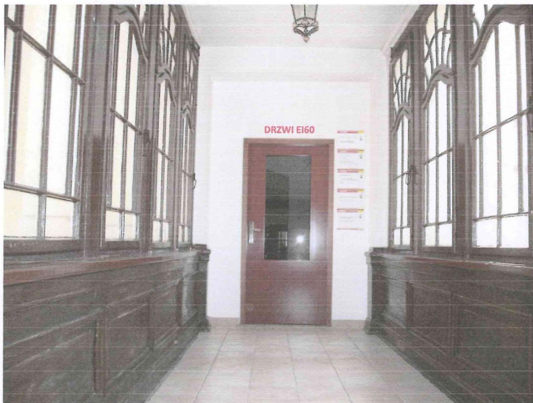
Fot. 7. Przejście do kamienic (druga strefa pożarowa) zamykane drzwiami przeciwpożarowymi w klasie EI 30
