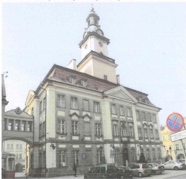
Fot.2. Widok elewacji tylnej (od strony parkingu)
