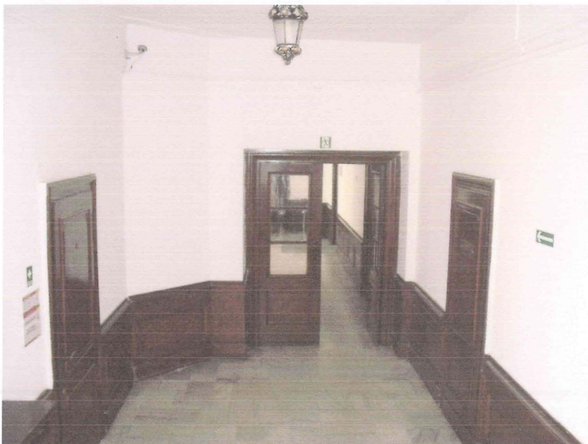
Fot. 10. Przejście z holu Ratusza do łącznika
