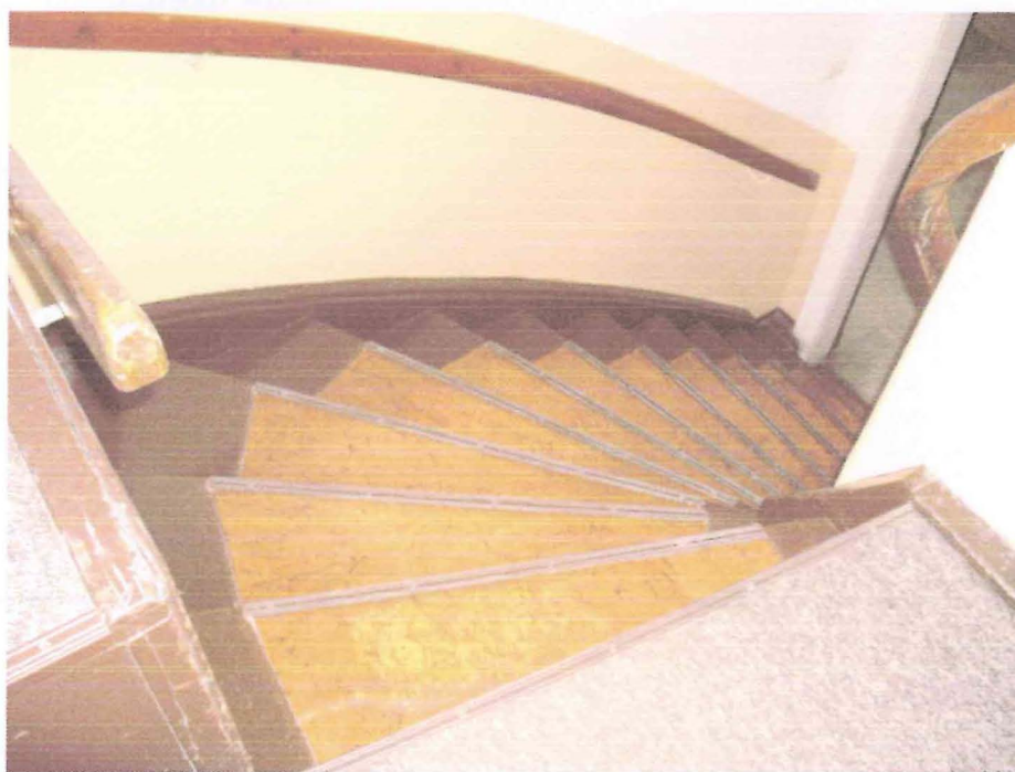
Fot 19 i 20 schody zabiegowe na poddasze użytkowe
