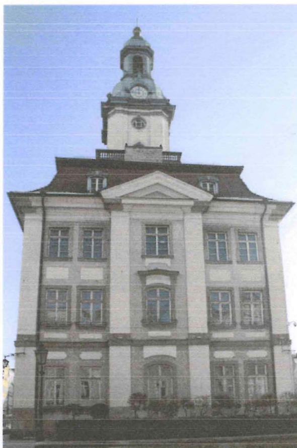
Fot. 3. Widok elewacji bocznej
