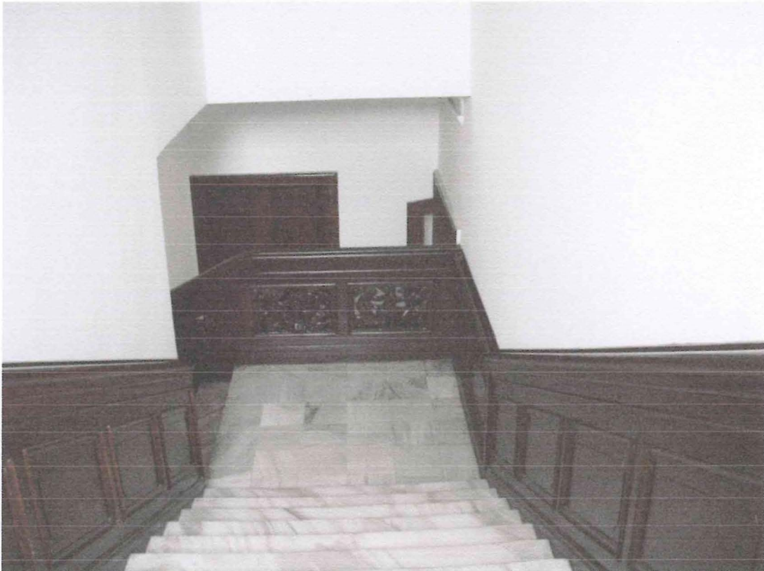
Fot. 11 i 12 Klatka schodowa
