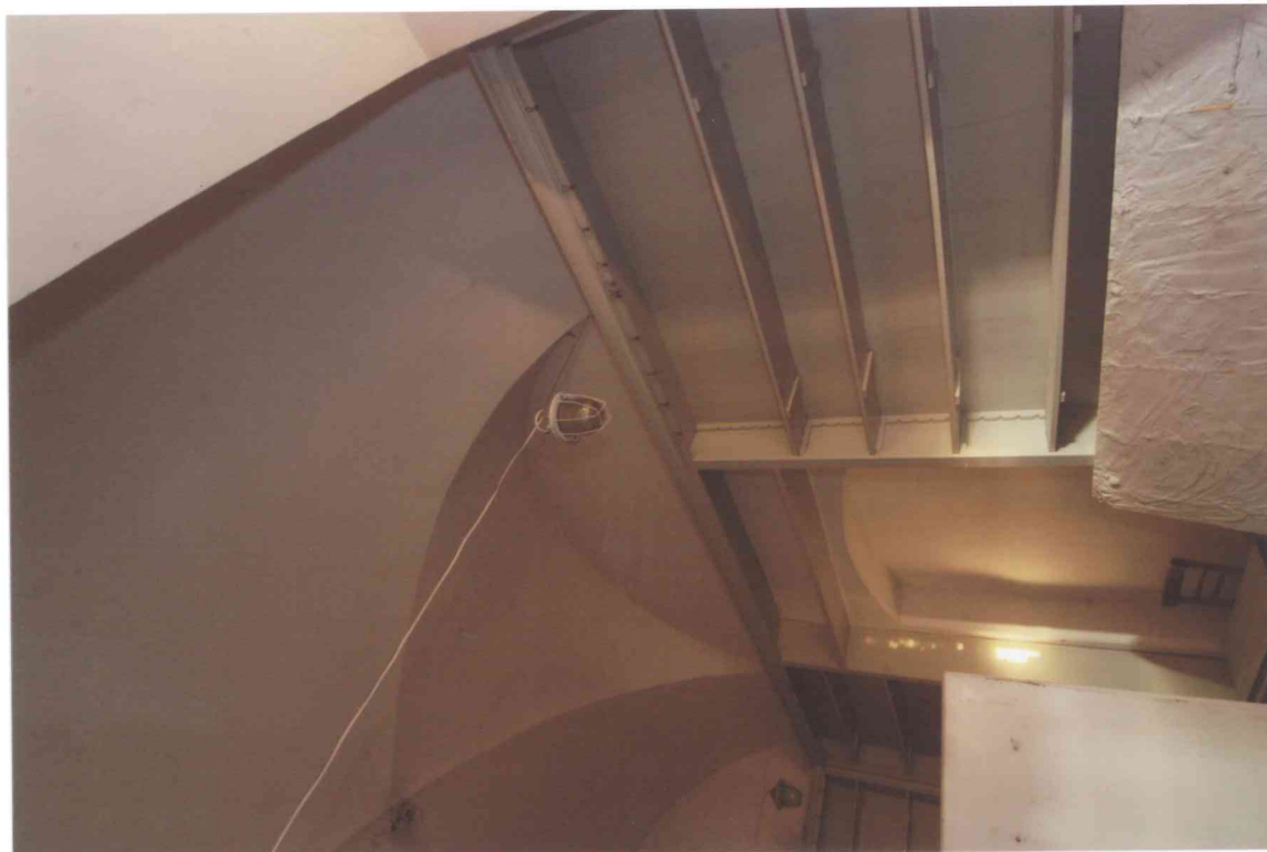
FOT. 3 - Pomieszczenie 1/01, widok na ścianę północną.
