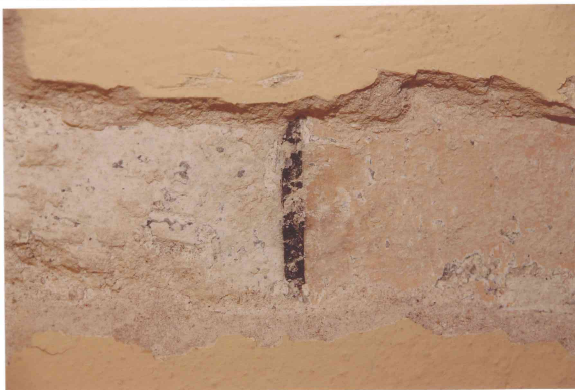
FOT. 20 - Korytarz 1/K , część zachodnia, ściana północna, detal fot. 18.
