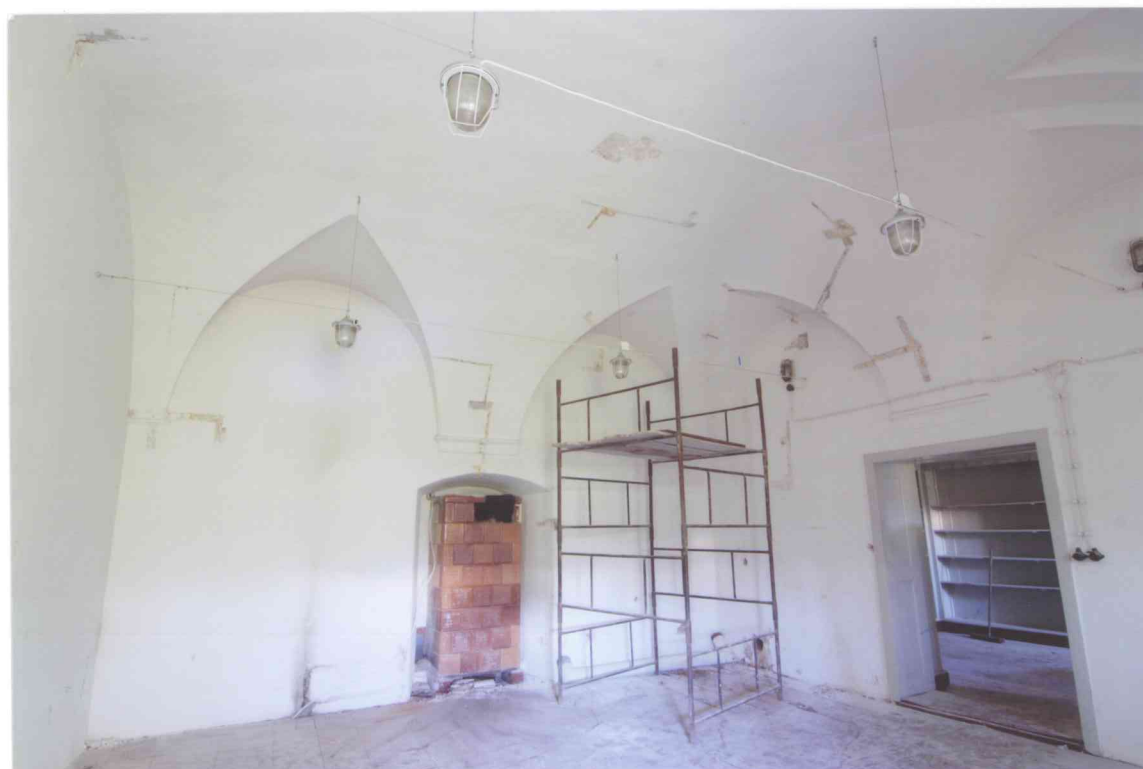
FOT. 4 - Pomieszczenie 1/03, widok narożnika południowo-wschodniego.
