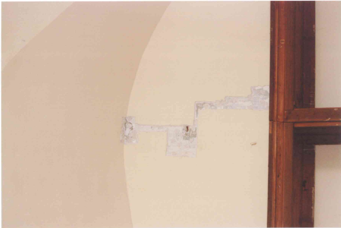
FOT. 9 - Pomieszczenie 1/06, ściana południowa, detal fot. 2.
