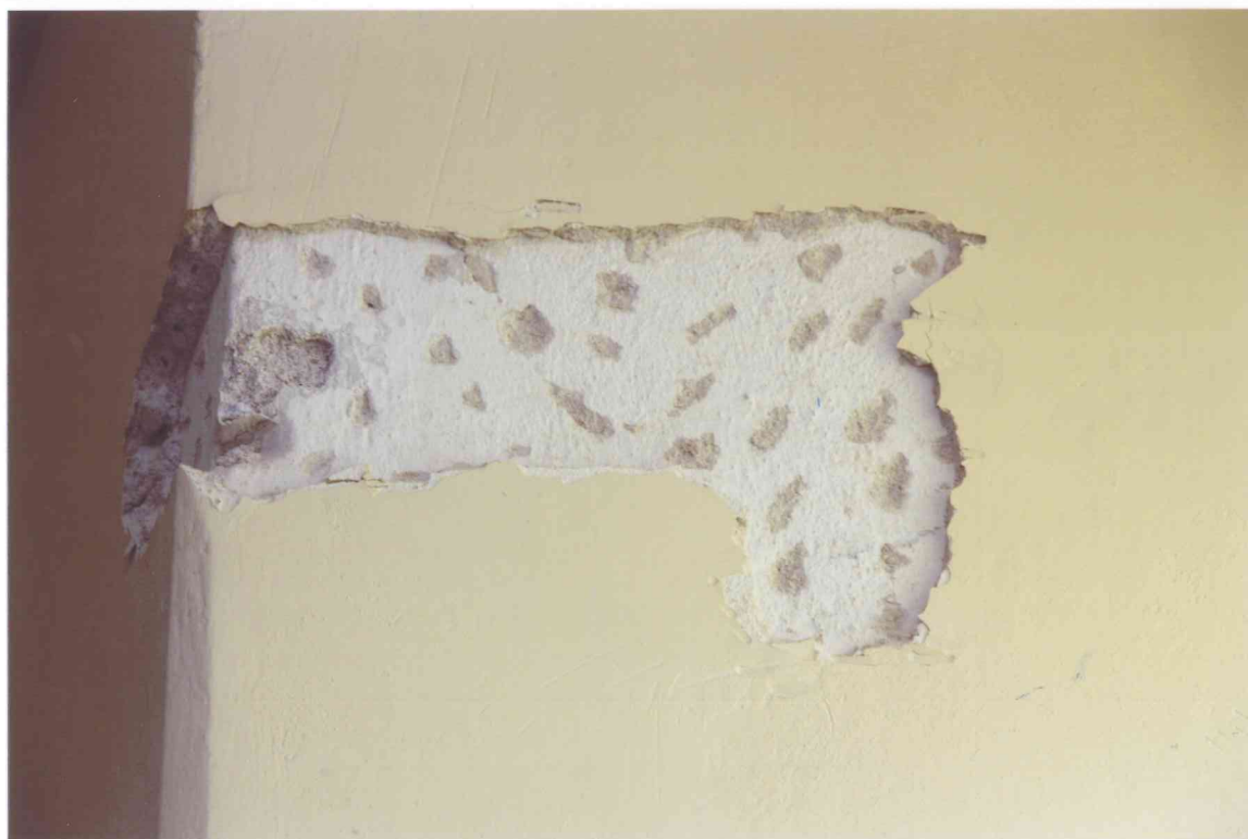
FOT. 10 - Pomieszczenie 1/05, ściana północna, glif okienny, detal fot. 3.
