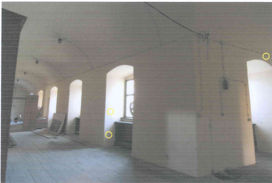
Korytarz 1/K , narożnik północno-zachodni, widok w stronę wschodnią na ścianę południową.
