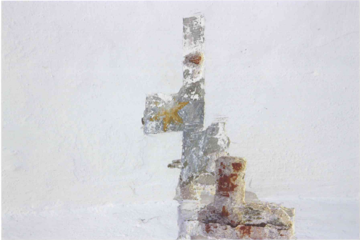
FOT. 19 - Pomieszczenie 1/03, sklepienie, część północna, detal fot. 3.
