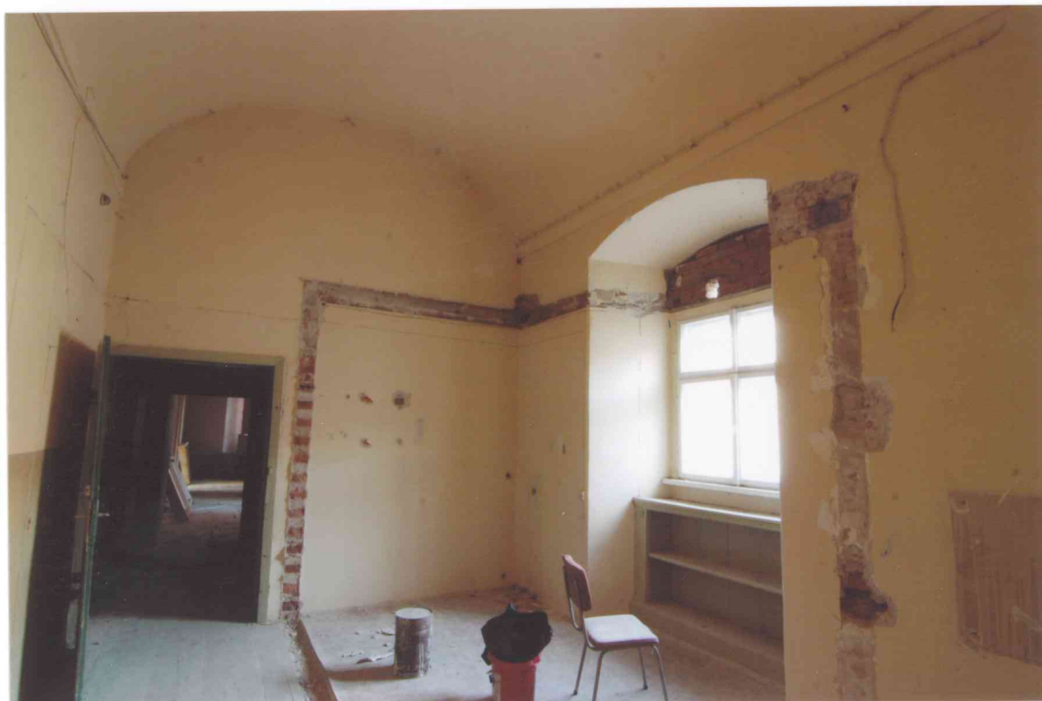
FOT. 4 - Korytarz 1/K , część zachodnia, widok w stronę wschodnią.
