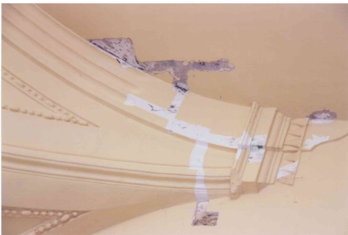
FOT. 16 - Pomieszczenie 1/07, narożnik południowo-zachodni, detal fot. 3.
