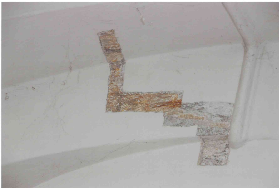
FOT. 13 - Pomieszczenie 1/03, narożnik północno-zachodni, detal fot. 1 i 2.
