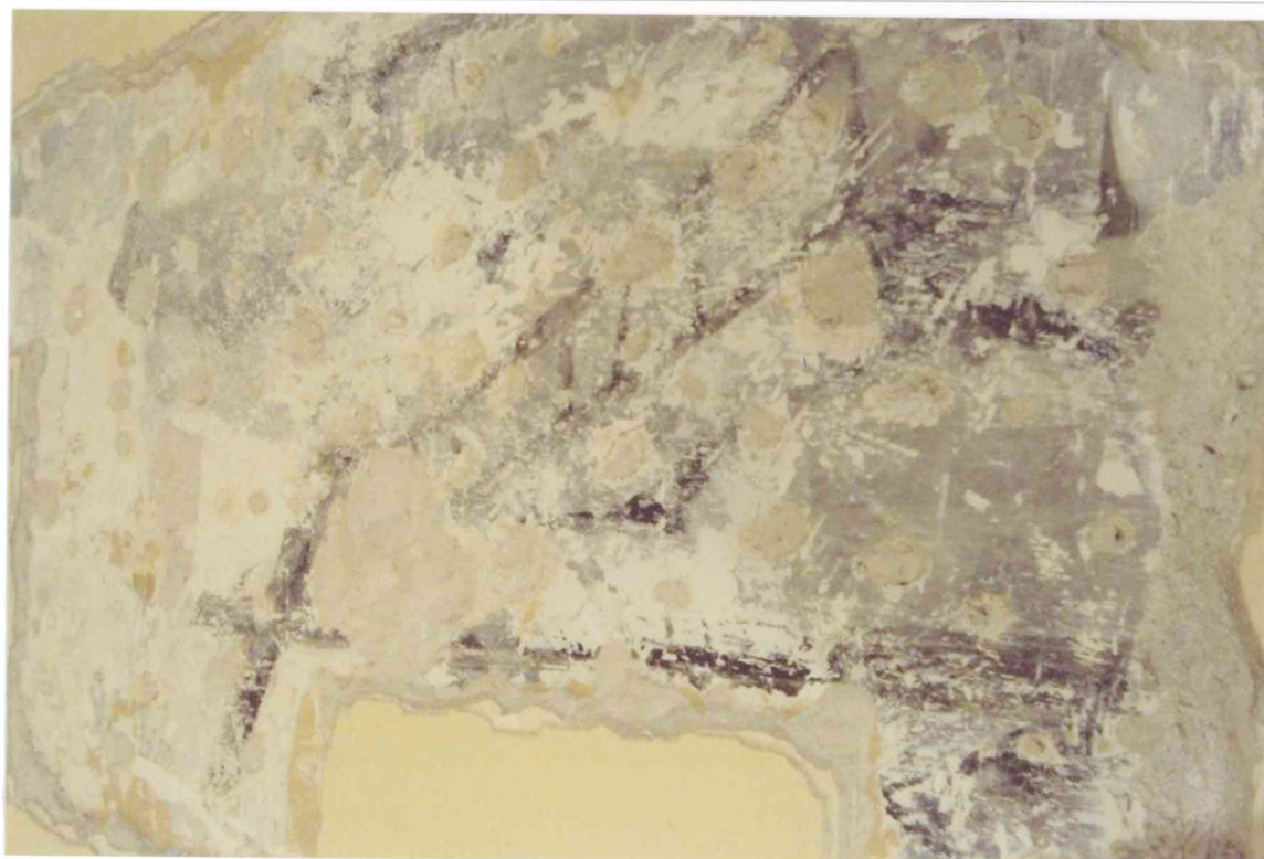
FOT. 20 - Pomieszczenie 1/07, ściana zachodnia, detal fot. 4.
