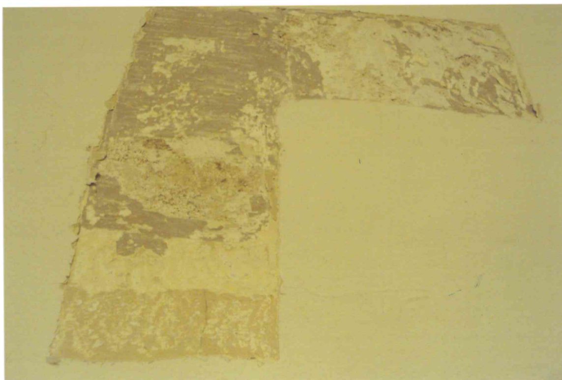
FOT. 8 - Pomieszczenie 1/01, ściana wschodnia w lunecie sklepienia, detal fot. 2.
