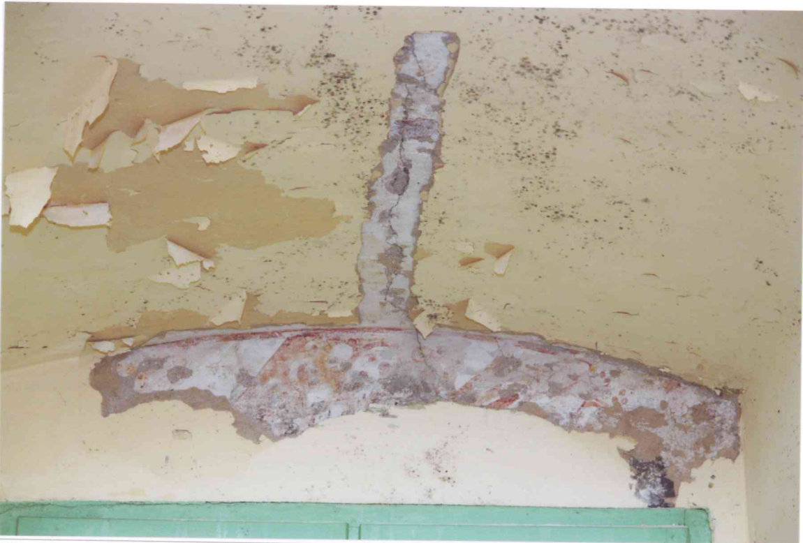
FOT. 13 - Pomieszczenie 1/07, ściana północna, glif okienny, detal fot. 1.
