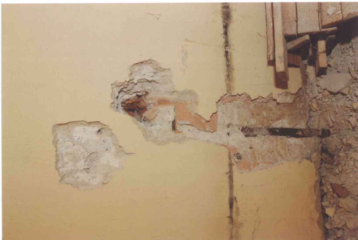
FOT. 17 - Korytarz 1/K , część zachodnia, ściana północna, cokół.
