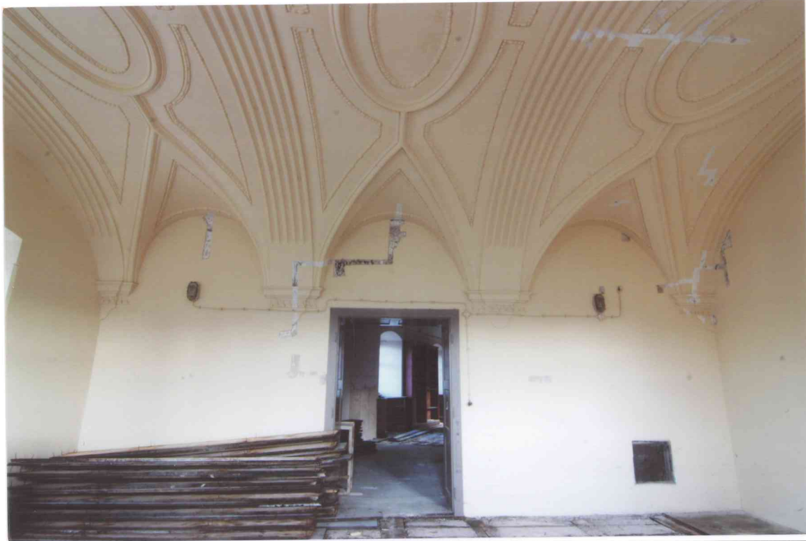
FOT. 3 - Pomieszczenie 1/07, widok ściany południowej.
