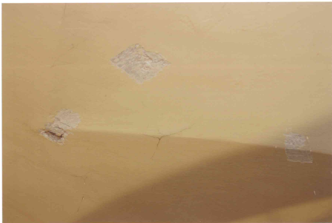
FOT. 13 - Korytarz 1/K , część zachodnia, narożnik północno-zachodni, sklepienie.
