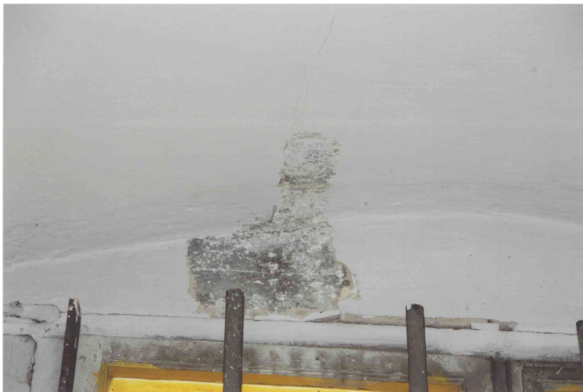
FOT. 5 - Pomieszczenie 1/02, ściana zachodnia, glif okienny, detal fot. 3.
