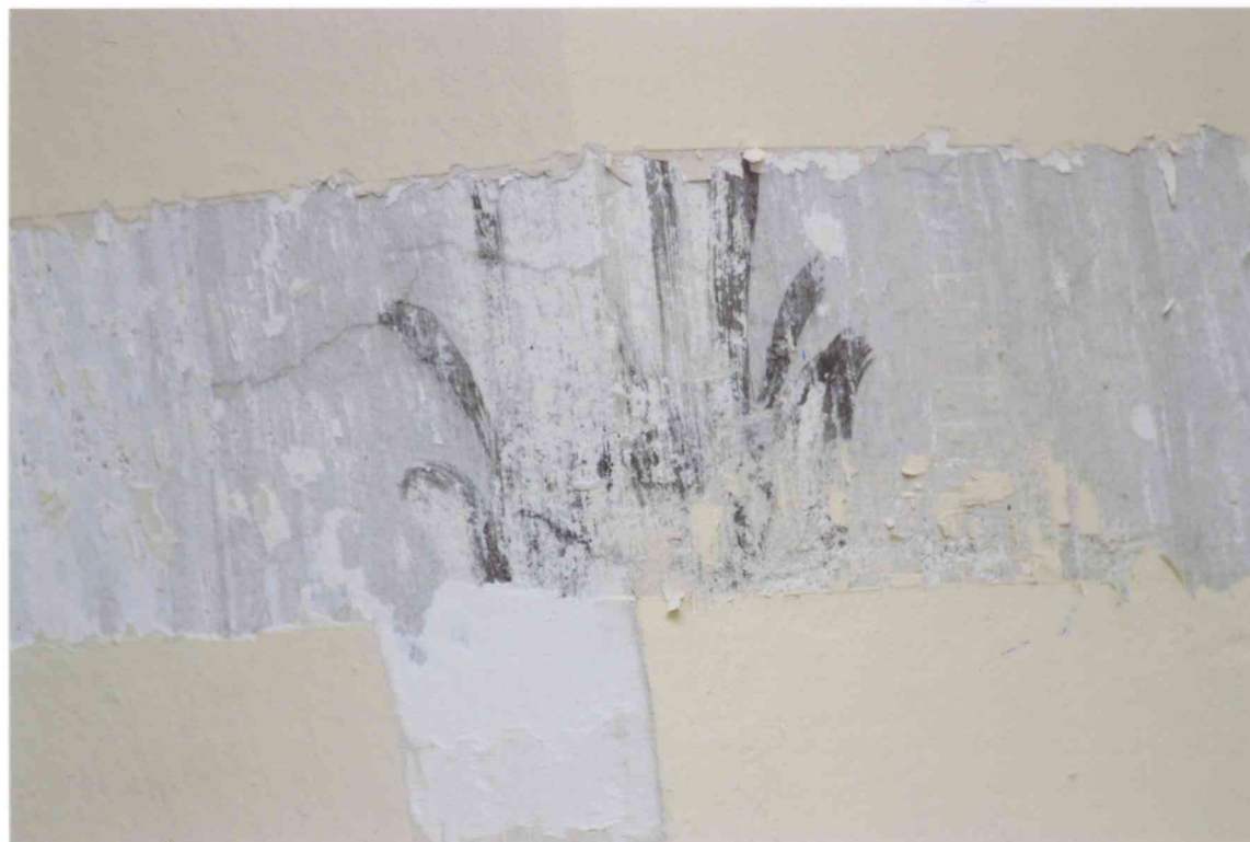
FOT. 34 - Pomieszczenie 1/06, narożnik północno-wschodni, sływ sklepienia, detal fot. 5.
