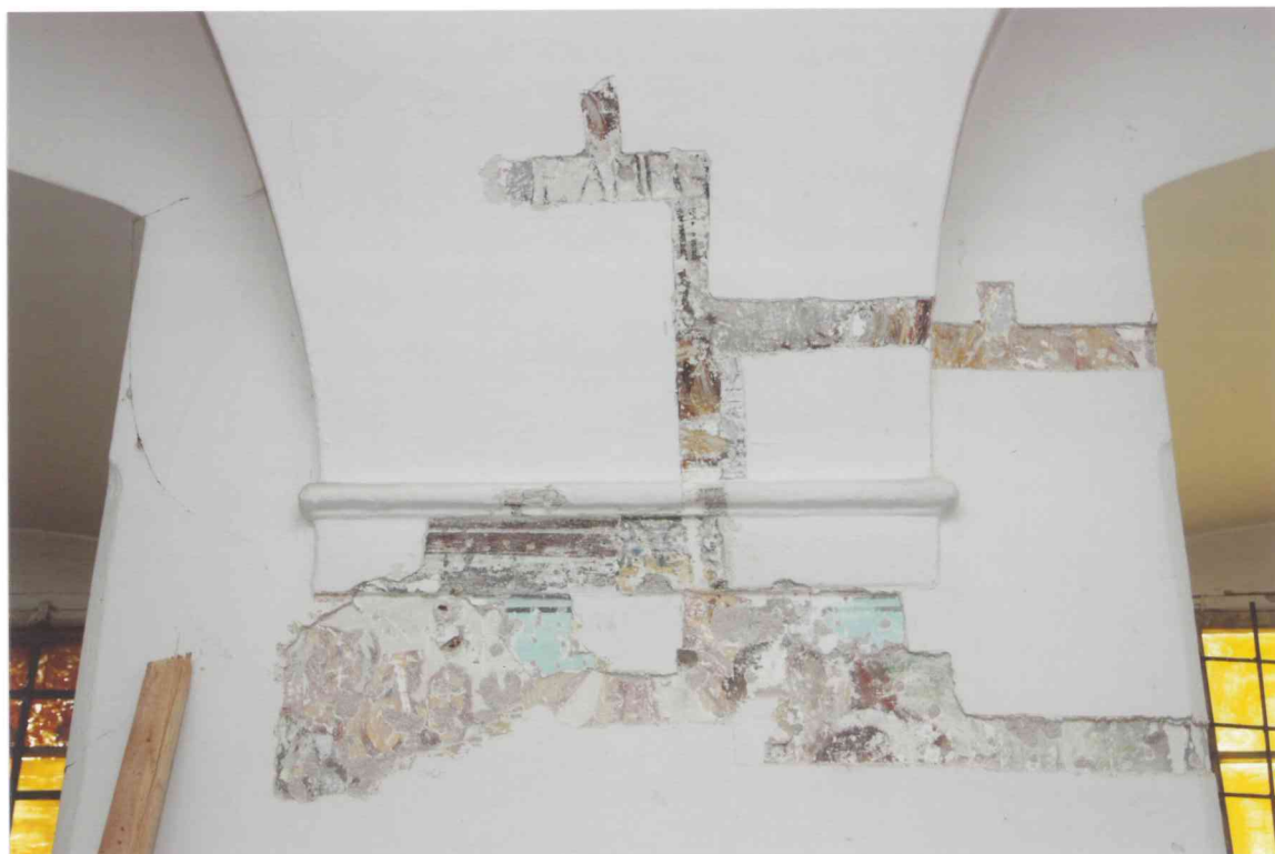
FOT. 5 - Pomieszczenie 1/03, ściana zachodnia, spływ sklepienia, detal fot. 2.
