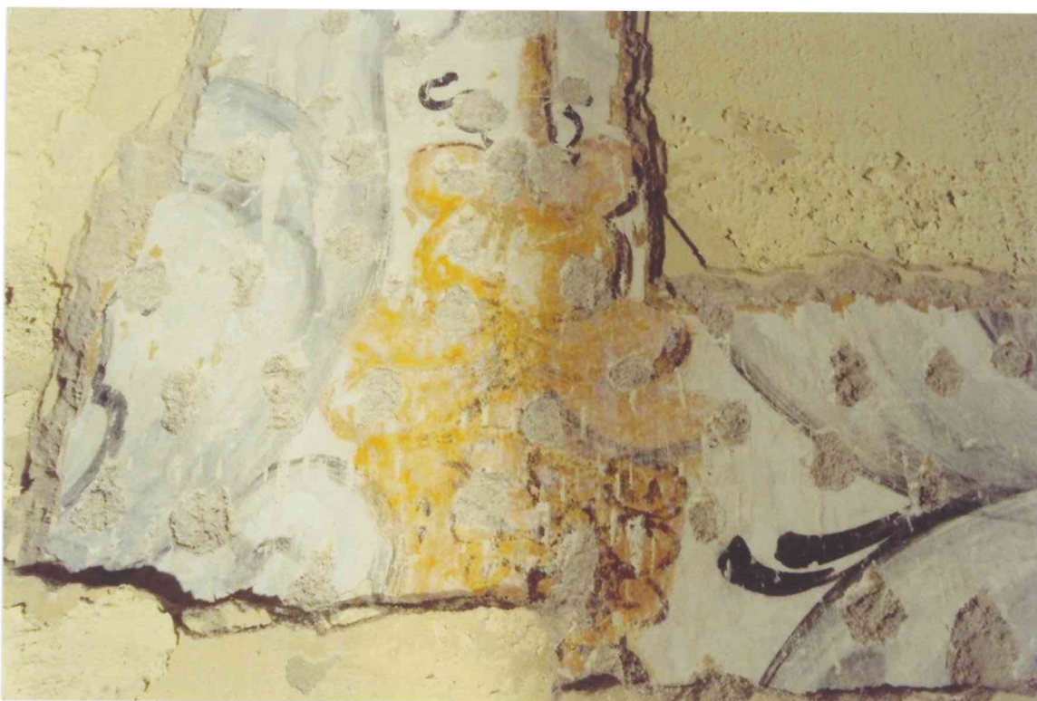
FOT. 19 - Pomieszczenie 1/07, ściana północna, glif okienny, detal fot. 1.
