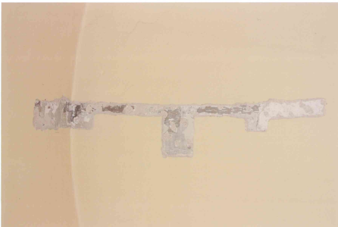
FOT. 13 - Pomieszczenie 1/06, ściana zachodnia, detal fot. 3.
