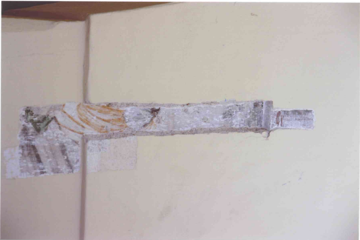
FOT. 30 - Pomieszczenie 1/06, ściana północna, glif okienny, detal fot. 1 i 5.
