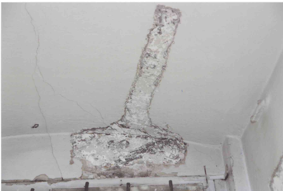
FOT. 10 - Pomieszczenie 1/03, ściana zachodnia, glif okienny, detal fot. 2.
