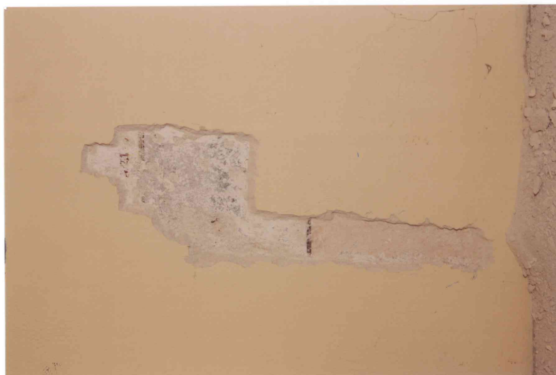
FOT. 18 - Korytarz 1/K , część zachodnia, ściana północna, cokół.
