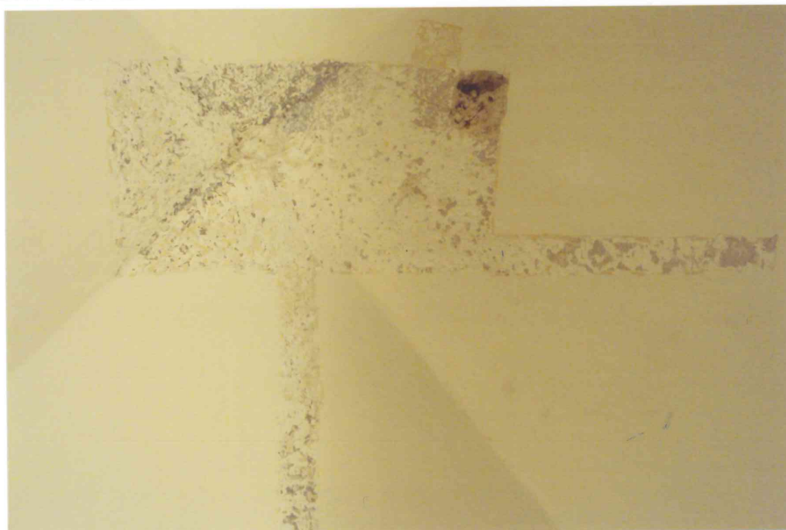
FOT. 8 - Pomieszczenie 1/02, sklepienie, detal fot. 1.
