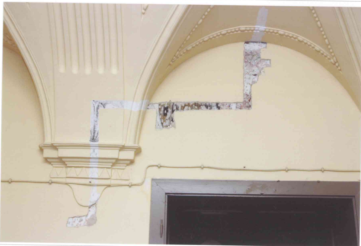
FOT. 14 - Pomieszczenie 1/07, ściana południowa, detal fot. 3.
