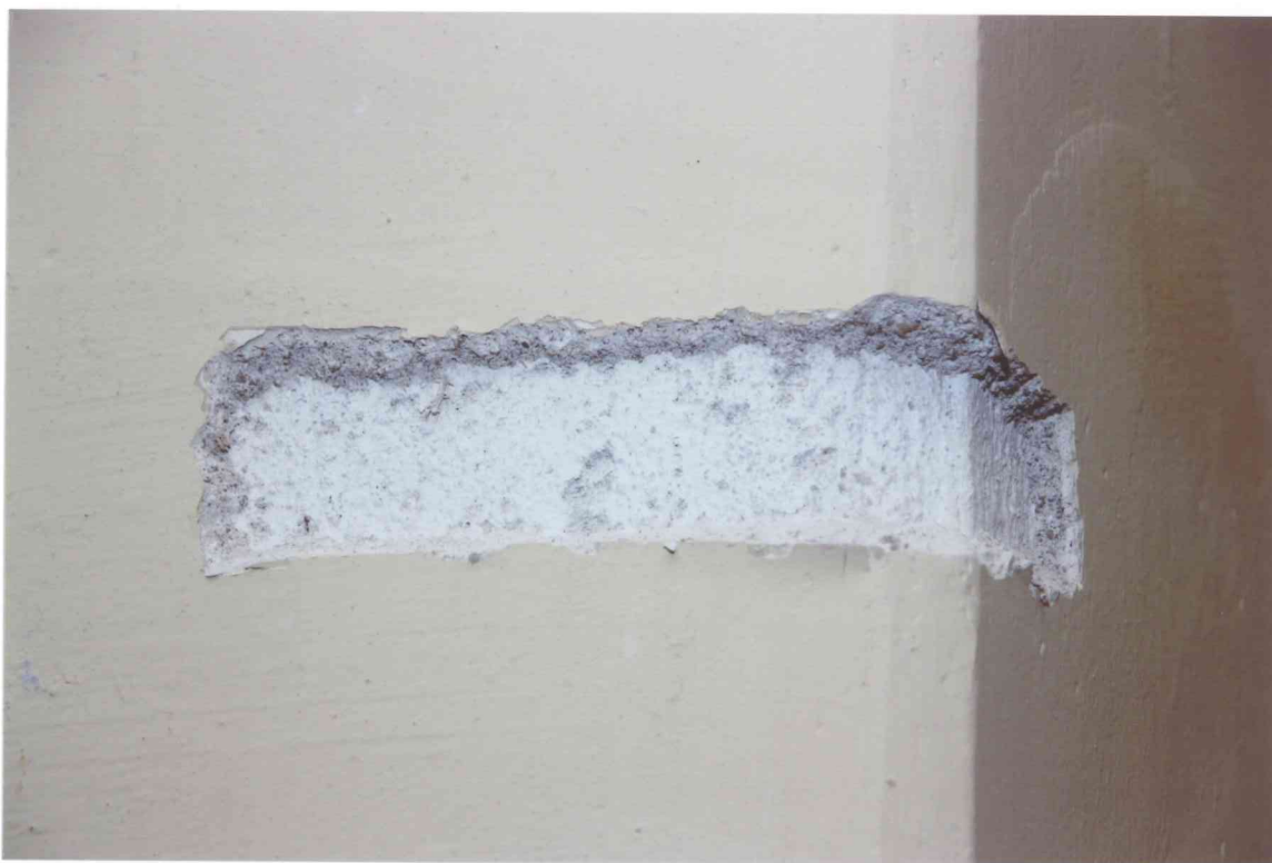
FOT. 11 - Pomieszczenie 1/05, ściana północna, glif okienny, detal fot. 3.
