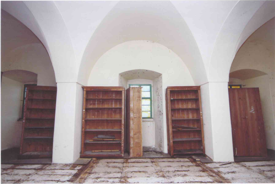
FOT. 1 - Pomieszczenie 1/06, widok ściany północnej.
