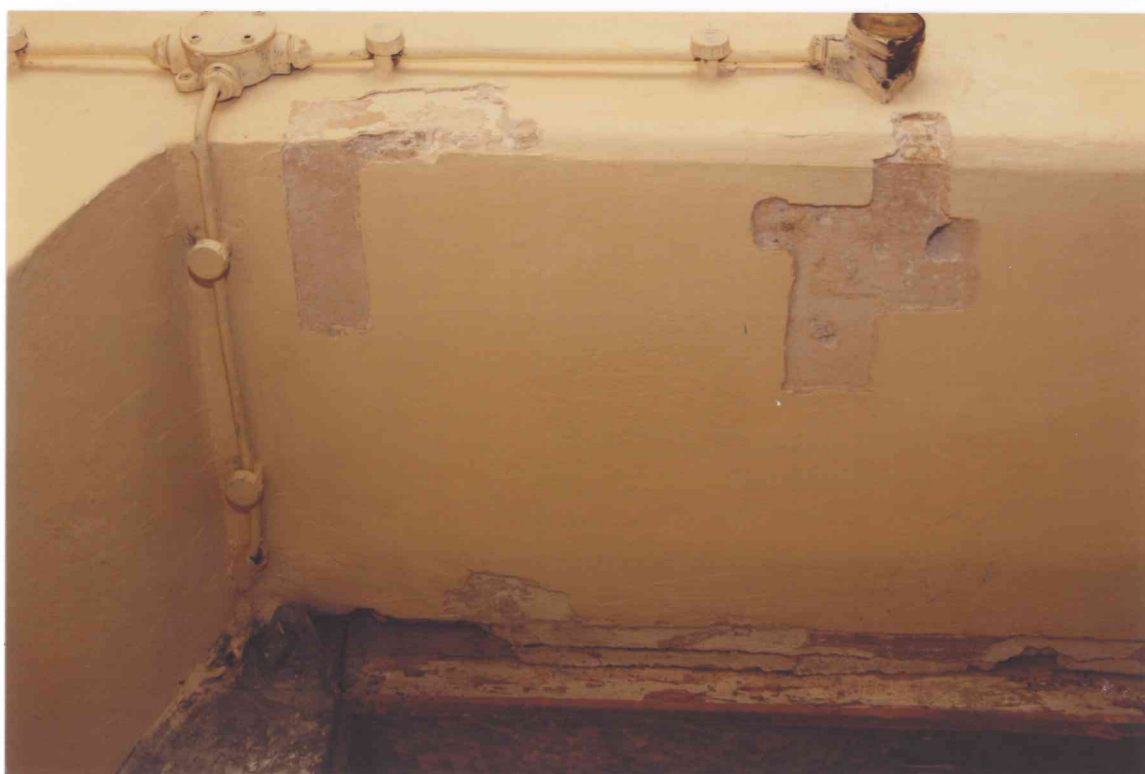
FOT. 4 - Pomieszczenie 1/05, ściana południowa, drzwi wejściowe, detal fot. 1 i 2.
