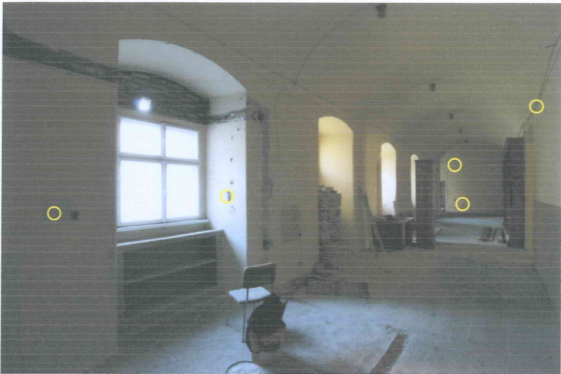
Korytarz 1/K, widok części północnej.
