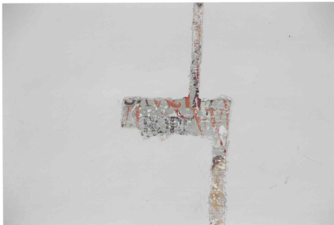
FOT. 18 - Pomieszczenie 1/03, ściana wschodnia, spływ sklepienia, detal fot. 4.
