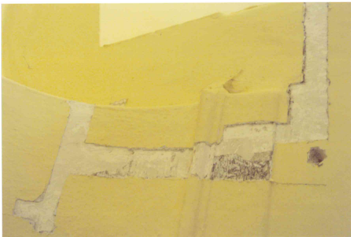
FOT. 3 - Pomieszczenie 1/04, ściana północna i spływ sklepienia, detal fot. 1.
