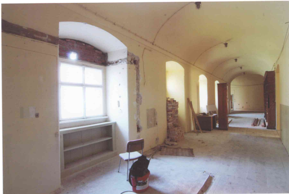
FOT. 3 - Korytarz 1/K , część zachodnia, widok w stronę zachodnią.
