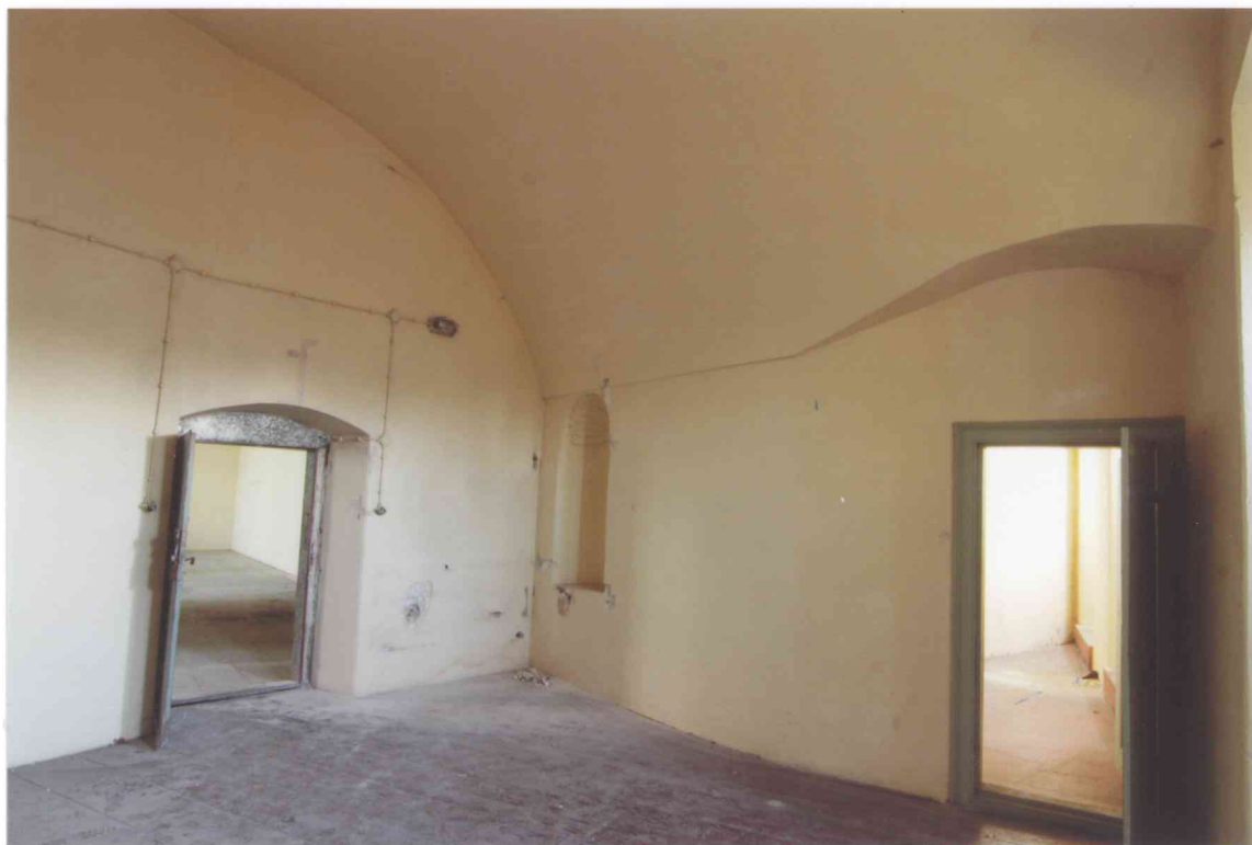
FOT. 2 - Pomieszczenie 1/05, narożnik południowo-wschodni.
