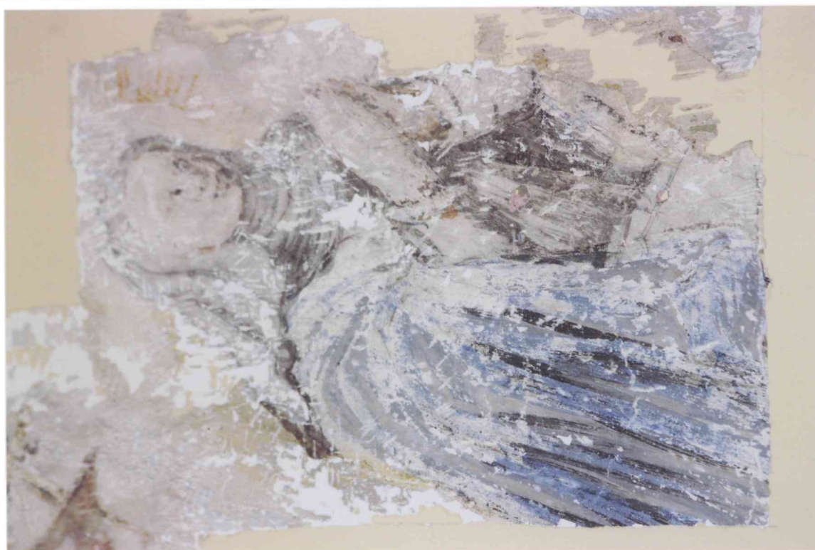
FOT. 18 - Pomieszczenie 1/06, detal fot. 17.
