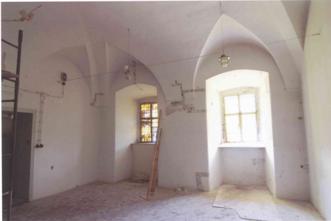
FOT. 2 - Pomieszczenie 1/03, widok ściany zachodniej.
