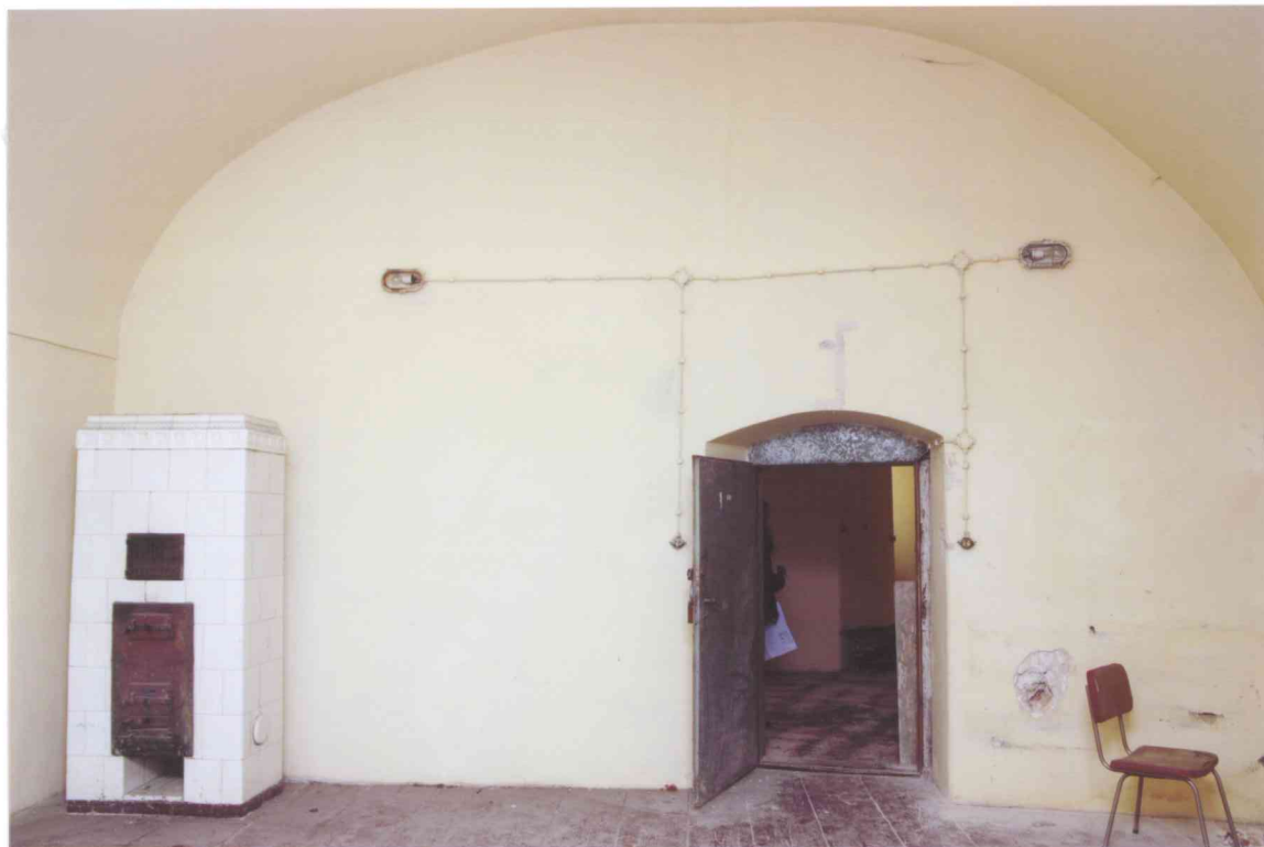
FOT. 1 – Pomieszczenie 1/05, widok ściany południowej.
