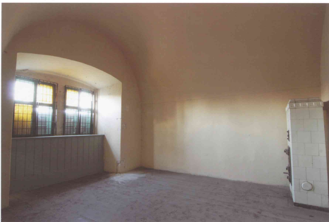
FOT. 3 - Pomieszczenie 1/05, widok narożnika północno-zachodniego.
