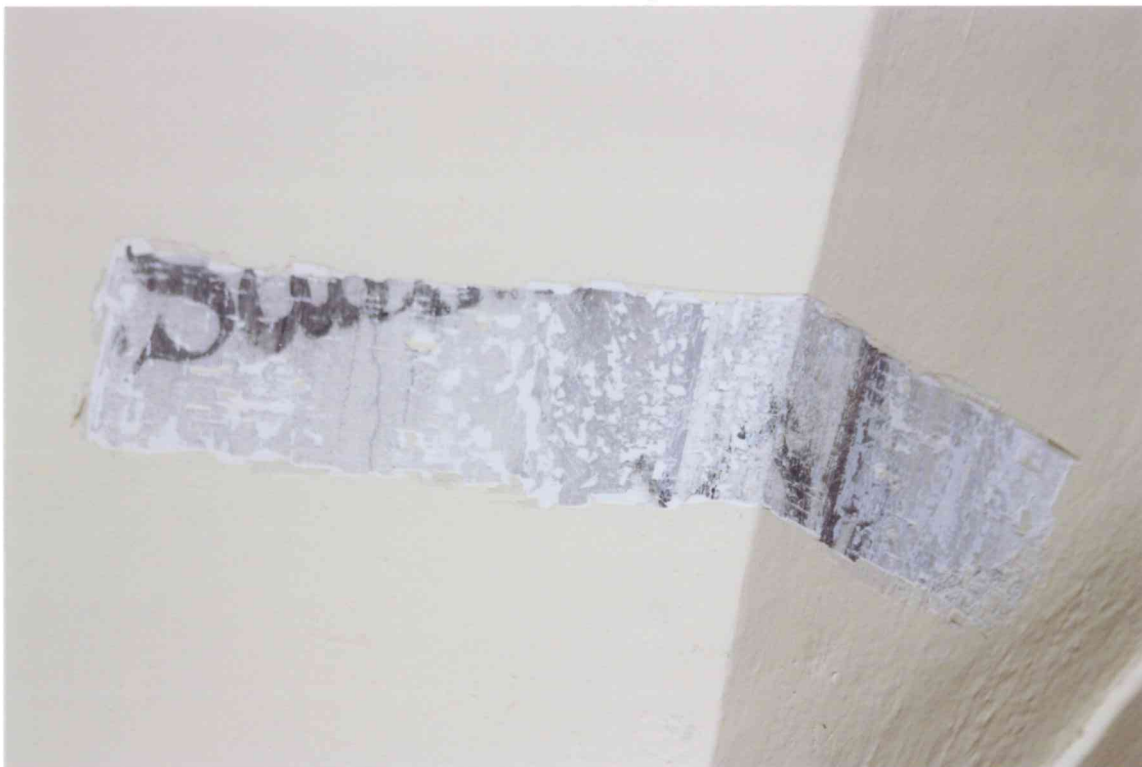
FOT. 33 - Pomieszczenie 1/06, narożnik północno-wschodni, sływ sklepienia, detal fot. 5.
