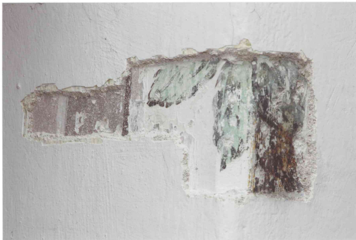
FOT. 16 - Pomieszczenie 1/03, ściana wschodnia, nisza.
