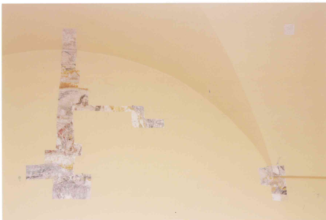
FOT. 6 - Pomieszczenie 1/06, ściana wschodnia, detal fot. 5.
