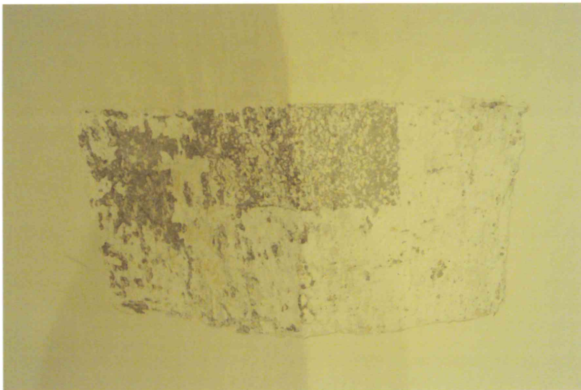
FOT. 9 - Pomieszczenie 1/02, narożnik północno-zachodni, sklepienie, detal fot. 1.
