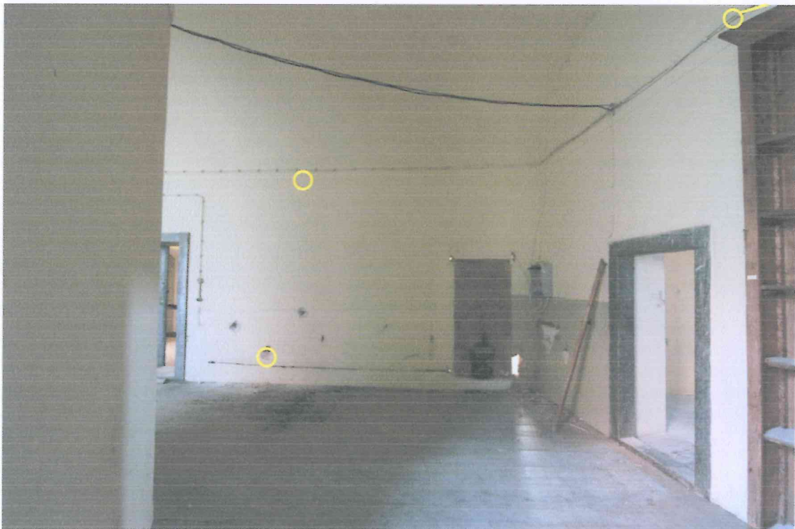
Korytarz 1/K, narożnik północno-zachodni.
