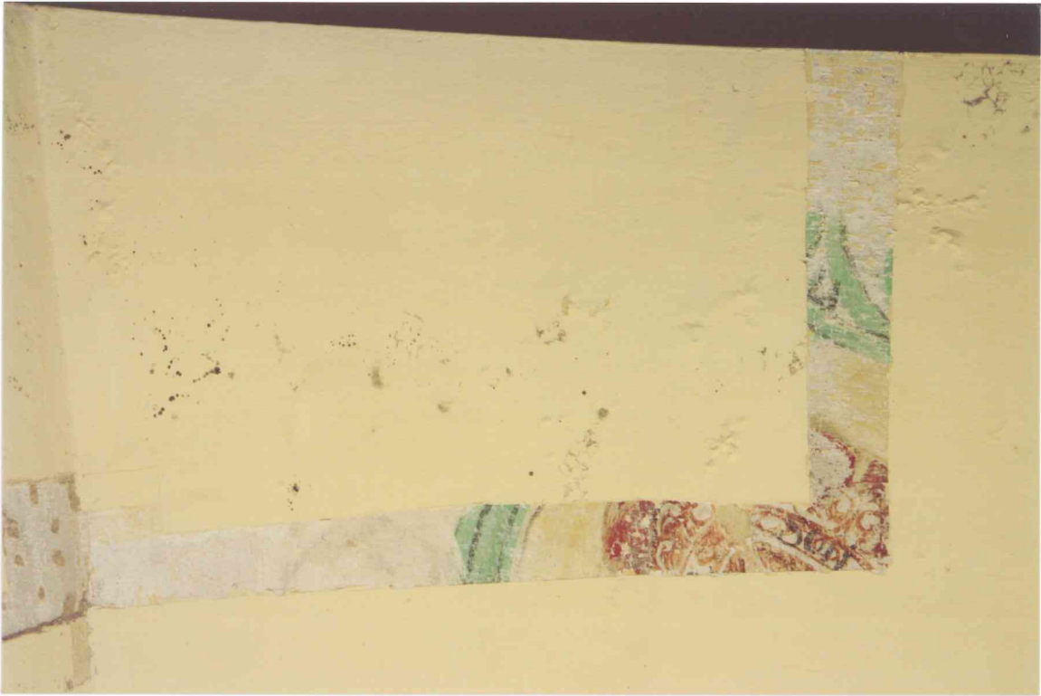
FOT. 29 - Pomieszczenie 1/06, ściana północna, glif okienny, detal fot. 1 i 5.
