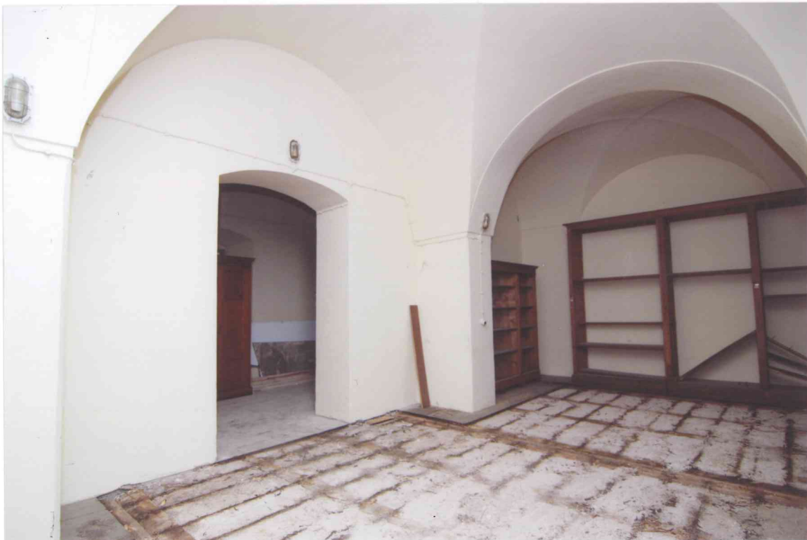
FOT. 2 - Pomieszczenie 1/06, widok narożnika południowo-zachodniego.
