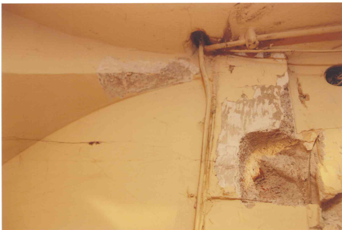
FOT. 15 - Korytarz 1/K , część środkowa, spływ sklepienia.
