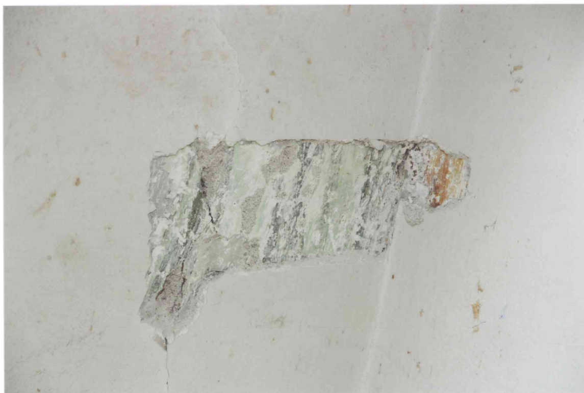
FOT. 14 - Pomieszczenie 1/03, narożnik południowo-wschodni, sklepienie, detal fot. 4.
