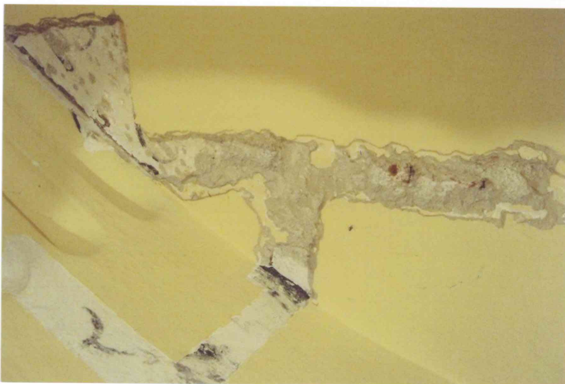
FOT. 18 - Pomieszczenie 1/07, ściana zachodnia pod sklepieniem, detal fot. 4.
