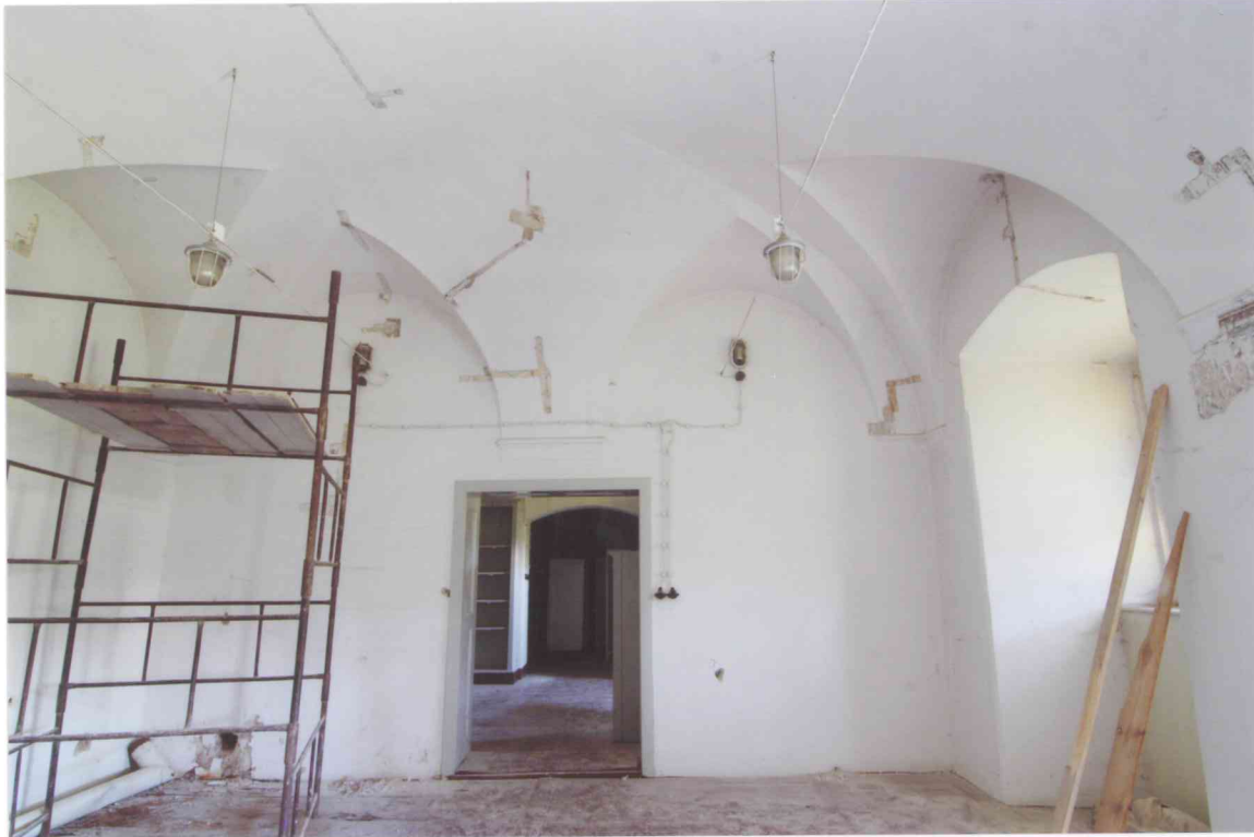
FOT. 1 - Pomieszczenie 1/03, widok ściany południowej.
