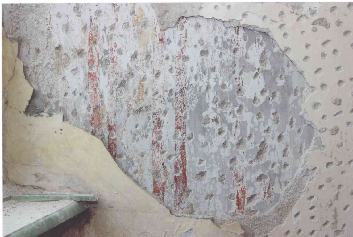
FOT. 10 - Pomieszczenie 1/07, ściana północna glif okienny, detal fot. 1.
