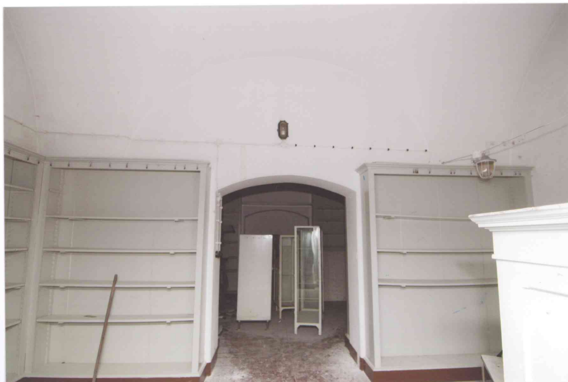
FOT. 2 - Pomieszczenie 1/02, widok ściany południowej.
