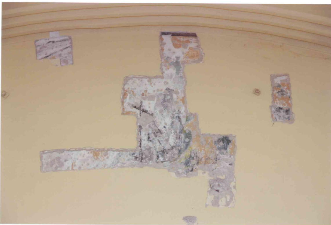
FOT. 17 - Pomieszczenie 1/07, ściana zachodnia, detal fot. 4.
