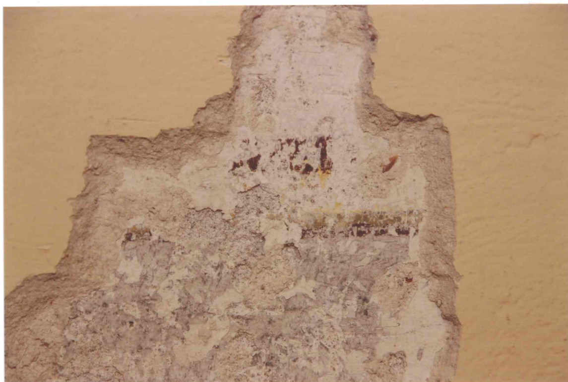
FOT. 19 - Korytarz 1/K , część zachodnia, ściana północna, detal fot. 18.
