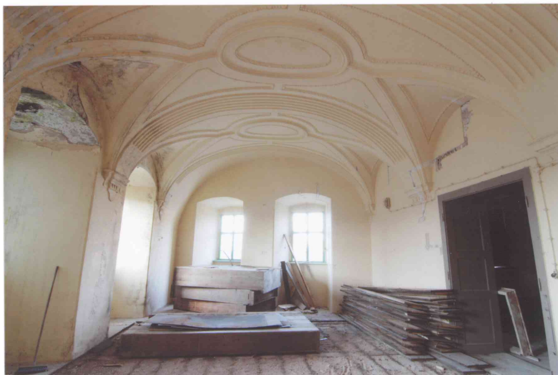
FOT. 2 - Pomieszczenie 1/07, widok ściany wschodniej.
