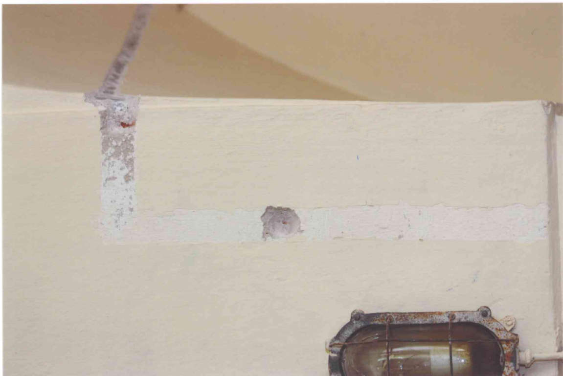
FOT. 32 - Pomieszczenie 1/06, ściana północna, spływ sklepienia w gładzie okiennym, detal fot. 1.
