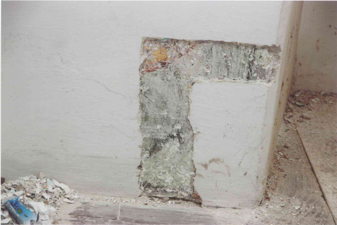
FOT. 11 - Pomieszczenie 1/03, ściana zachodnia, cokół, detal fot. 2.
