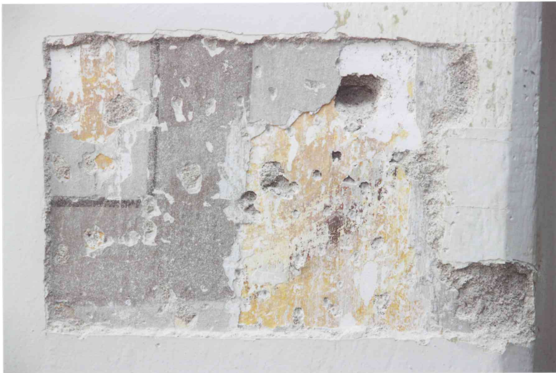
FOT. 15 - Pomieszczenie 1/03, ściana zachodnia, gładz okienny, detal fot. 2.
