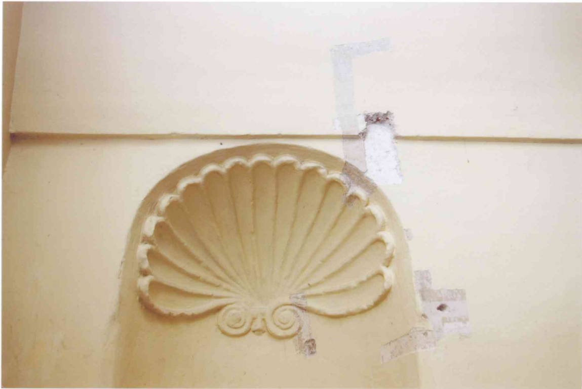
FOT. 5 - Pomieszczenie 1/05, ściana wschodnia, detal fot. 2.
