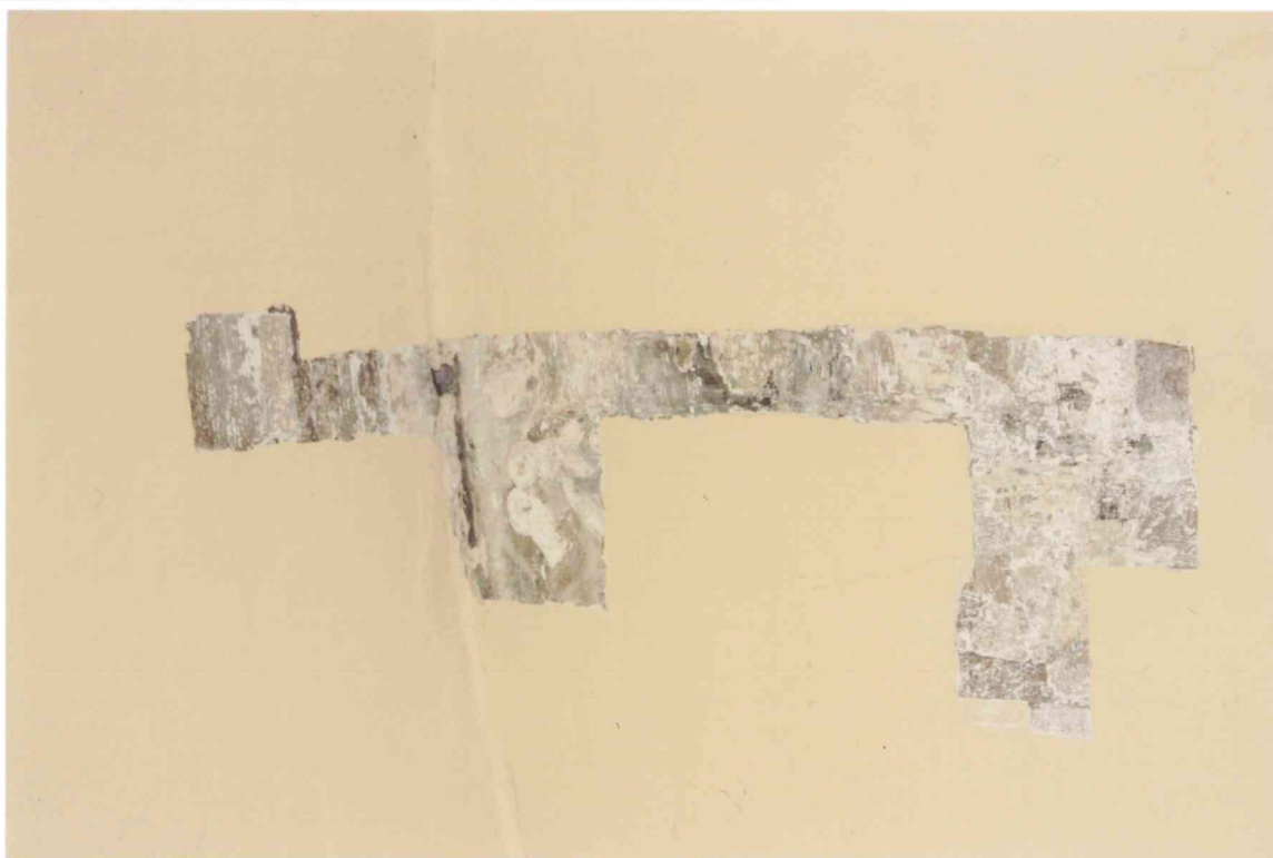
FOT. 14 - Pomieszczenie 1/06, ściana południowa, detal fot. 2.
