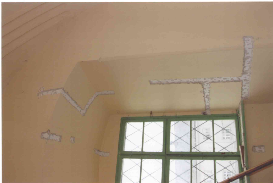
FOT. 11- Pomieszczenie 1/07, ściana wschodnia, glif okienny, detal fot. 2.
