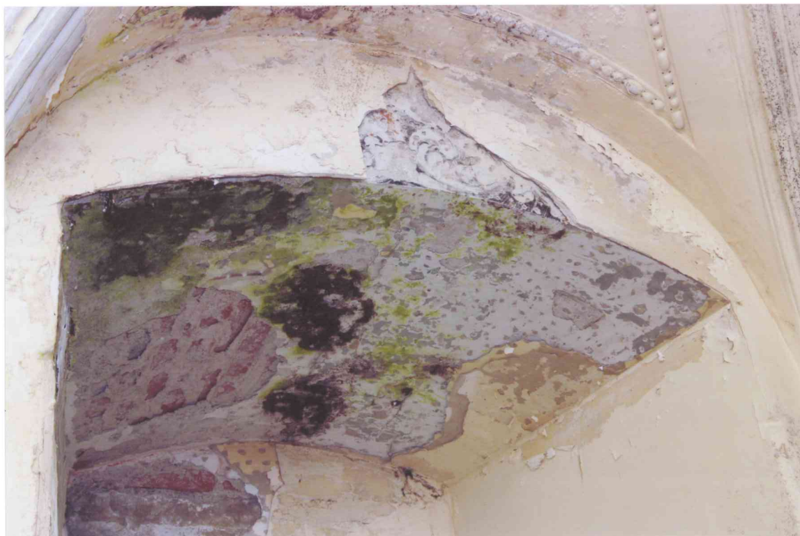
FOT. 9 - Pomieszczenie 1/07, ściana północna, glif okienny, detal fot. 1.
