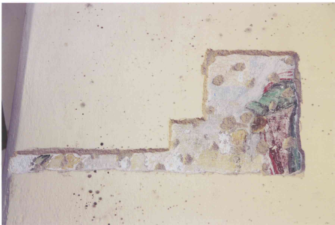
FOT. 26 - Pomieszczenie 1/06, ściana północna, glif okienny, detal fot. 1 i 5.
