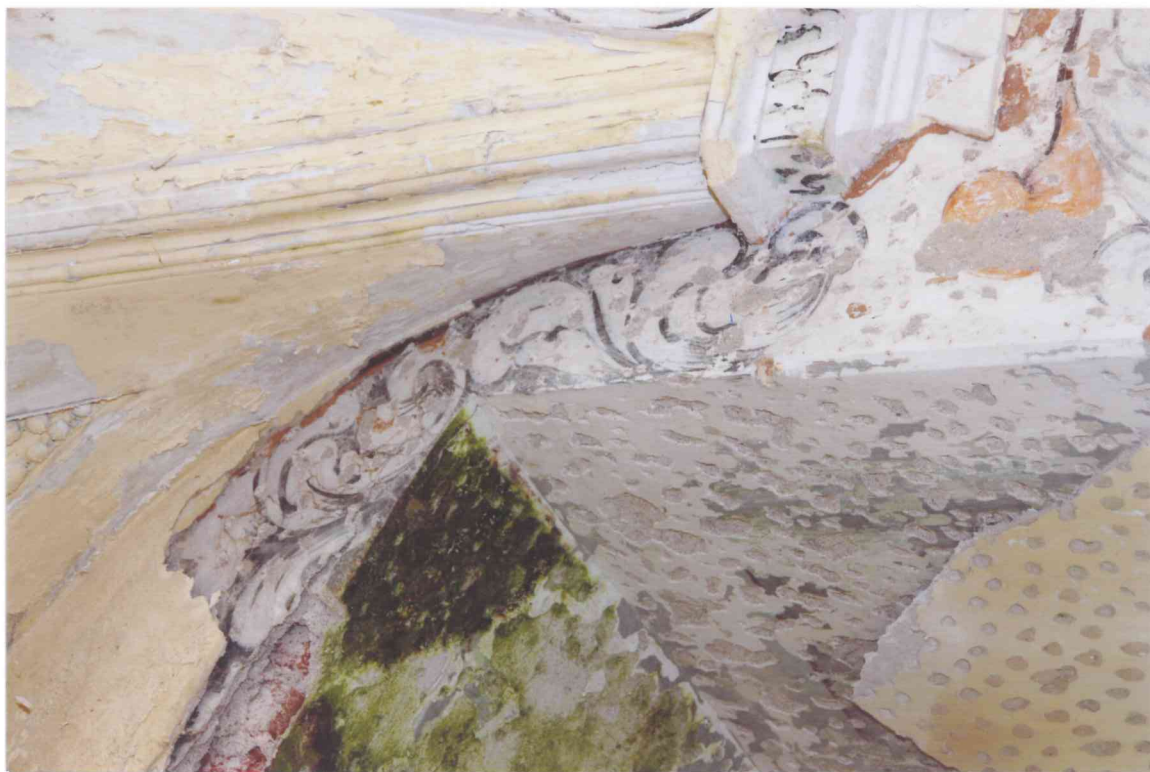
FOT. 6 - Pomieszczenie 1/07, ściana północna, detal fot. 1.
