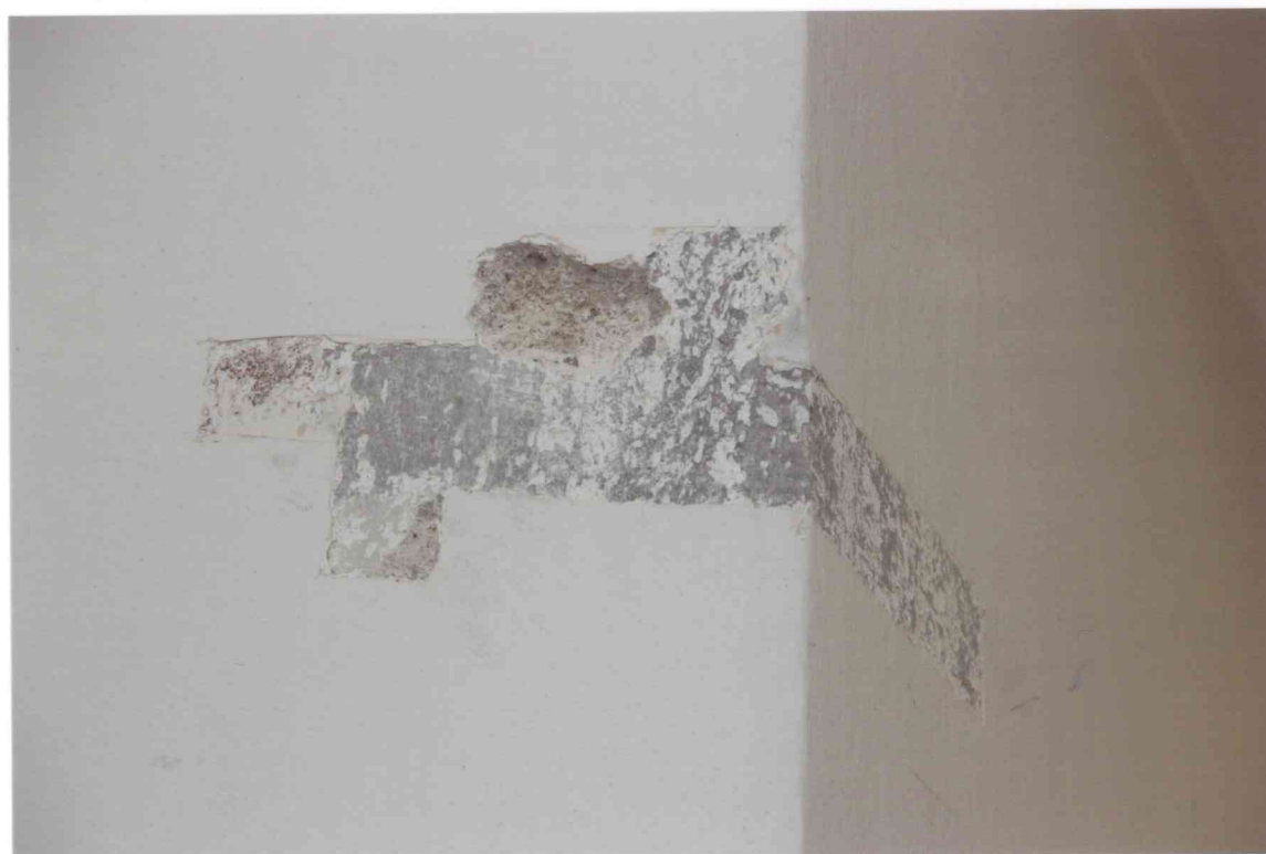
FOT. 6 - Pomieszczenie 1/02, ściana zachodnia, glif okienny.
