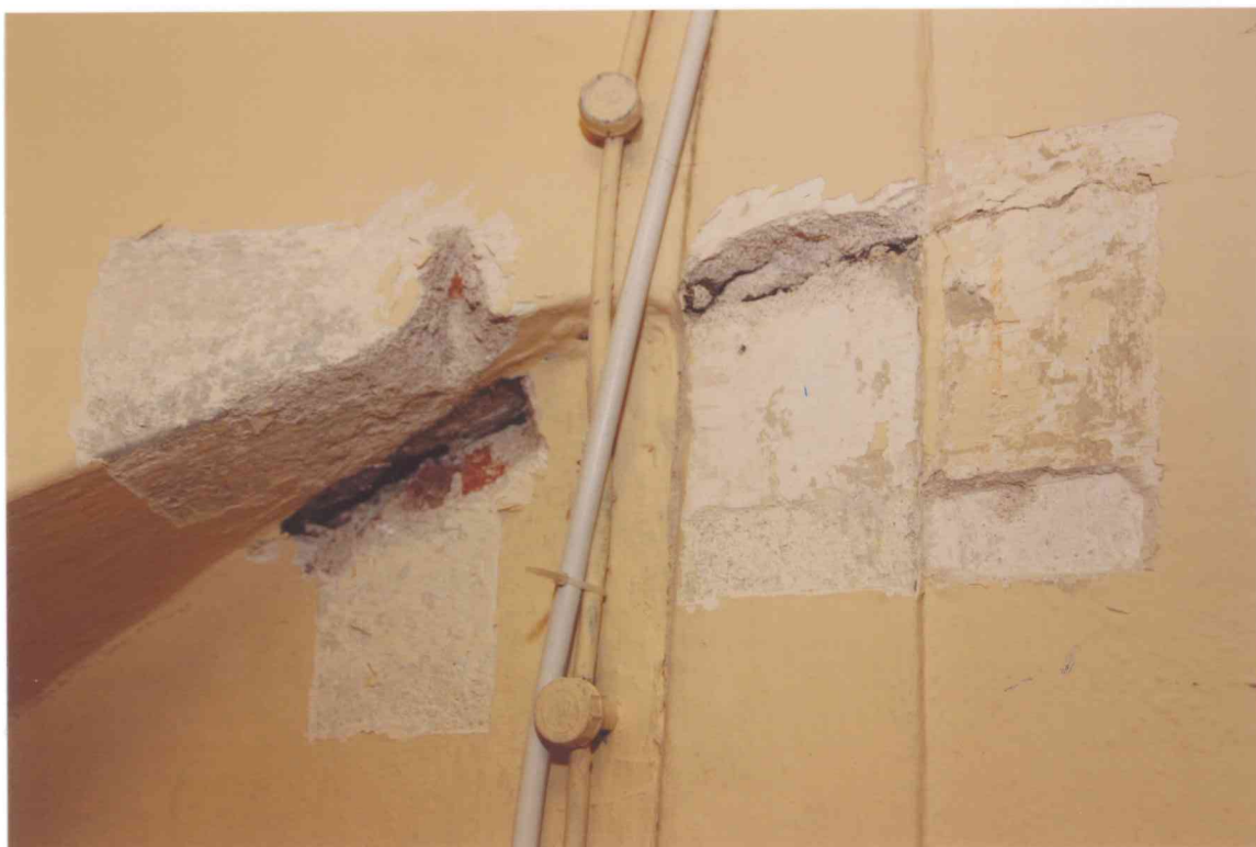
FOT. 14 - Korytarz 1/K , część zachodnia, narożnik północno-zachodni, sływ sklepienia. ←
