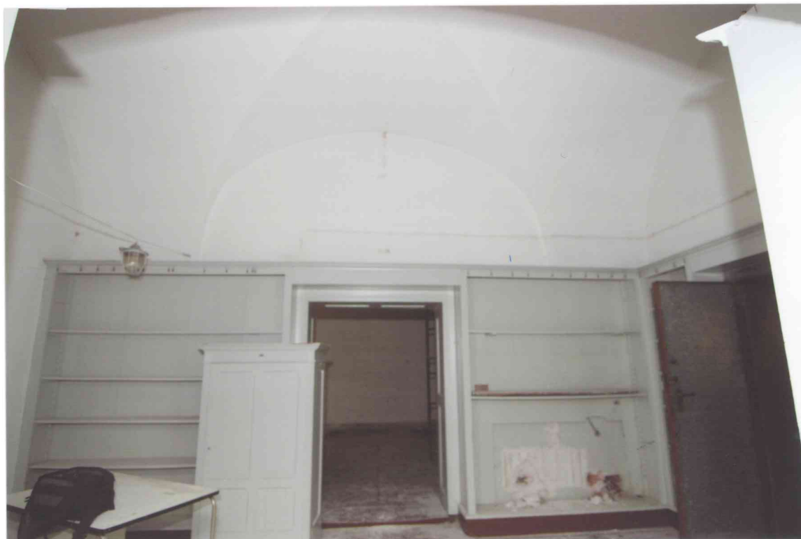
FOT. 4 - Pomieszczenie 1/02, widok ściany północnej.
