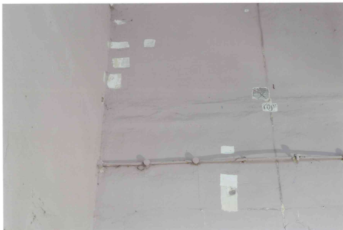
FOT. 24 - Pomieszczenie 0/01-0/K2, narożnik północno-zachodni, detal fot. 5.
