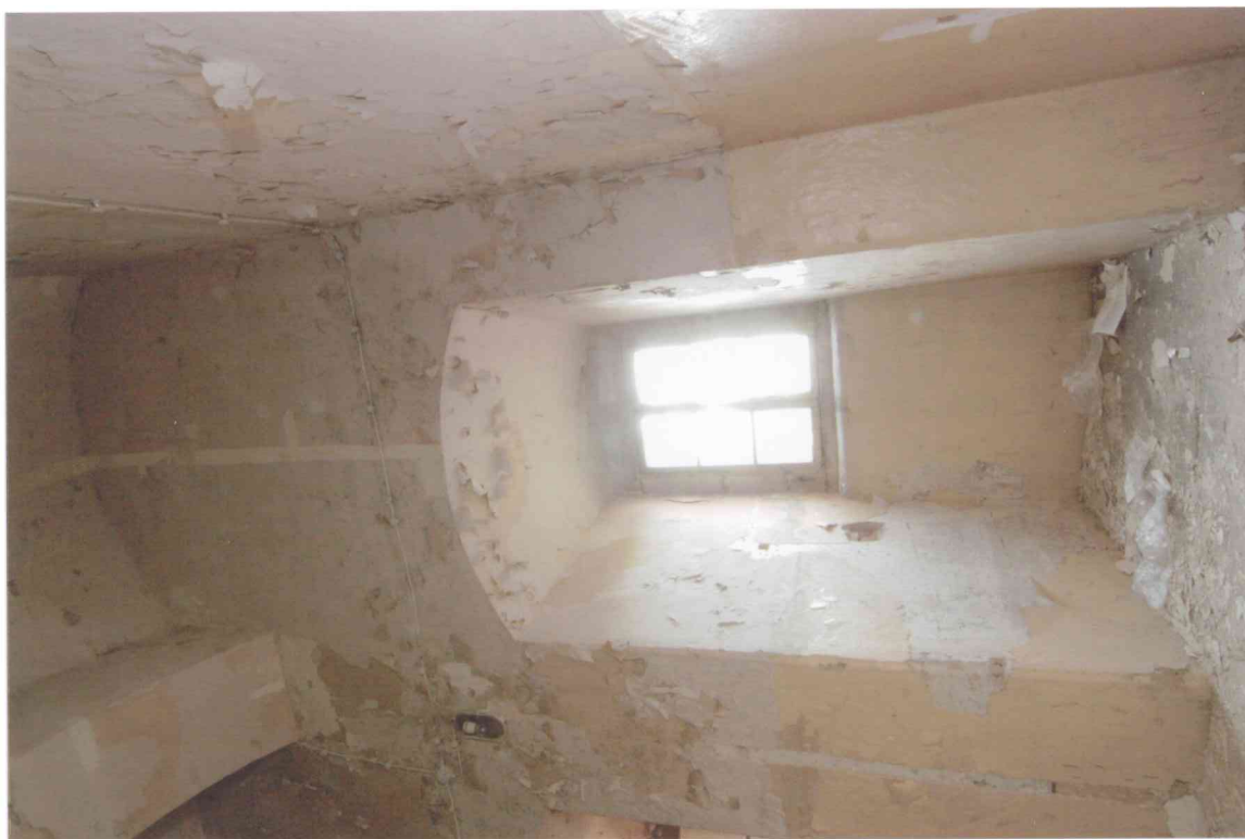
FOT. 3 - Klatka schodowa, północny glif okienny na półpiętrze.
