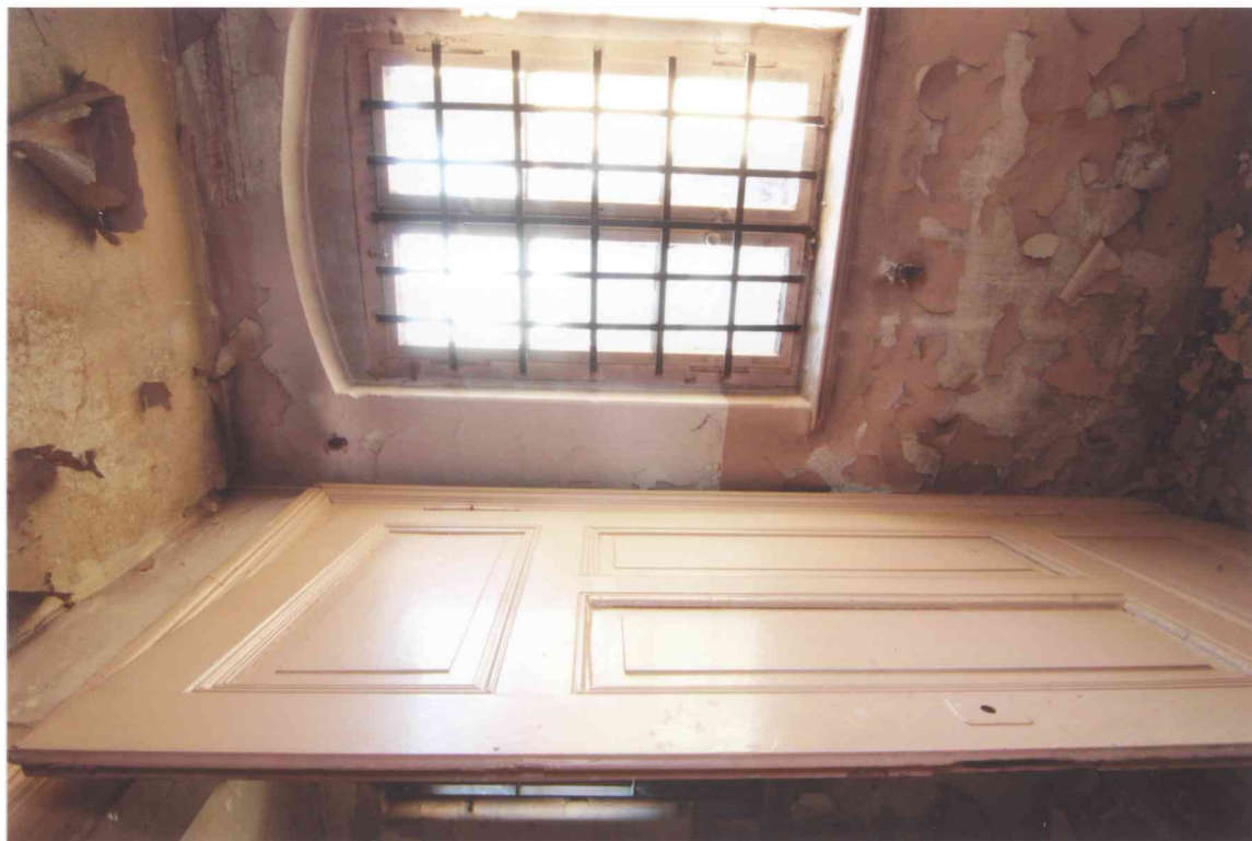
FOT. 5 - Klatka schodowa, półpiętro, ściana północna, wtórne pomieszczenie w glifie okiennym.
