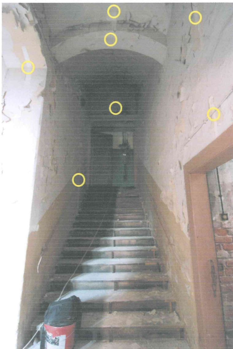
Pom. KL/S – widok na ścianę południową.
