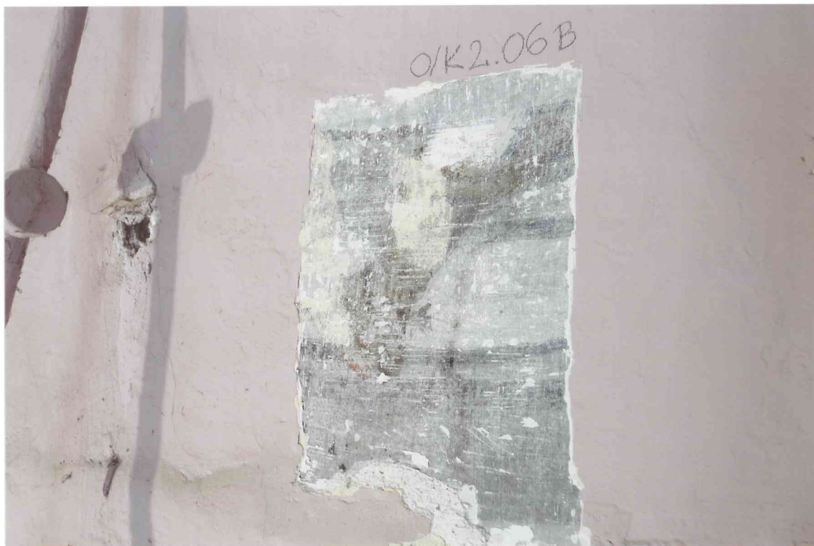
FOT. 29 - Pomieszczenie 0/01-0/K2, detal fot. 26.
