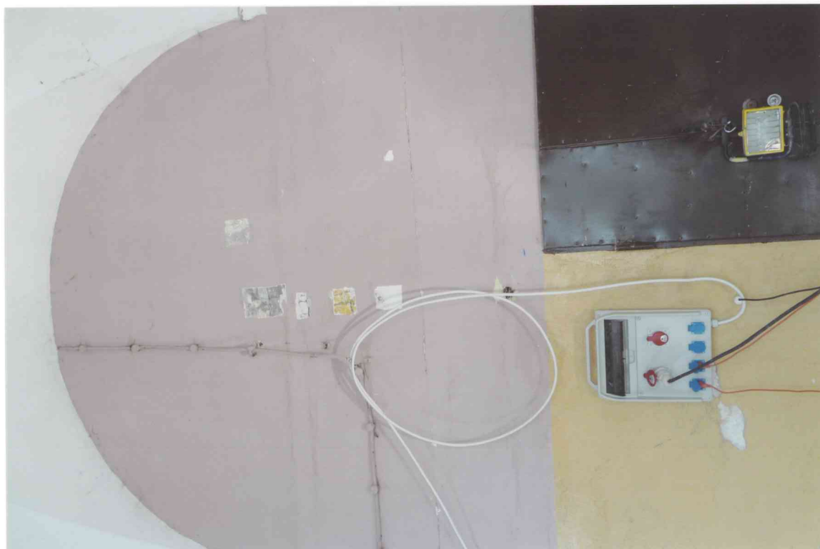
FOT. 26 - Pomieszczenie 0/01-0/K2, ściana północna, detal fot. 3.
