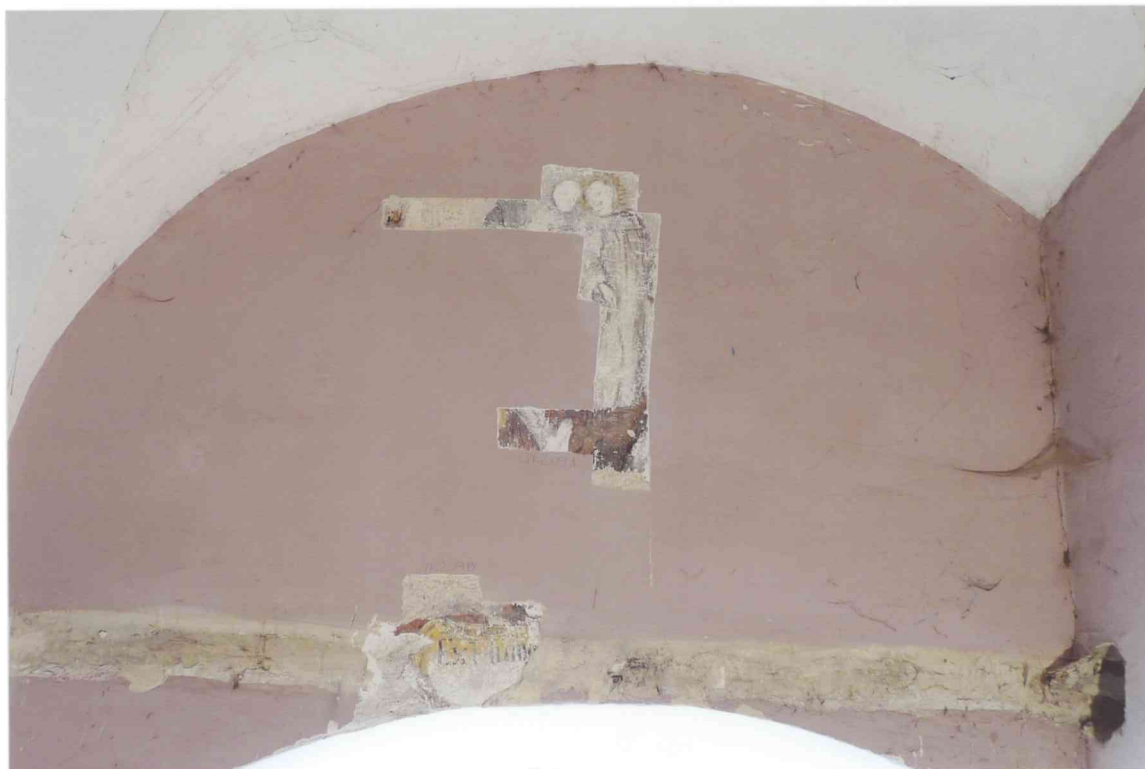
FOT. 20 - Pomieszczenie 0/01-0/K2,, ściana południowa, detal fot. 4.
