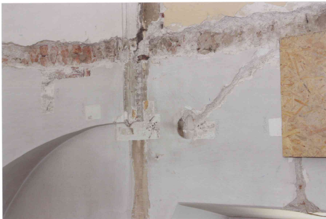
FOT. 12 - Pomieszczenie 0/15, ściana południowa, spływ sklepienia, detal fot. 1.
