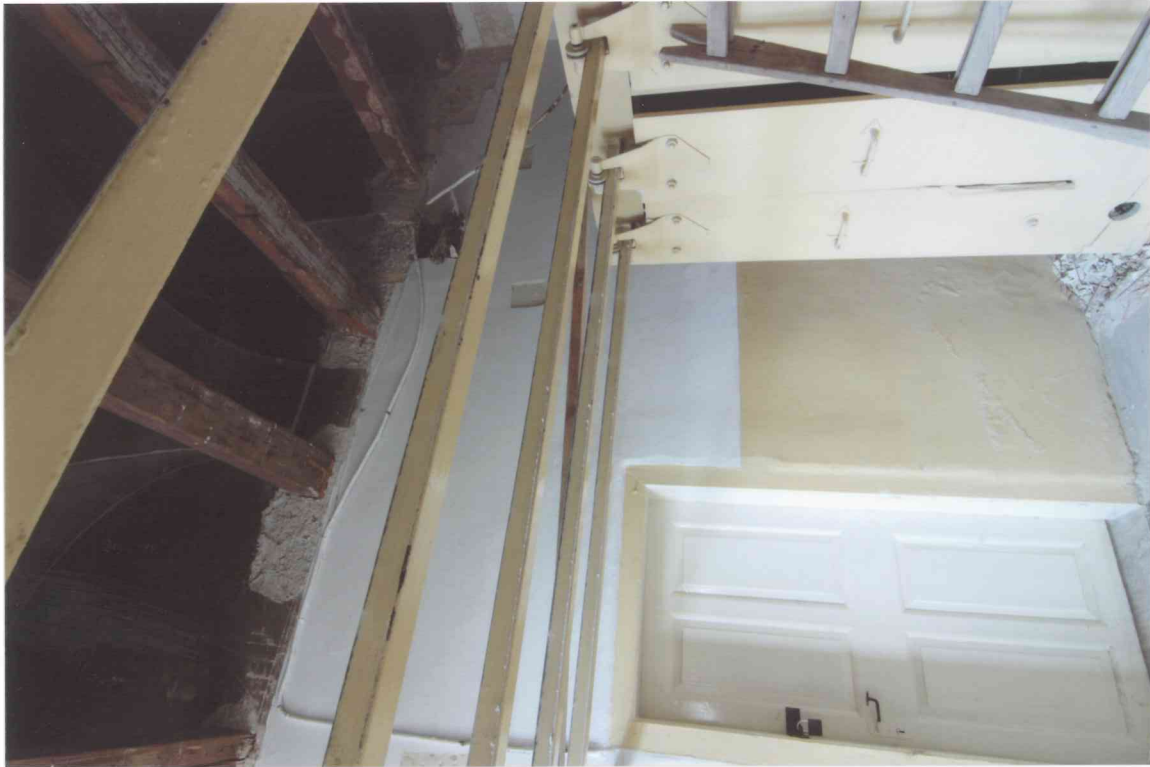
FOT. 3 - Pomieszczenie 0/13, widok ściany wschodniej.
