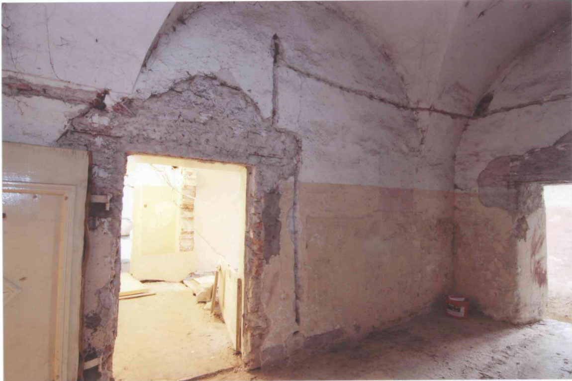
FOT. 3 - Pomieszczenie 0/18-0/19, widok ściany północnej.
