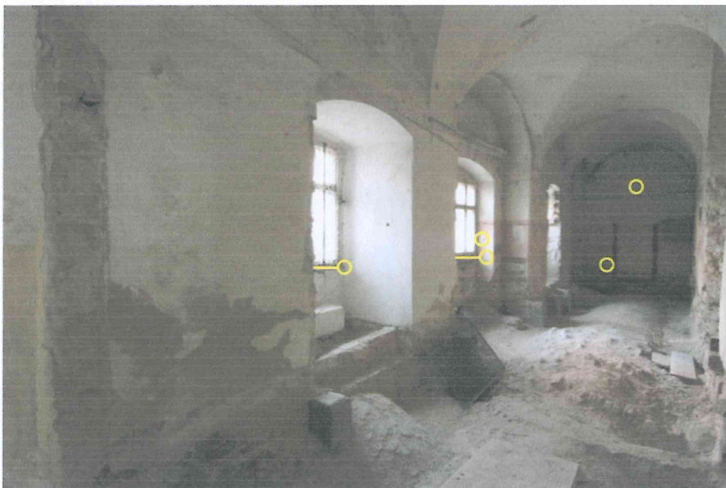
Korytarz 0/K1 – widok na ścianę wschodnią i południową korytarza.
