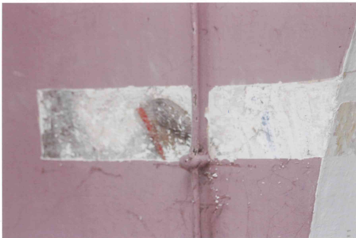
FOT. 8 - Pomieszczenie 0/01-0/K2, detal fot.6.
