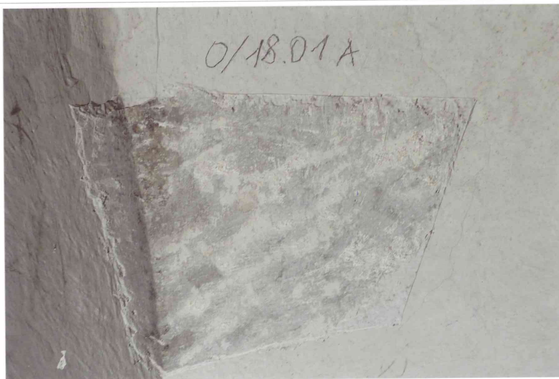
FOT. 6 - Pomieszczenie 0/18-0/19, sklepienie, detal fot. 3.
