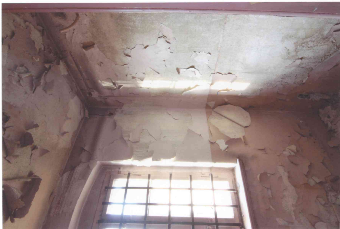
FOT. 6 - Klatka schodowa, półpiętro, ściana północna, wtórne pomieszczenie w glifie okiennym.
