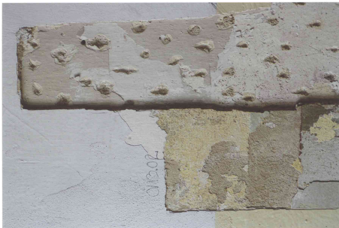
FOT. 14 - Pomieszczenie 0/13, detal fot. 13.
