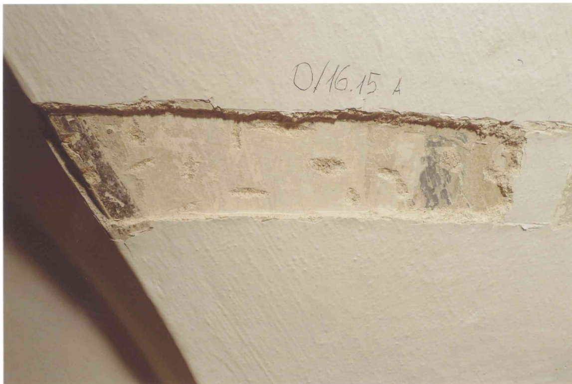
FOT. 9 - Pomieszczenie 0/16, narożnik południowo-wschodni, spływ sklepienia, detal fot. 6.
