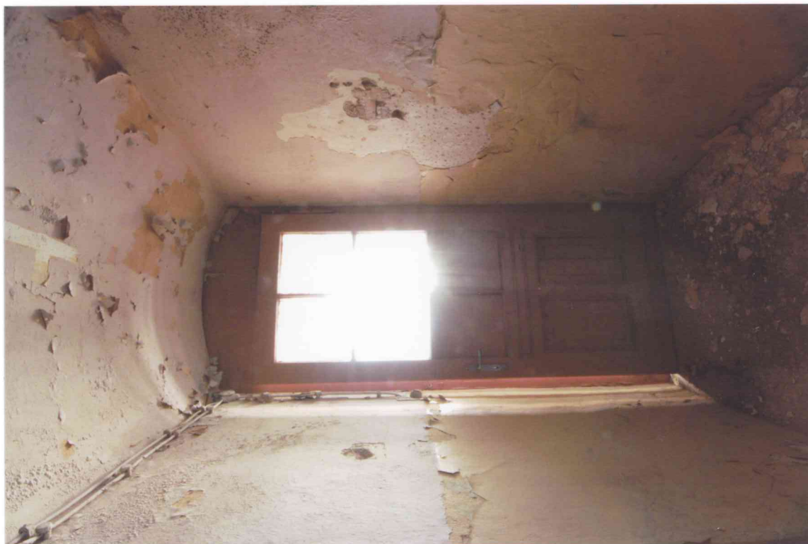
FOT. 4 - Klatka schodowa, ściana północna, drzwi do pomieszczenia wtórnego na półpiętrze.
