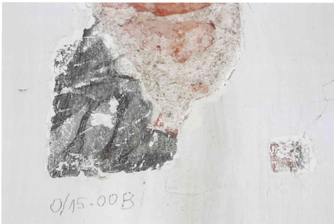
FOT. 15 - Pomieszczenie 0/15, sklepienie, detal fot. 4.
