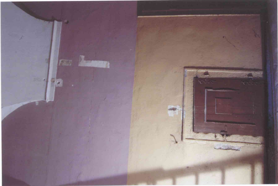
FOT. 33 - Pomieszczenie 0/01-0/K2, ściana północna, detal fot. 4.
