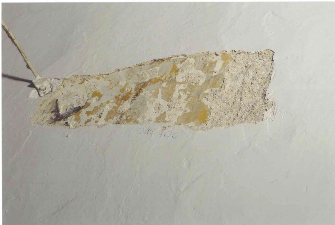
FOT. 14 - Pomieszczenie 0/16, sklepienie, detal fot. 2 i 3.
