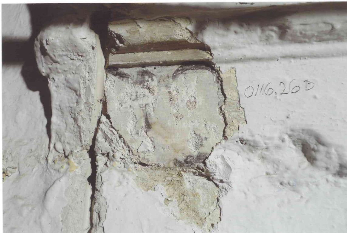
FOT. 16 - Pomieszczenie 0/16, ściana wschodnia, spływ sklepienia, detal fot. 2.
