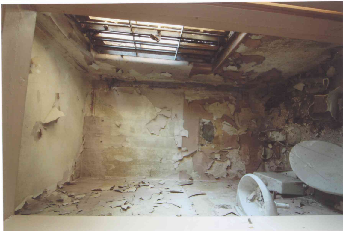
FOT. 8 - Klatka schodowa, półpiętro, ściana północna, wtórne pomieszczenie w glifie okiennym.
