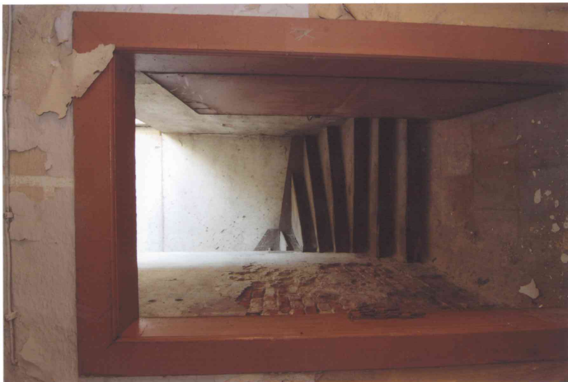
FOT. 9 - Klatka schodowa, półpiętro, ściana zachodnia, wejście na strych.
