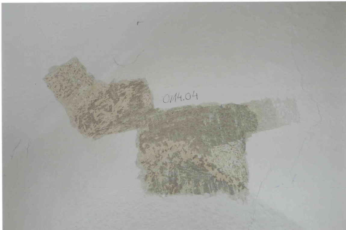
FOT. 6 - Pomieszczenie 0/14, sklepienie, detal fot. 3.
