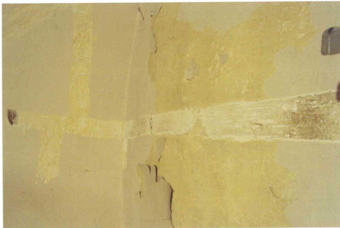
FOT. 13 - Klatka schodowa, sklepienie.
