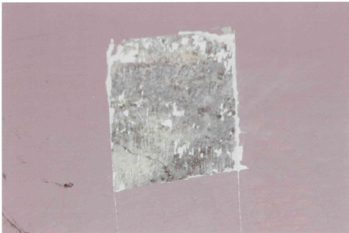
FOT. 7 - Pomieszczenie 0/01-0/K2, detal fot. 6.
