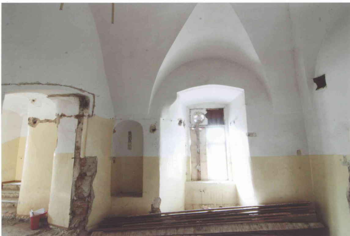
FOT. 2 - Pomieszczenie 0/14, widok ściany północnej.
