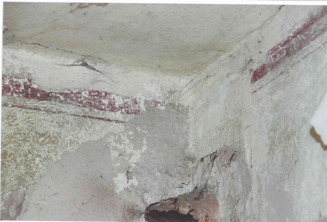
FOT. 12 - Klatka schodowa, wejście na strych.
