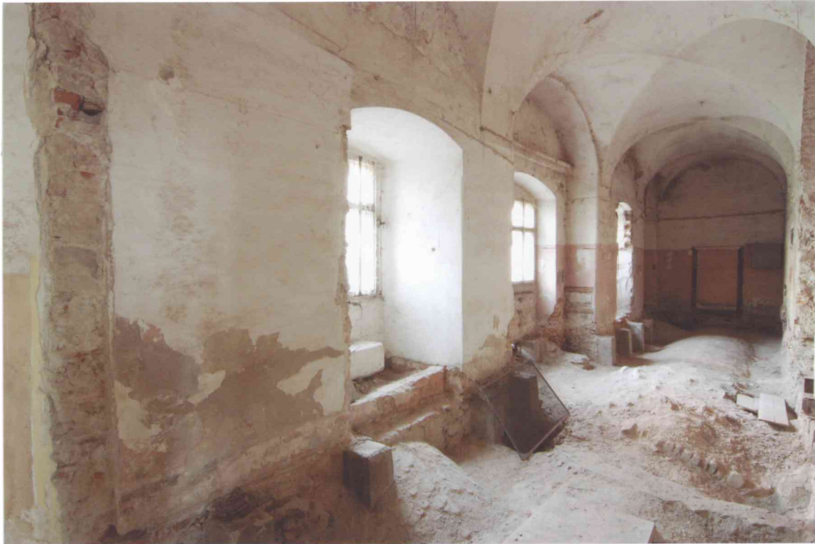
FOT. 3 - Pomieszczenie 0/20-K1, widok ściany wschodniej części wschodniej.
