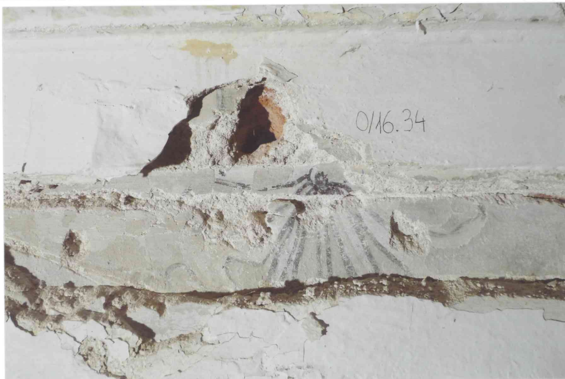
FOT. 18 - Pomieszczenie 0/16, detal fot. 17.
