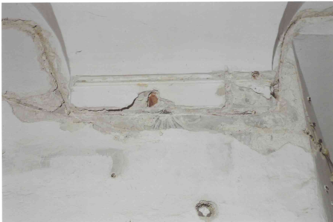
FOT. 17 - Pomieszczenie 0/16, ściana zachodnia, spływ sklepienia, detal fot. 4.
