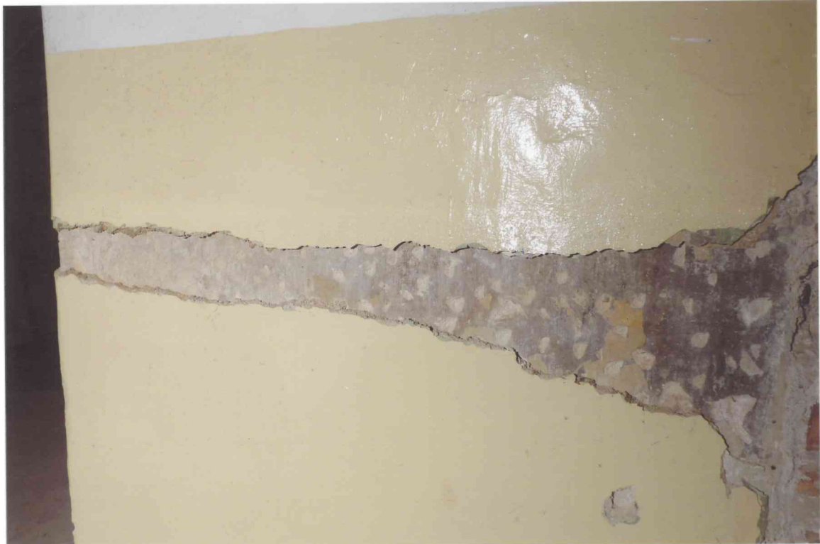
FOT. 26 - Pomieszczenie 0/16, ściana zachodnia, rozglifienie okna, detal fot. 4.
