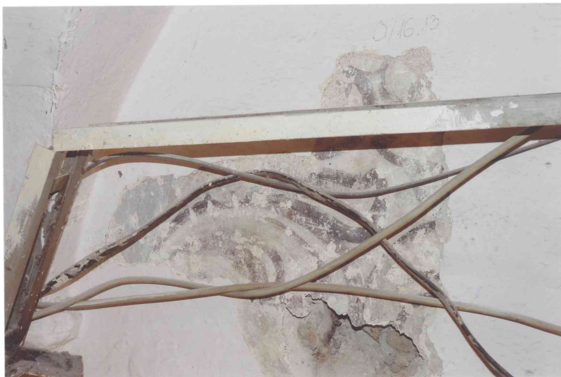
FOT. 10 - Pomieszczenie 0/16, ściana wschodnia przy spływie sklepienia, detal fot.6.
