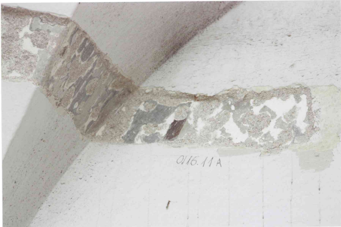
FOT. 21- Pomieszczenie 0/16, część północna ściany wschodniej, detal fot. 2.
