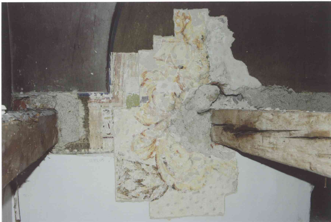
FOT. 5 - Pomieszczenie 0/13, ściana zachodnia i spływ sklepienia.
