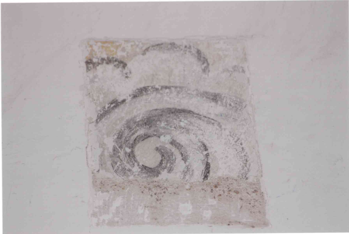
FOT. 18 - Pomieszczenie 0/01-0/K2, ściana południowa, detal fot.4.
