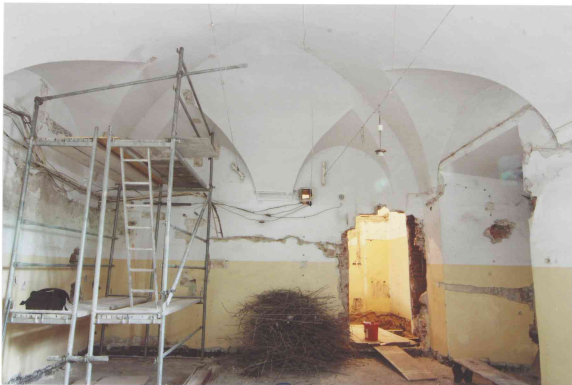
FOT. 5 - Pomieszczenie 0/16, widok ściany południowej.
