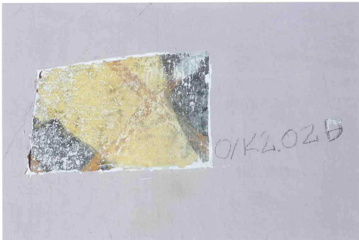
FOT. 13 - Pomieszczenie 0/01-0/K2, detal fot. 9.
