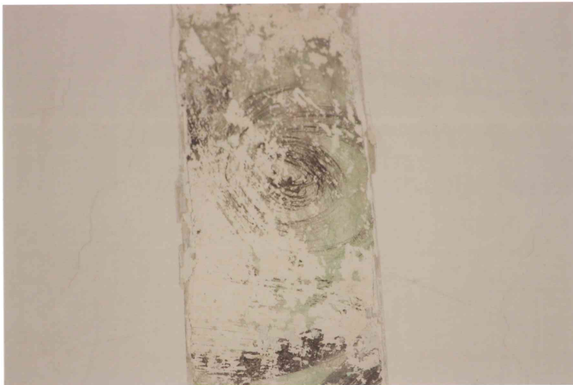
FOT. 25 - Pomieszczenie 0/15, detal fot. 23.
