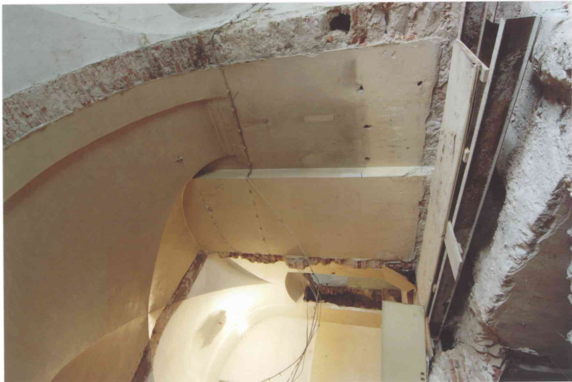
FOT. 8 - Pomieszczenie 0/20-K1, widok ściany północnej części zachodniej.
