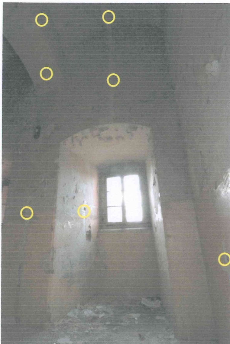
Pom. KL/S – widok na ścianę północną.
