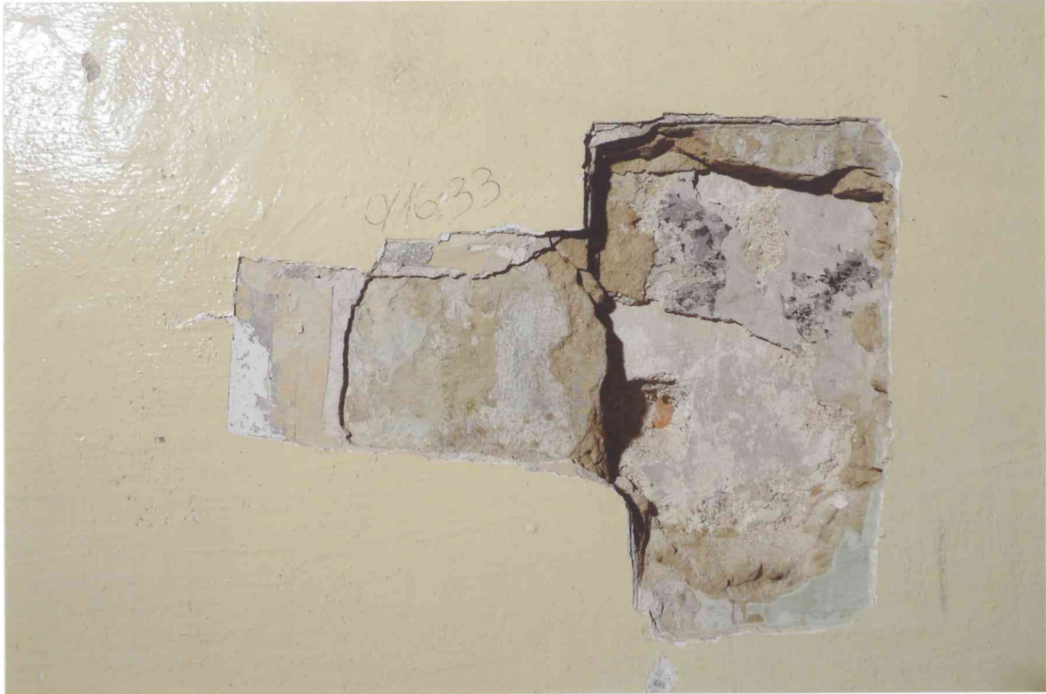
FOT. 25 - Pomieszczenie 0/16, ściana zachodnia, cokół, detal fot. 4.
