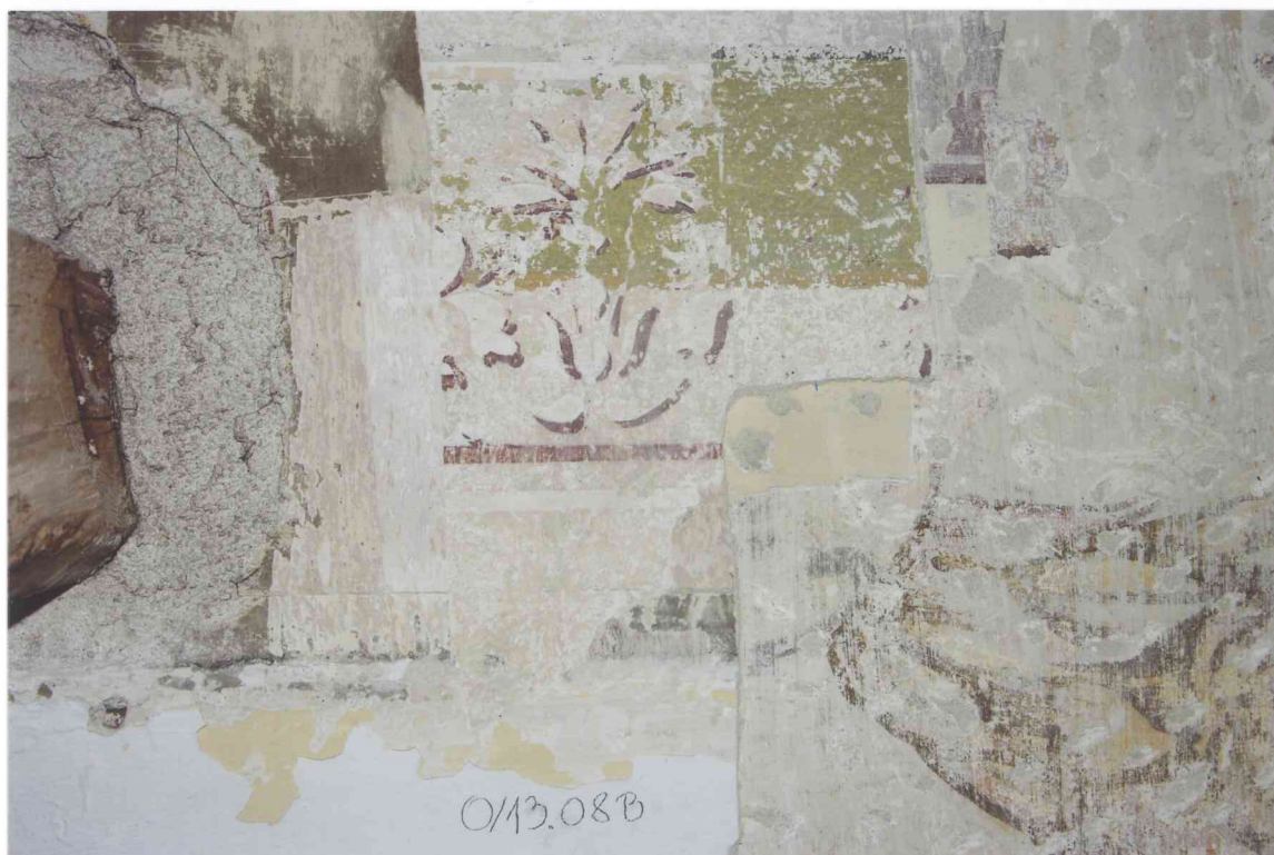
FOT. 8 - Pomieszczenie 0/13, detal fot. 7.
