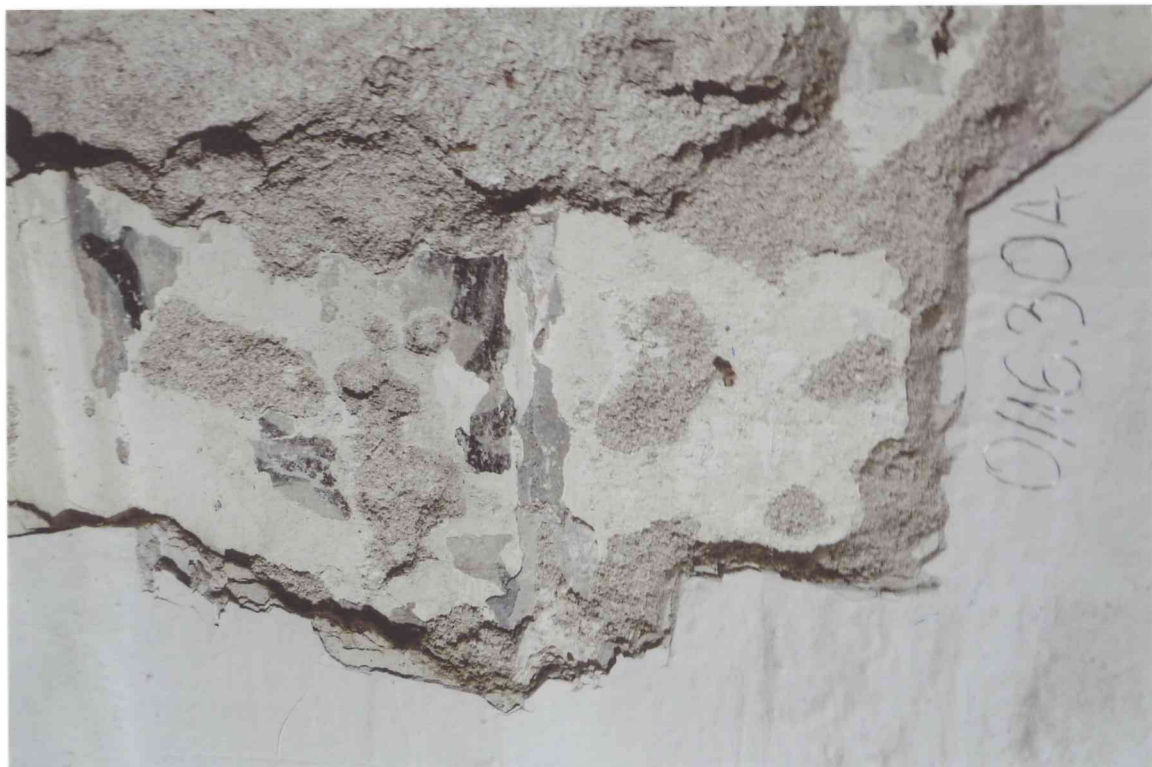
FOT. 22 - Pomieszczenie 0/16, część północna ściany wschodniej, detal fot. 2.
