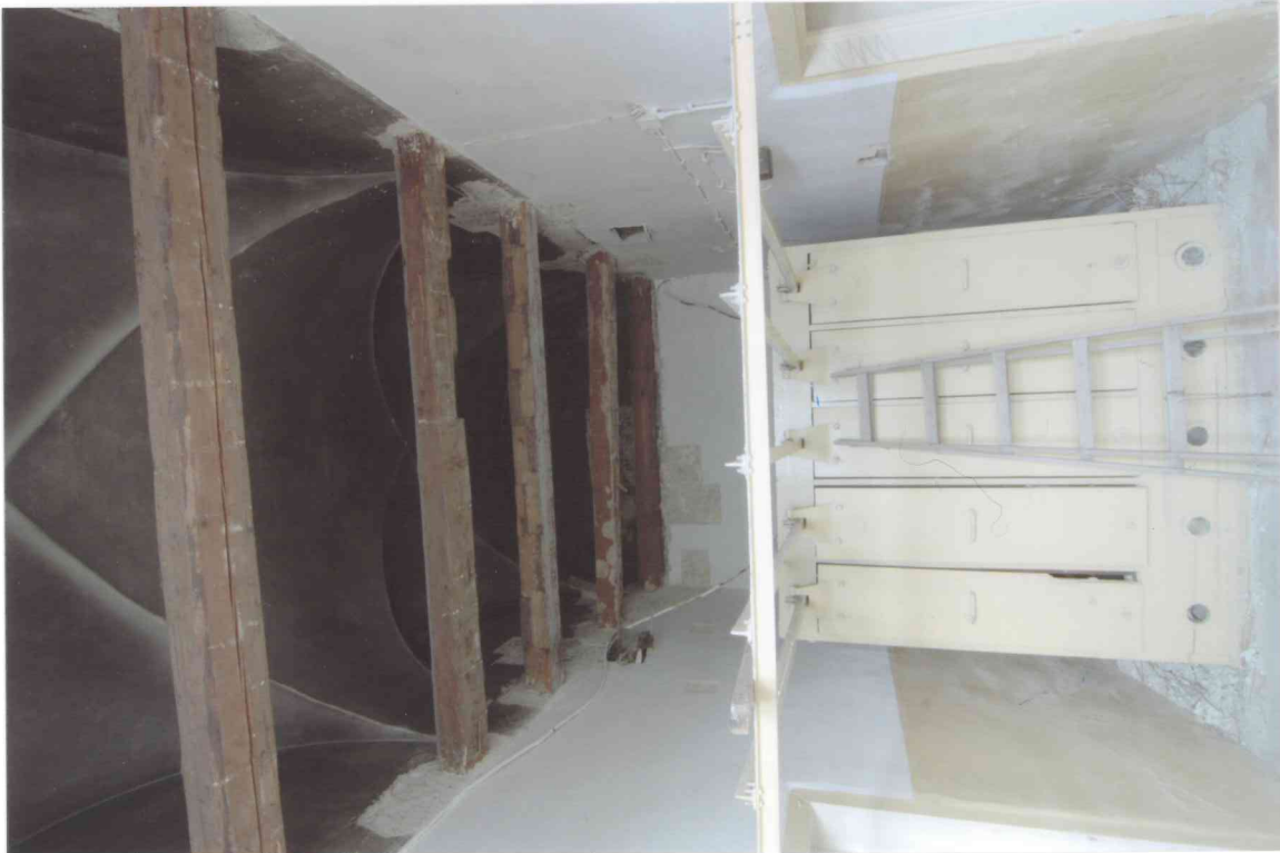
FOT. 2 - Pomieszczenie 0/13, widok ściany południowej.
