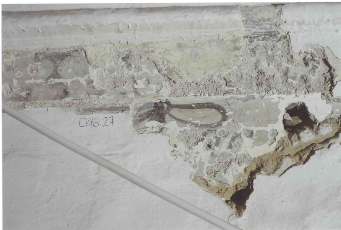
FOT. 19 - Pomieszczenie 0/16, ściana wschodnia, spływ sklepienia, detal fot. 2.
