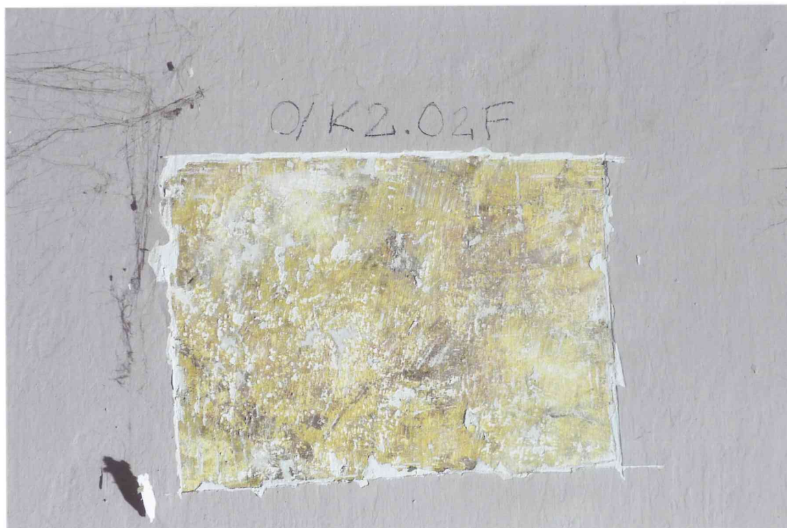
FOT. 14 - Pomieszczenie 0/01-0/K2, detal fot. 9.
