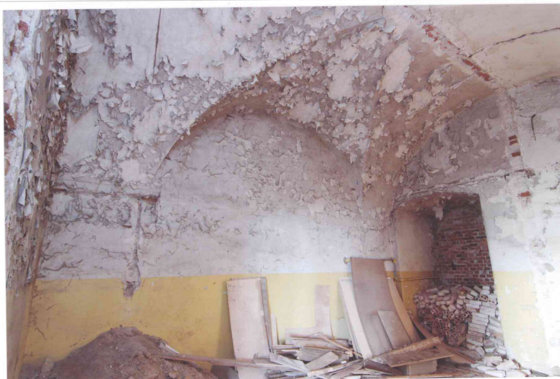
FOT. 2 - Pomieszczenie 0/18-0/19, widok ściany południowej.
