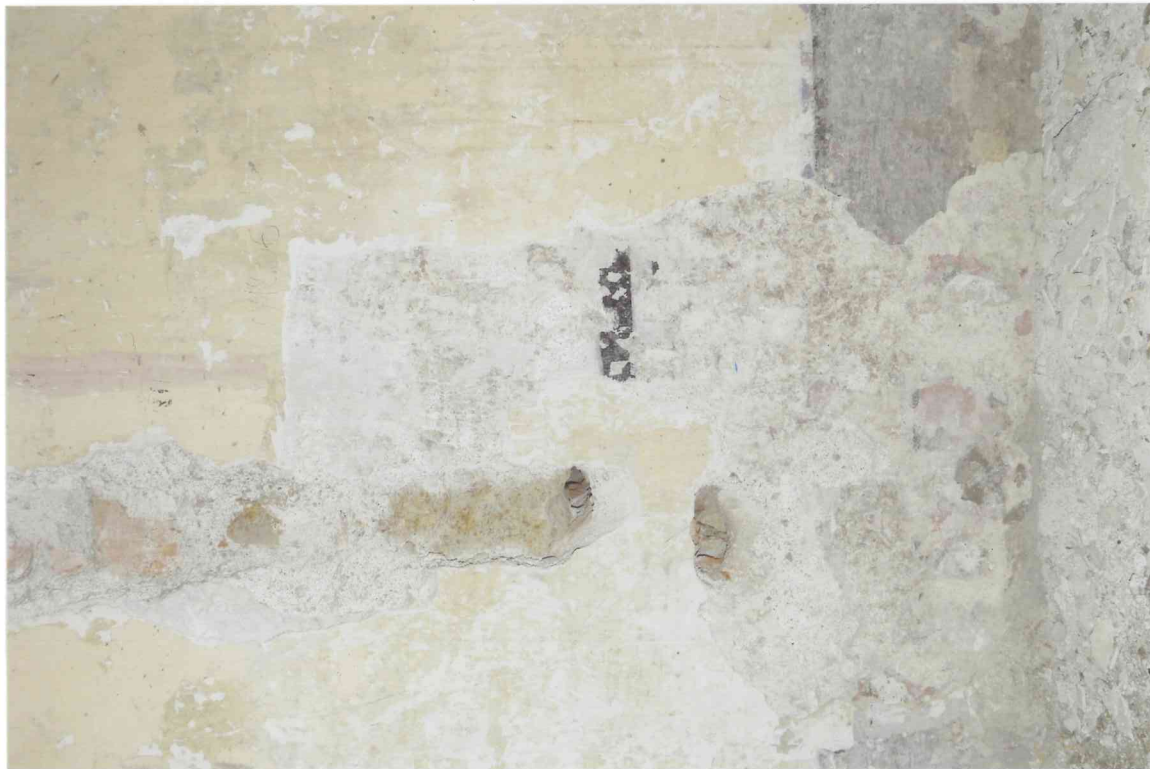
FOT. 4 - Pomieszczenie 0/18-0/19, ściana północna, cokół, detal fot. 3.
