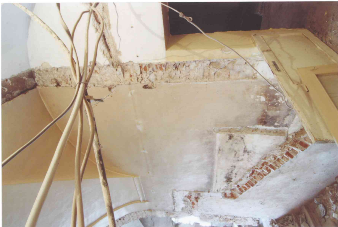
FOT. 9 - Pomieszczenie 0/20-K1, widok ściany południowej części zachodniej.
