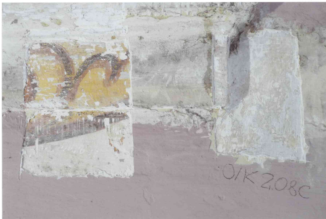
FOT. 19 - Pomieszczenie 0/01-0/K2, ściana południowa, detal fot. 4.
