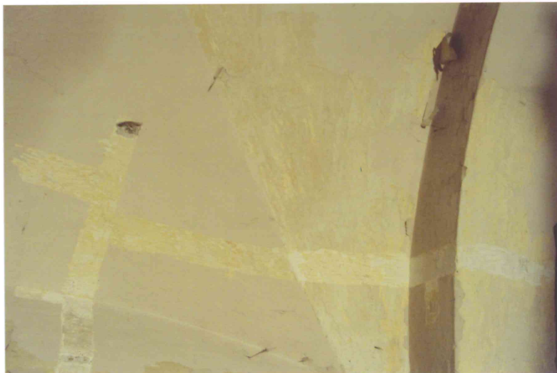
FOT. 14 - Klatka schodowa, sklepienie.
