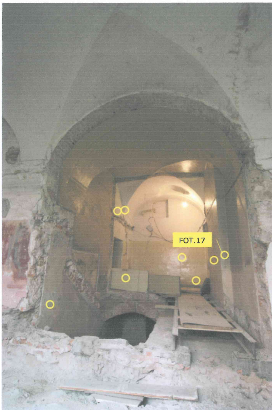
Korytarz 0/K1 – widok na zachodnią część korytarza.
