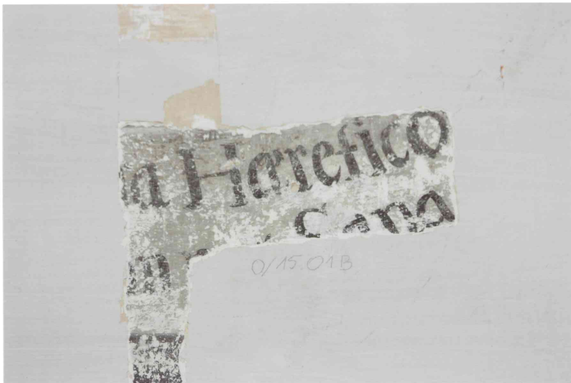
FOT. 17 - Pomieszczenie 0/15, ściana południowa, część wschodnia, detal fot. 4.
