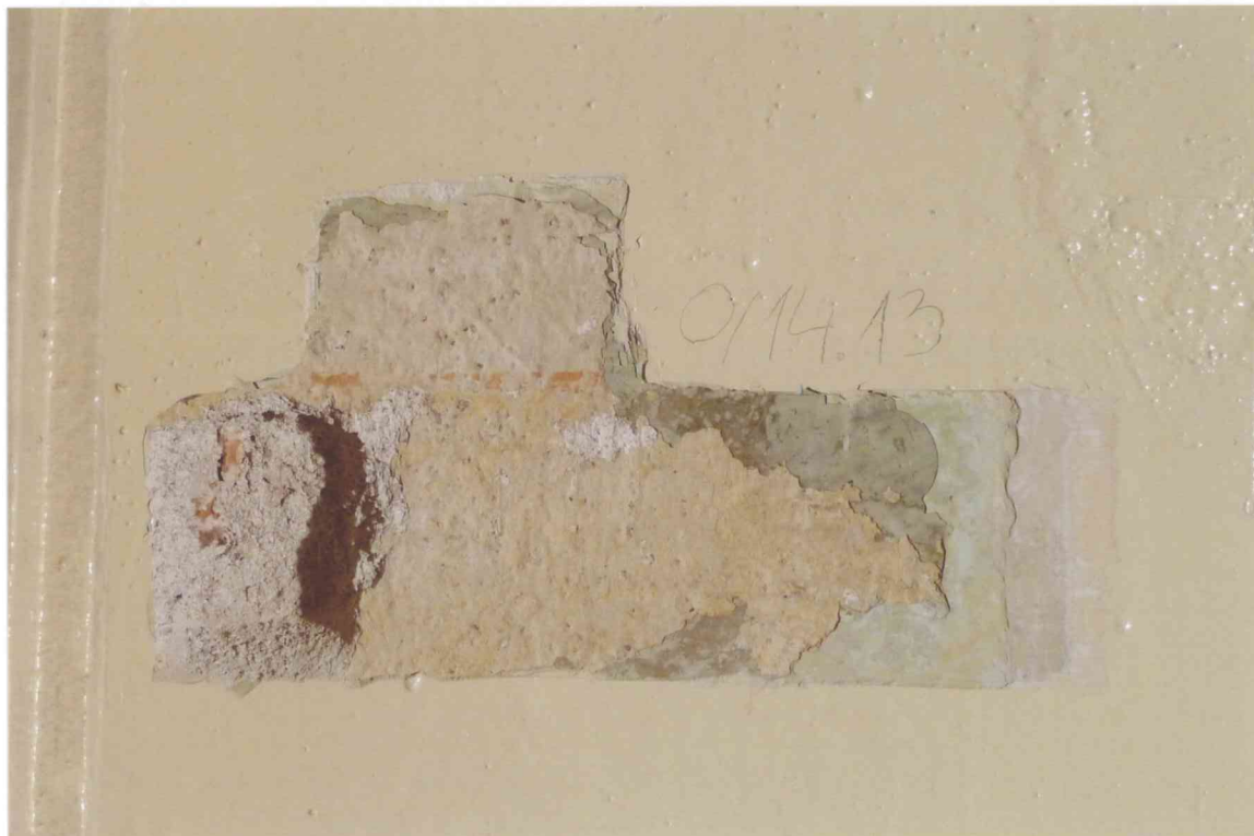
FOT. 10 - Pomieszczenie 0/14, ściana zachodnia, detal fot. 1.
