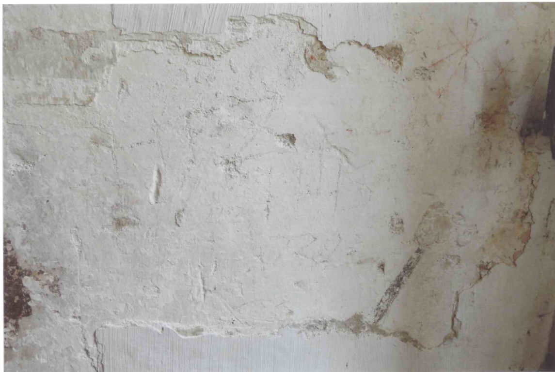
FOT. 19 - Pomieszczenie 0/20-K1, część wschodnia, ściana wschodnia, glif okienny.
