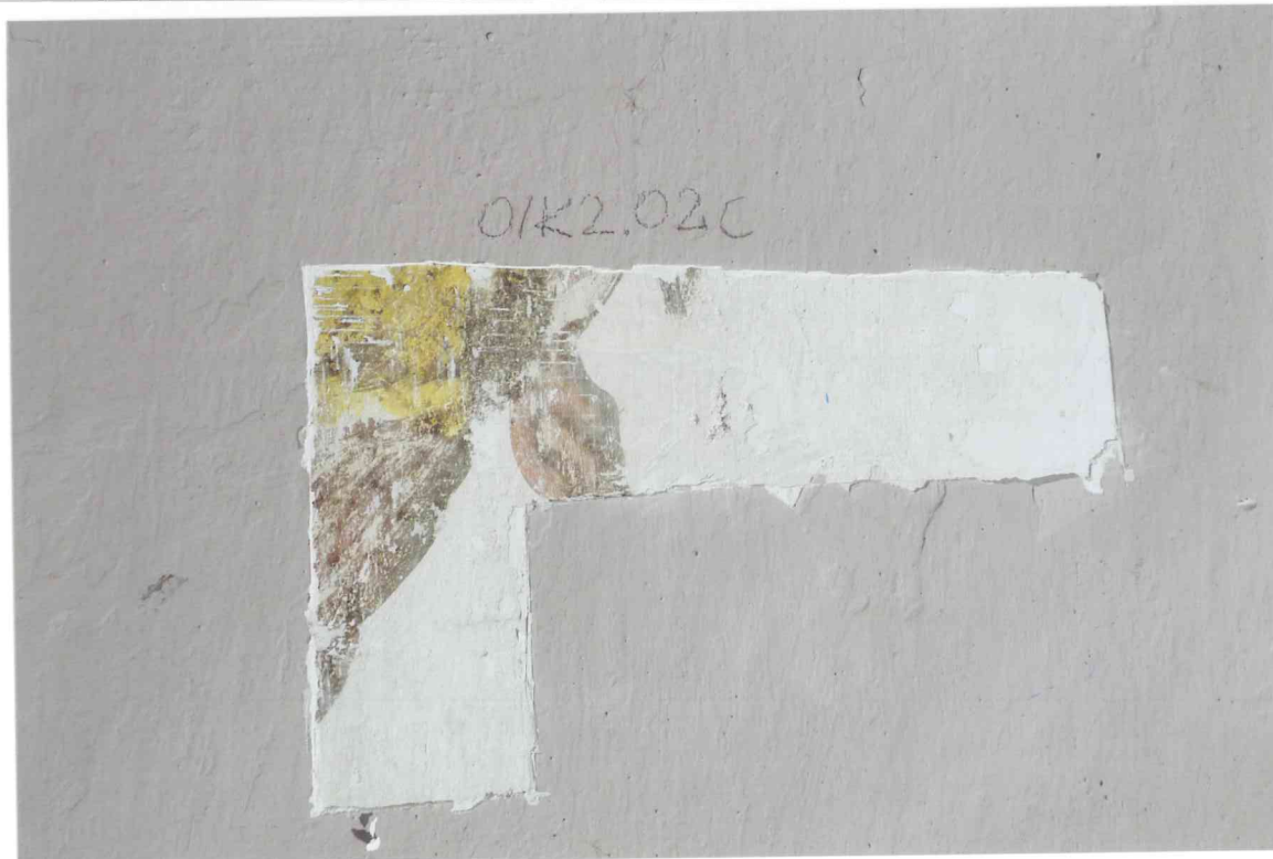
FOT. 10 - Pomieszczenie 0/01-0/K2, detal fot. 9.
