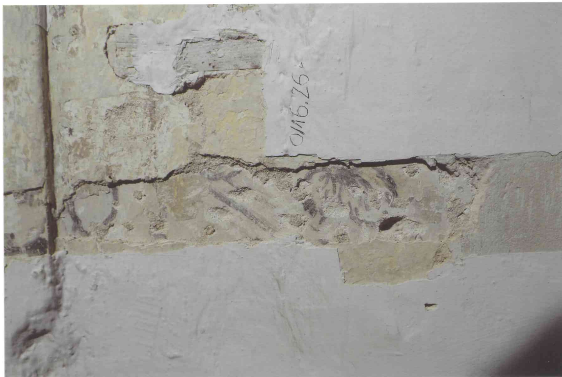
FOT. 15 - Pomieszczenie 0/16, ściana wschodnia, spływ sklepienia, detal fot. 2.
