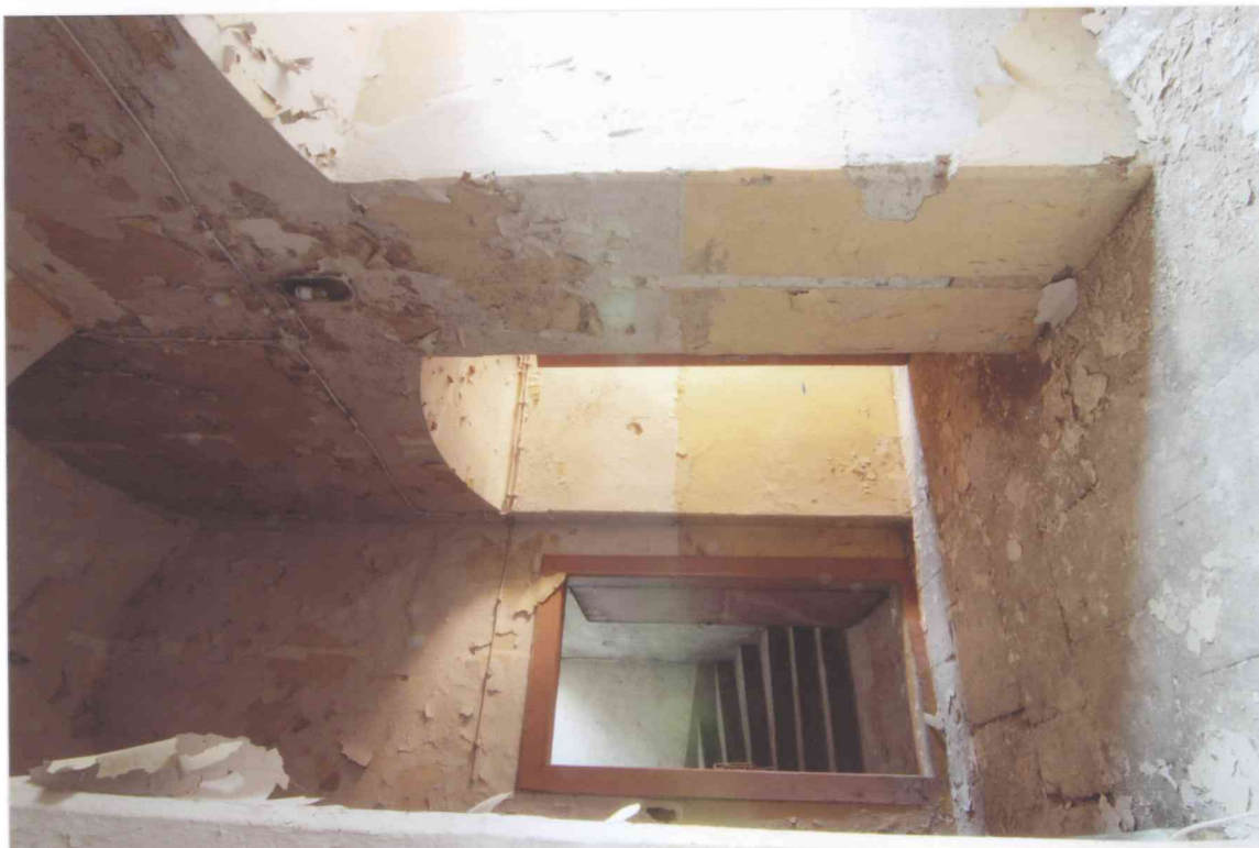
FOT. 2 - Klatka schodowa, widok półpiętra.
