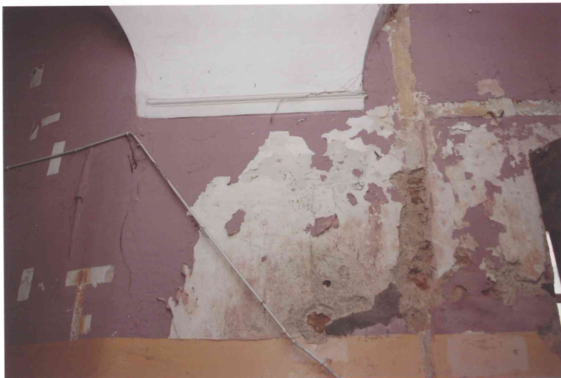
FOT. 16 - Pomieszczenie 0/01-0/K2, ściana południowa, detal fot. 2.
