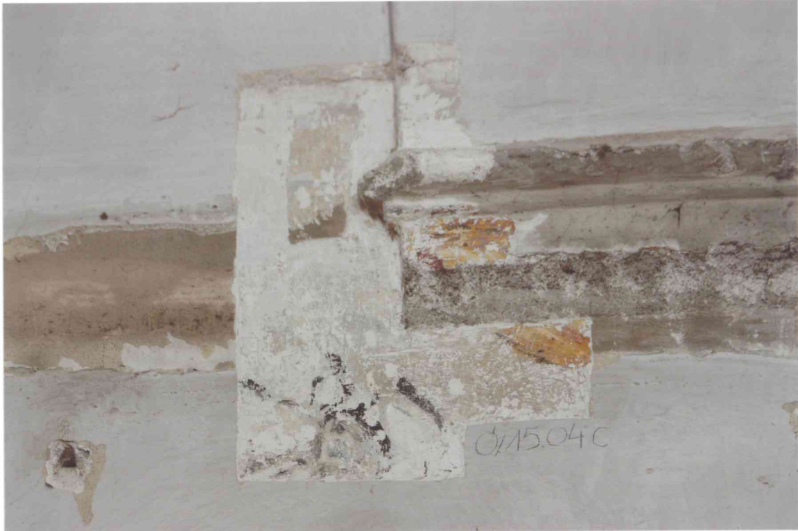
FOT. 13 - Pomieszczenie 0/15, detal fot. 12.
