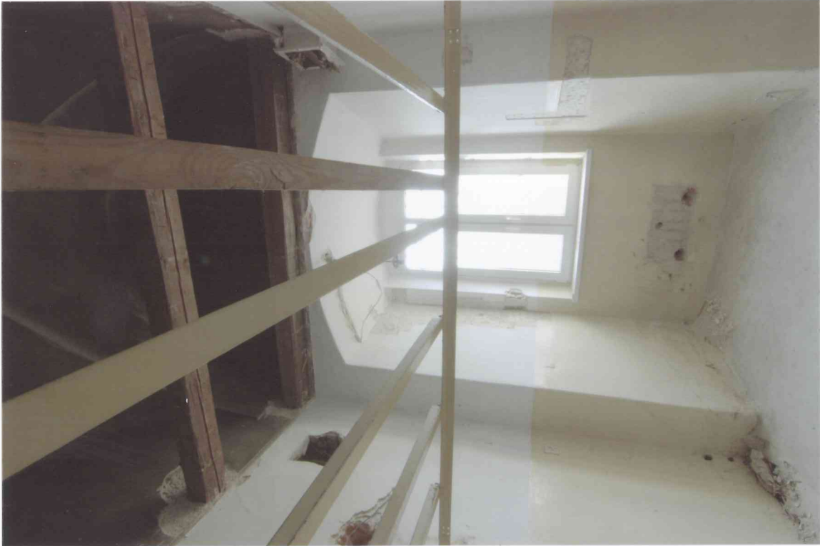
FOT. 1 - Pomieszczenie 0/13, widok ściany północnej.
