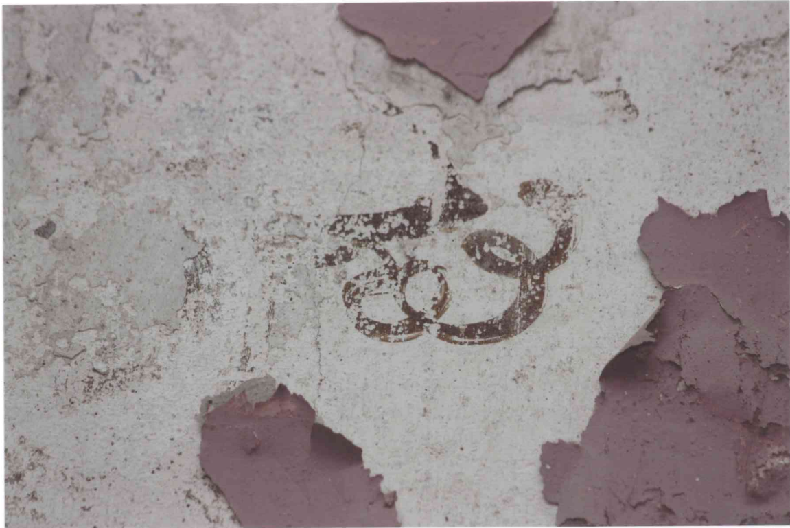
FOT. 17 - Pomieszczenie 0/01-0/K2, detal fot. 16.
