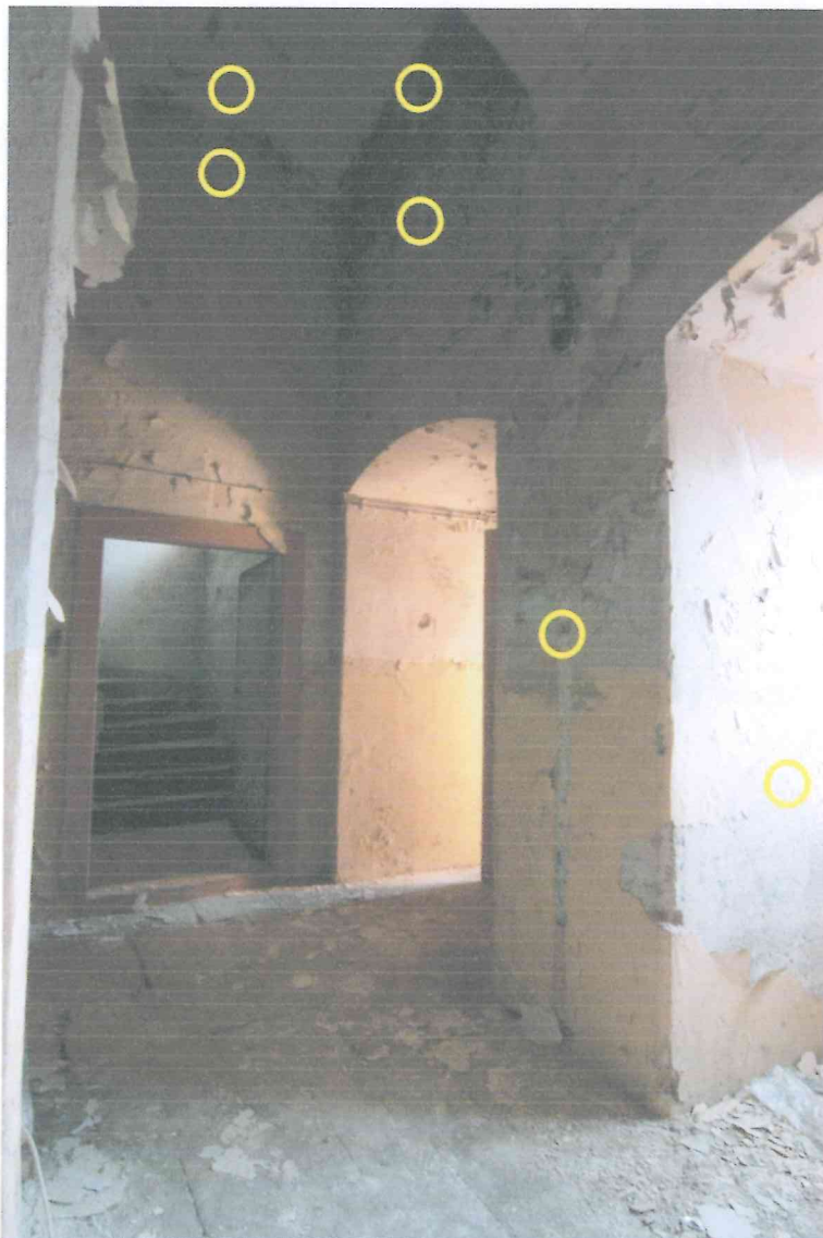
Pom. KL/S - widok na ścianę północną .
