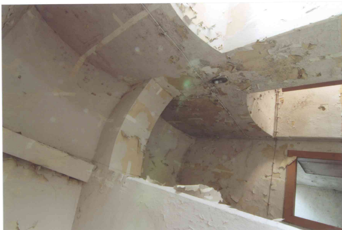
FOT. 7 - Klatka schodowa, półpiętro, widok sklepienia.
