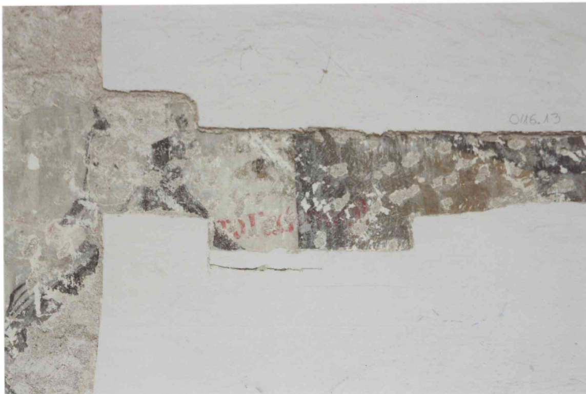
FOT. 8 - Pomieszczenie 0/16, detal fot.7.
