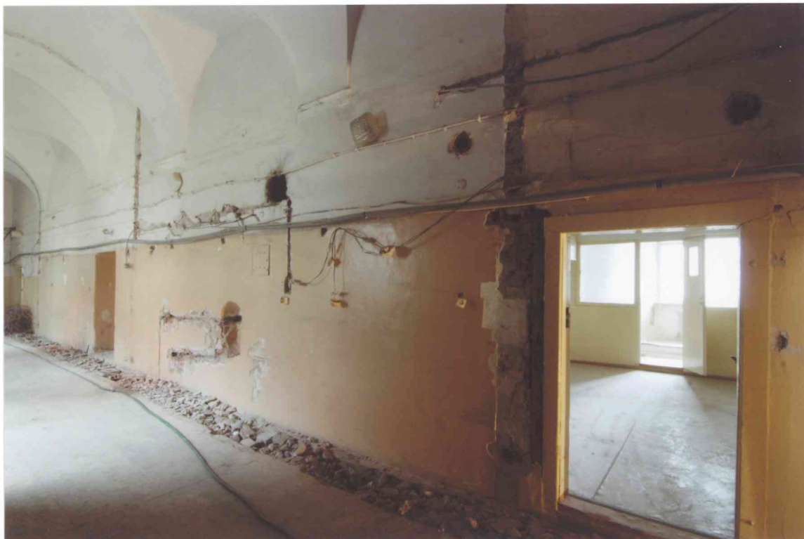
FOT. 5 - Pomieszczenie 0/15, widok ściany północnej.
