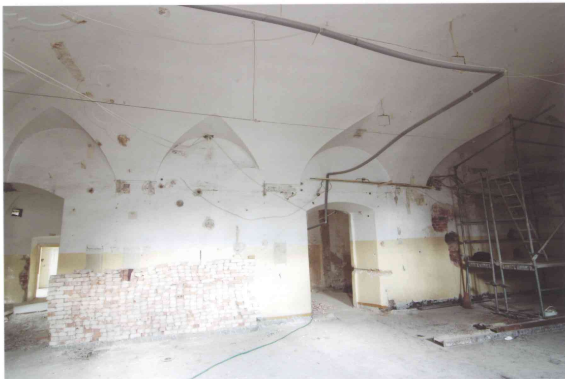
FOT. 2 – Pomieszczenie 0/16, widok ściany wschodniej.
