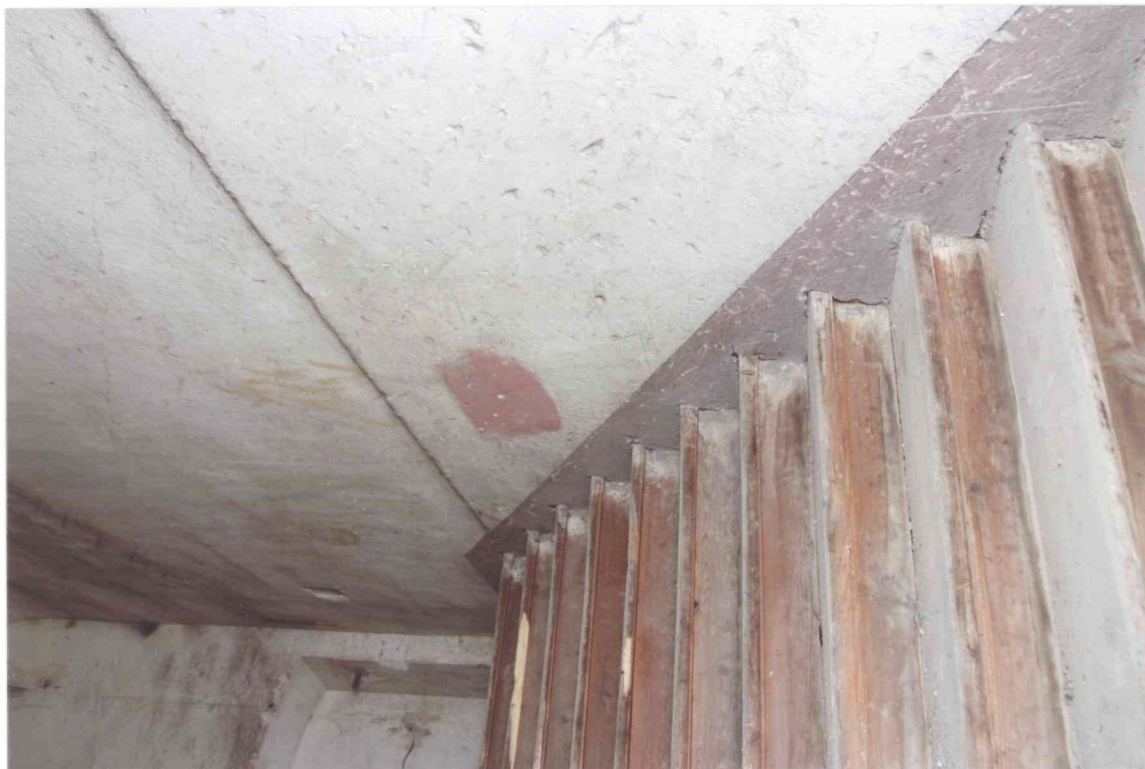
FOT. 10 - Klatka schodowa, wejście na strych.
