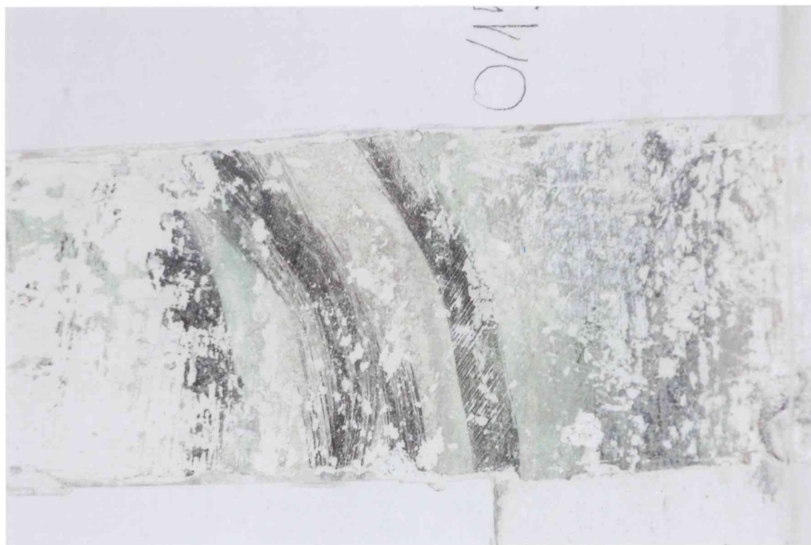
FOT. 24 - Pomieszczenie 0/15, detal fot. 23.
