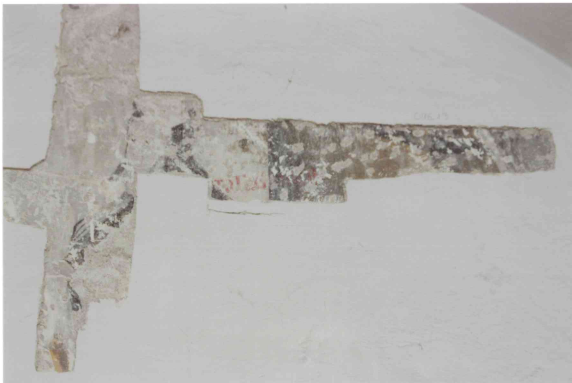
FOT. 7 - Pomieszczenie 0/16, część południowa ściany wschodniej, detal fot.6.
