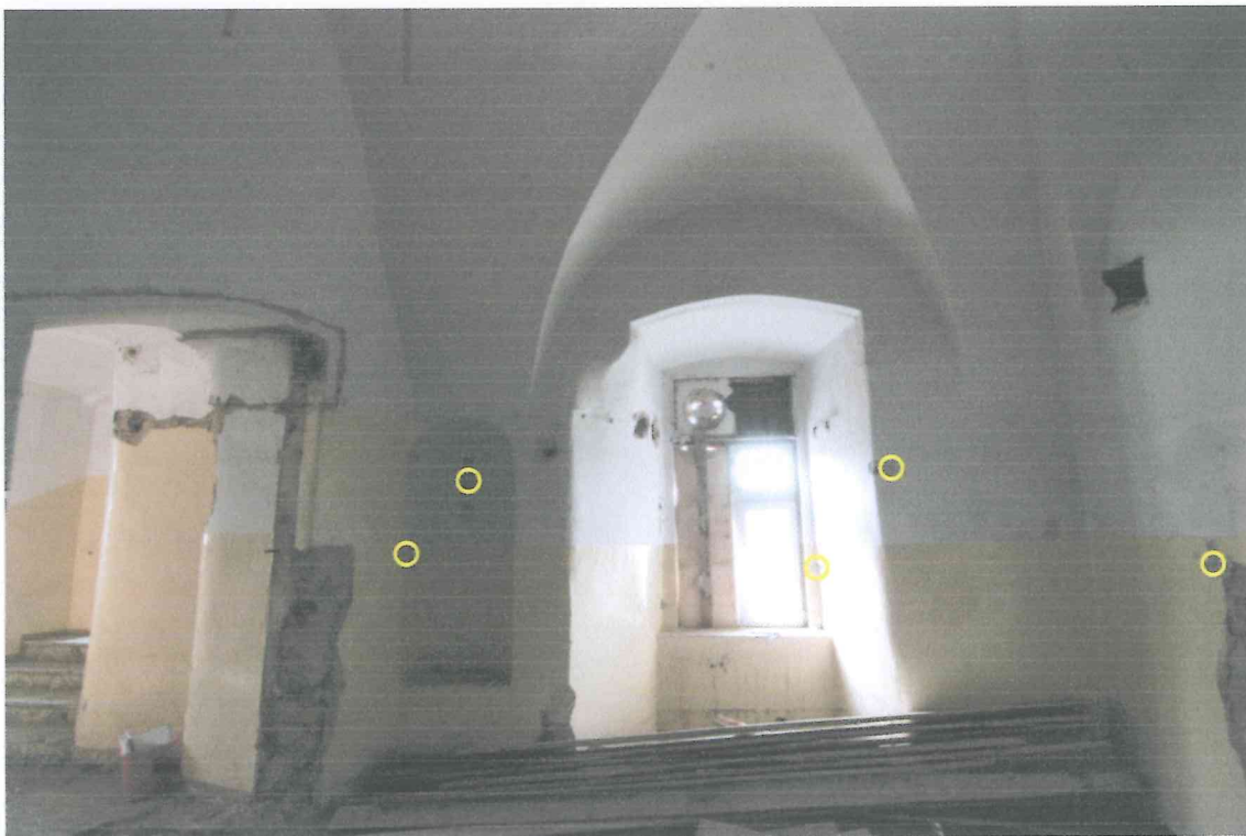
Pom. 0/14 – widok na ścianę północną.
