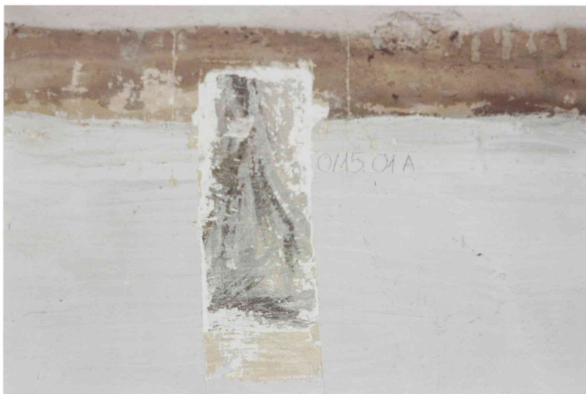
FOT. 16 - Pomieszczenie 0/15, ściana południowa część wschodnia, detal fot. 4.
