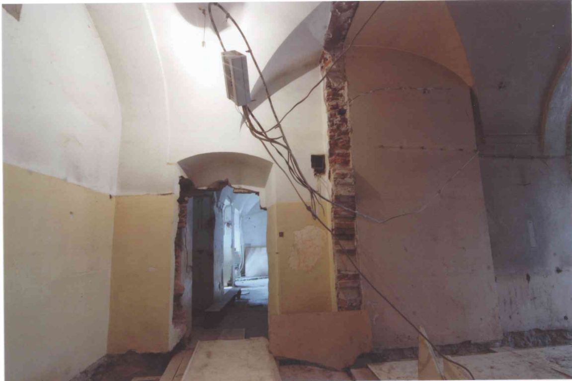
FOT. 11 - Pomieszczenie 0/20-K1, ściana północna części zachodniej.
