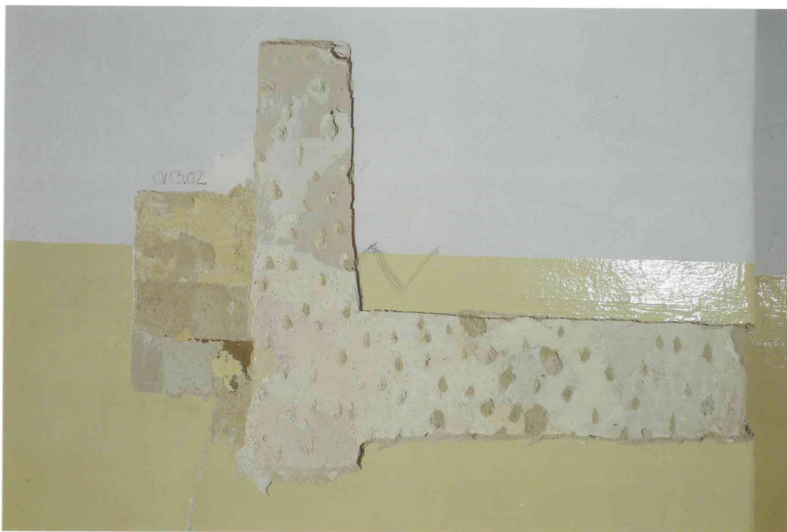
FOT. 13 - Pomieszczenie 0/13, ściana wschodnia, glif okienny.
