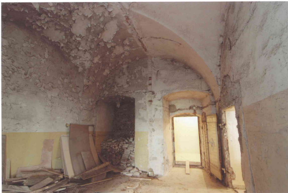
FOT. 1 - Pomieszczenie 0/18-0/19, widok od strony wschodniej.
