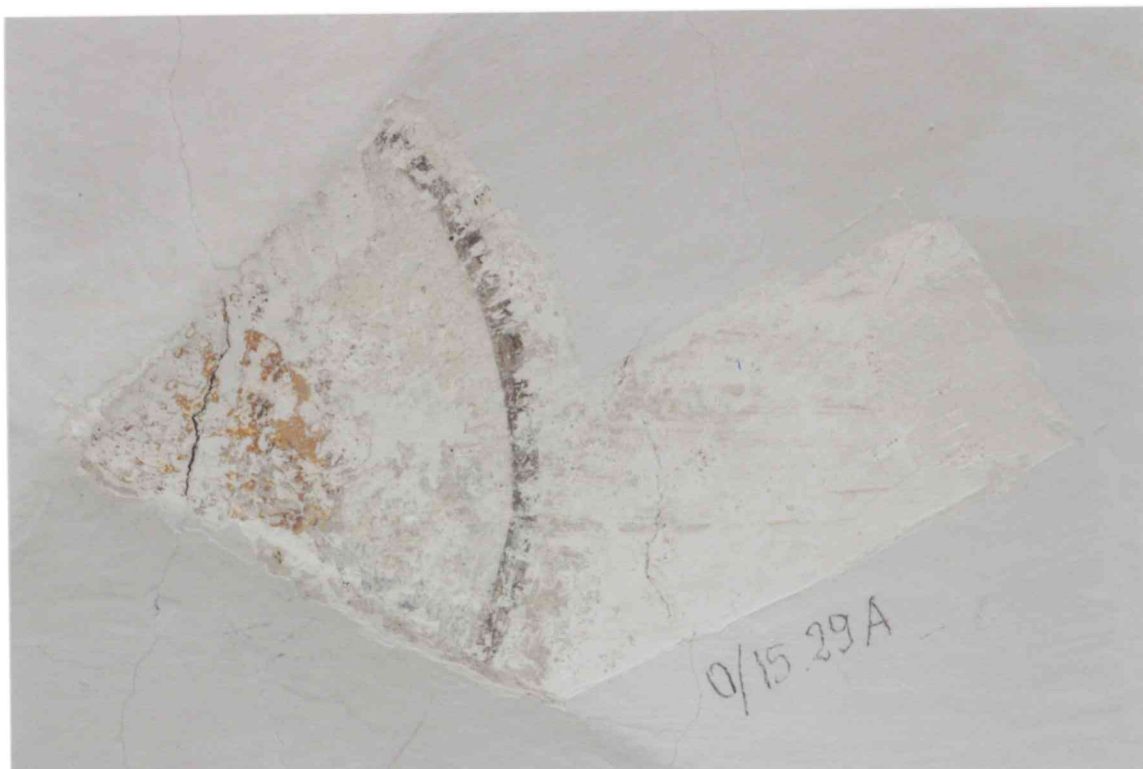
FOT. 26 - Pomieszczenie 0/15, sklepienie, detal fot. 4.
