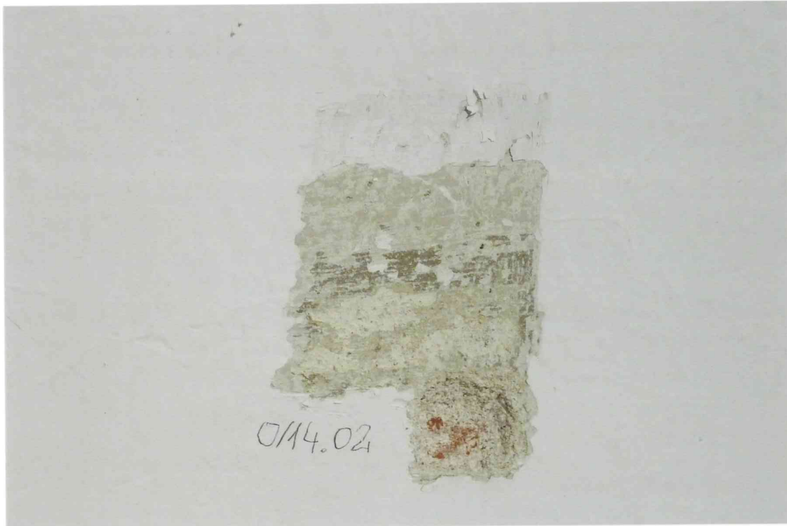
FOT. 5 - Pomieszczenie 0/14, sklepienie, detal fot.3.
