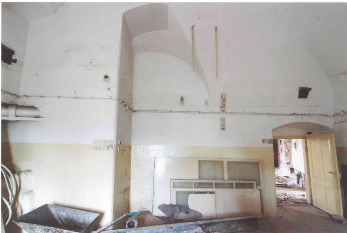
FOT. 4 - Pomieszczenie 0/14, widok ściany południowej.
