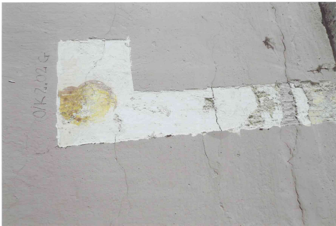
FOT. 15 - Pomieszczenie 0/01-0/K2, detal fot. 9.
