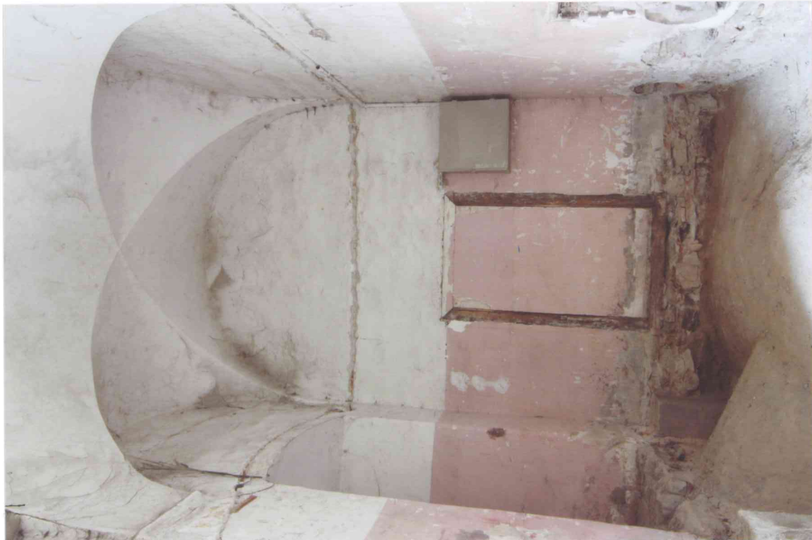
FOT. 6 - Pomieszczenie 0/20-K1, widok ściany południowej części wschodniej.
