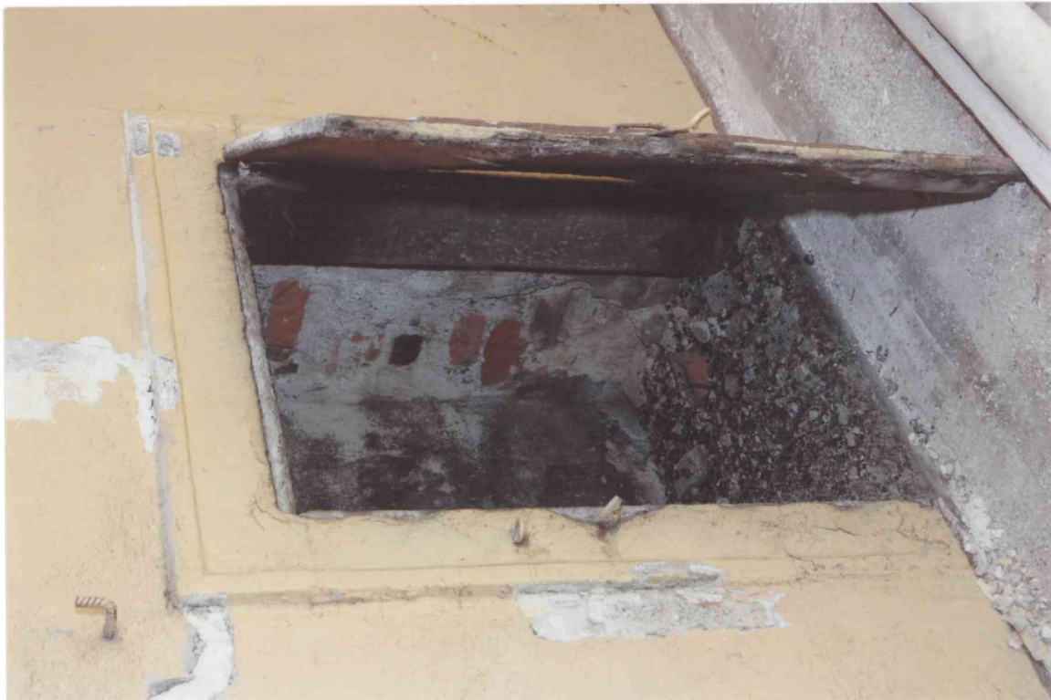
FOT. 38 - Pomieszczenie 0/01-0/K2, ściana północna, detal fot. 4.
