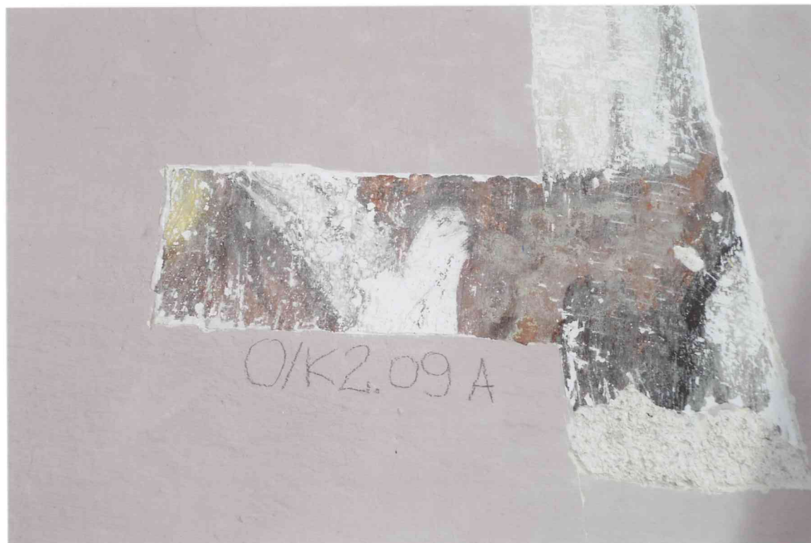
FOT. 22 - Pomieszczenie 0/01-0/K2, detal fot. 20.
