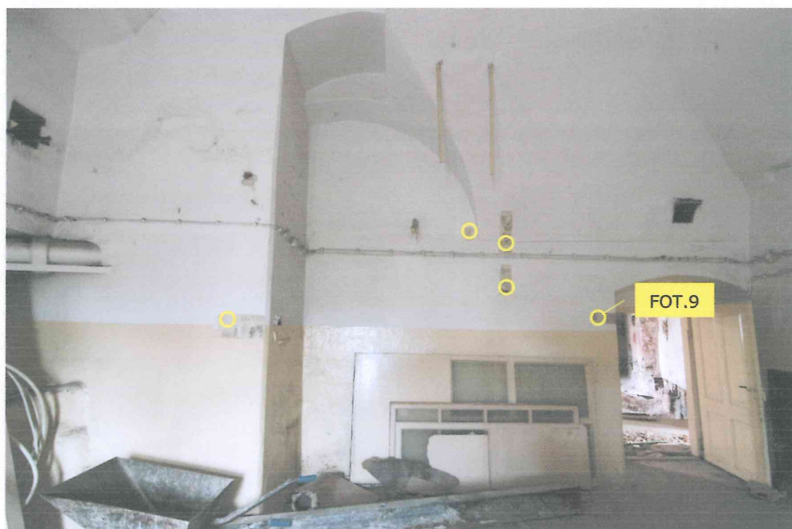
Pom. 0/14 - widok na ścianę południową.
