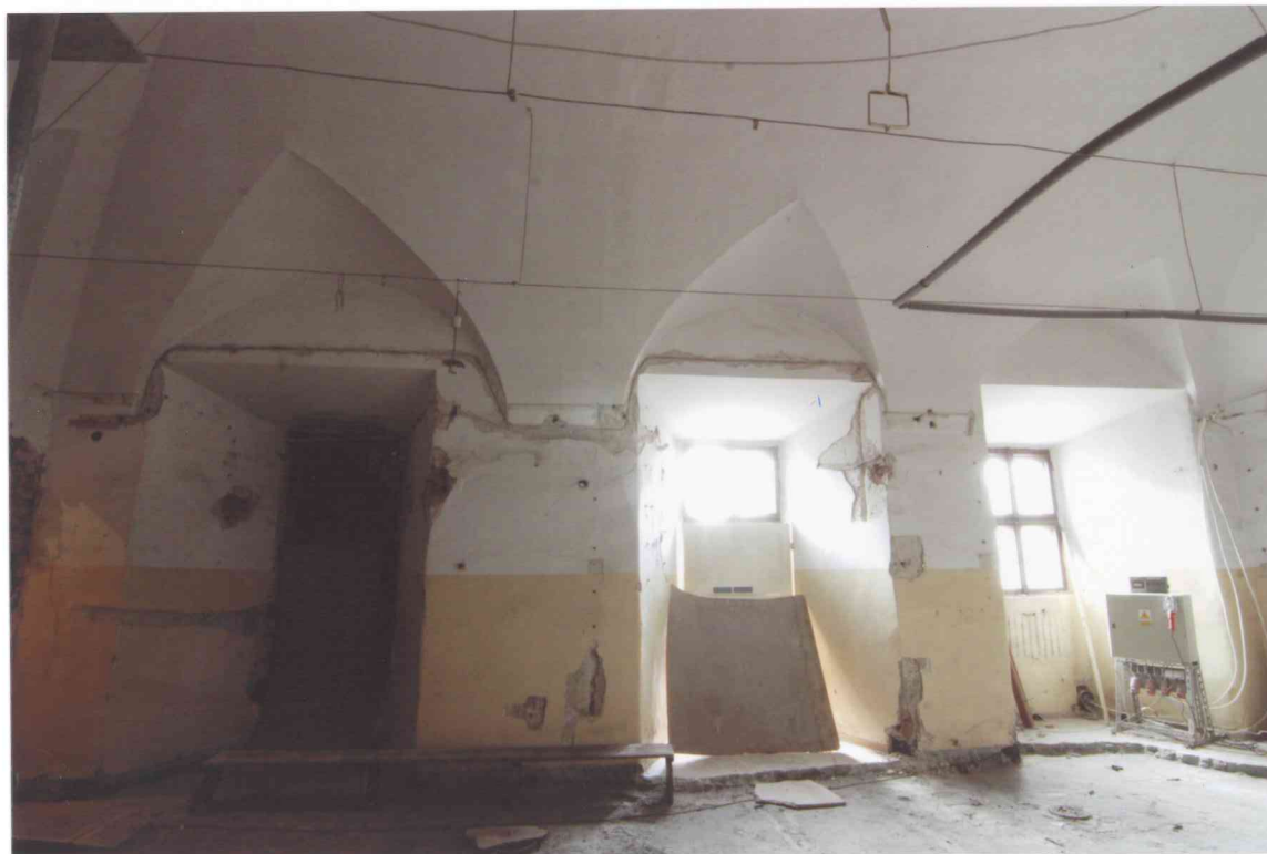
FOT. 4 - Pomieszczenie 0/16, widok ściany zachodniej.
