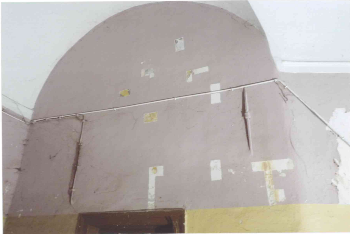
FOT. 9 - Pomieszczenie 0/01-0/K2, część wschodnia ściany południowej.
