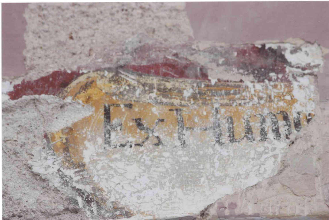
FOT. 23 - Pomieszczenie 0/01-0/K2, detal fot. 20.
