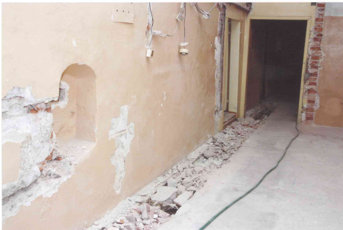
FOT. 6 - Pomieszczenie 0/15, narożnik północno-wschodni.
