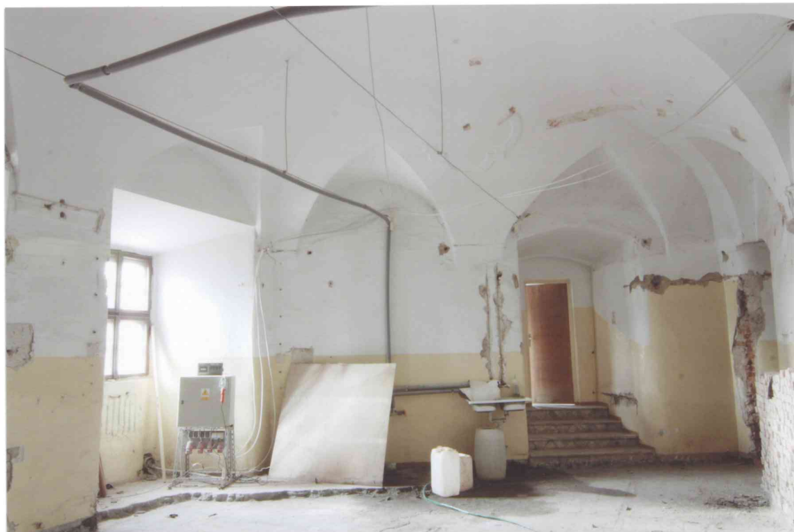
FOT. 3 - Pomieszczenie 0/16, widok ściany północnej.
