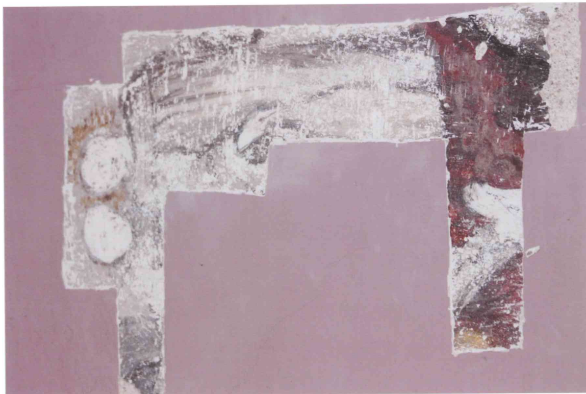
FOT. 21- Pomieszczenie 0/01-0/K2, detal fot. 20.
