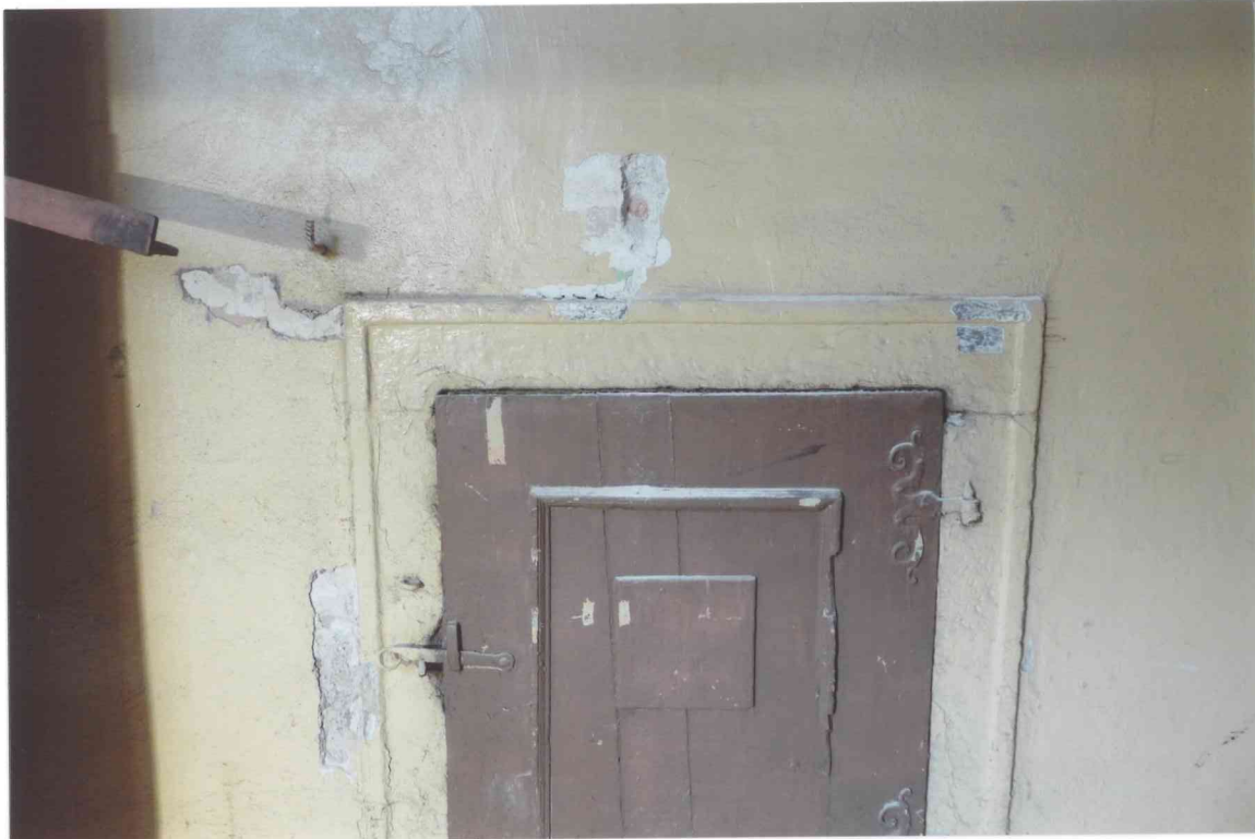
FOT. 37 - Pomieszczenie 0/01-0/K2, ściana północna, detal fot. 4.
