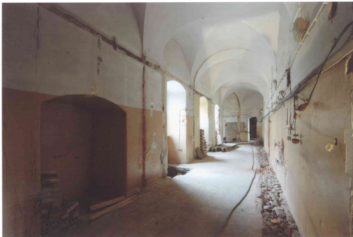
FOT. 1 - Pomieszczenie 0/15, widok od strony wschodniej.
