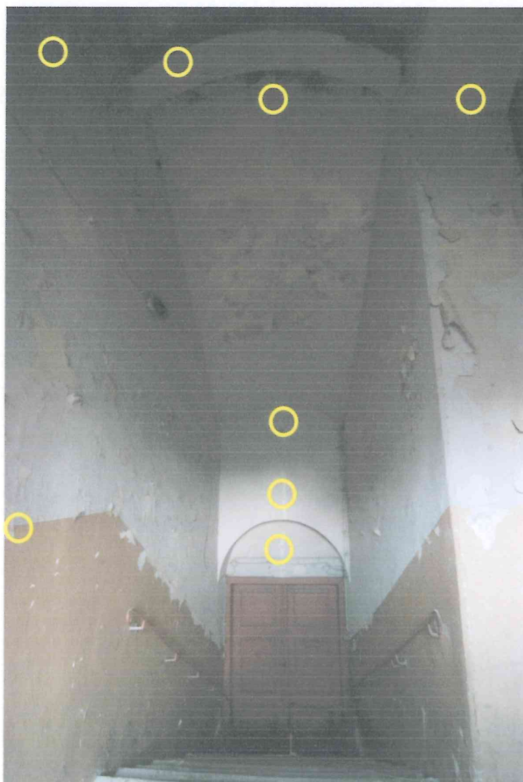
Pom. KL/S – widok na ścianę południową.
