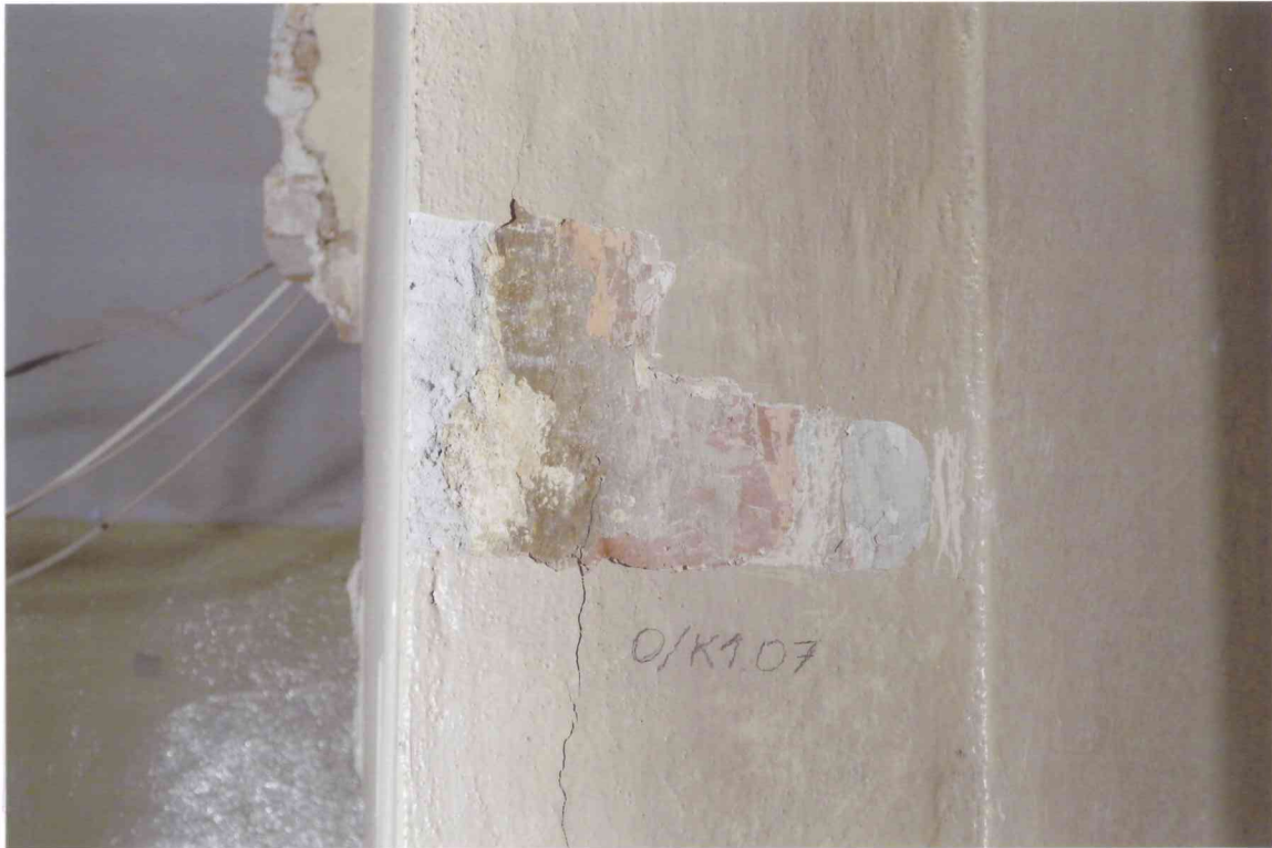
FOT. 17 - Pomieszczenie 0/20-K1, ściana północna części zachodniej korytarza, detal fot. 8.
