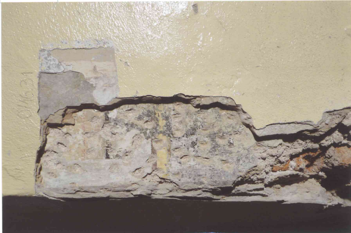
FOT. 23 - Pomieszczenie 0/16, ściana zachodnia, cokół, detal fot. 4.
