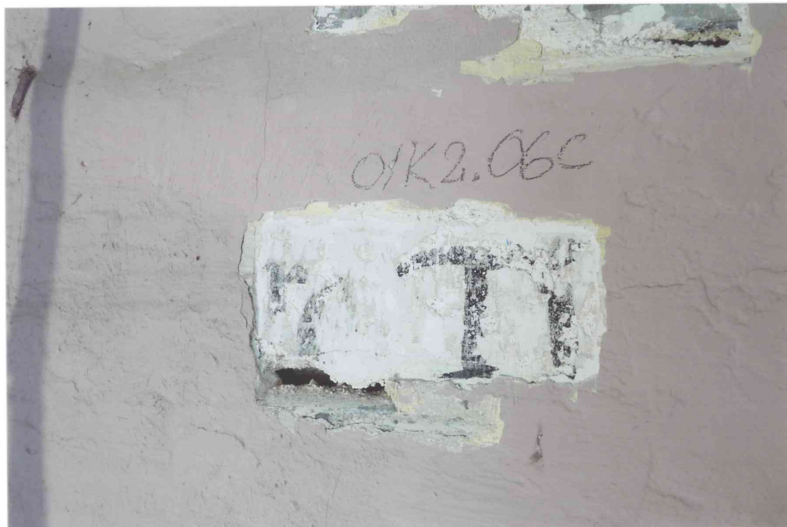
FOT. 28 - Pomieszczenie 0/01-0/K2, detal fot. 26.
