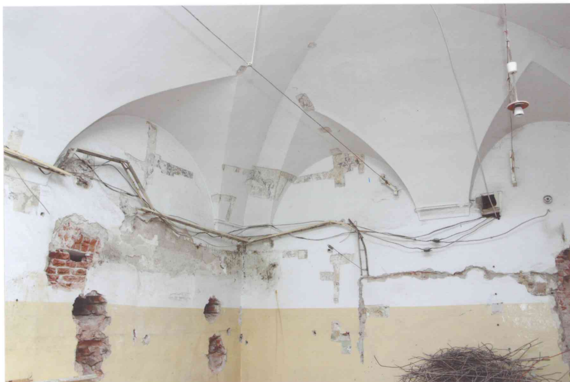
FOT. 6 - Pomieszczenie 0/16, narożnik południowo-wschodni.
