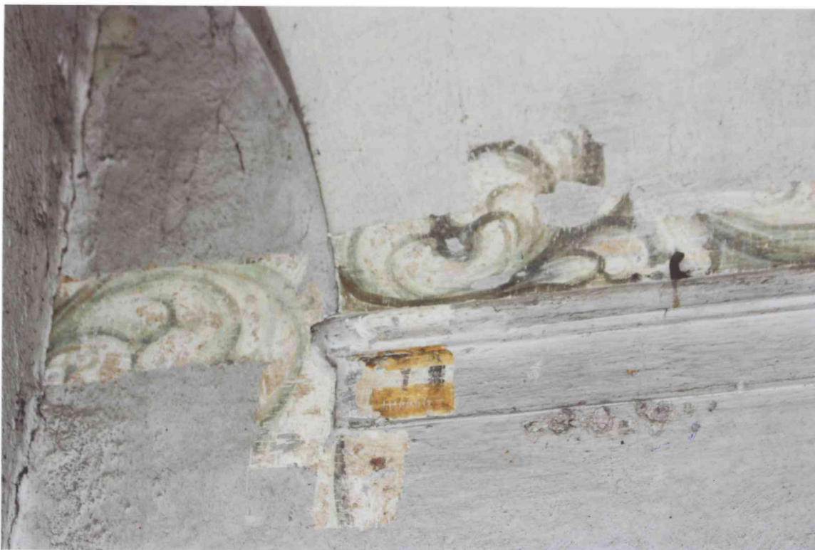
FOT. 32 - Pomieszczenie 0/2B, detal fot. 31.
