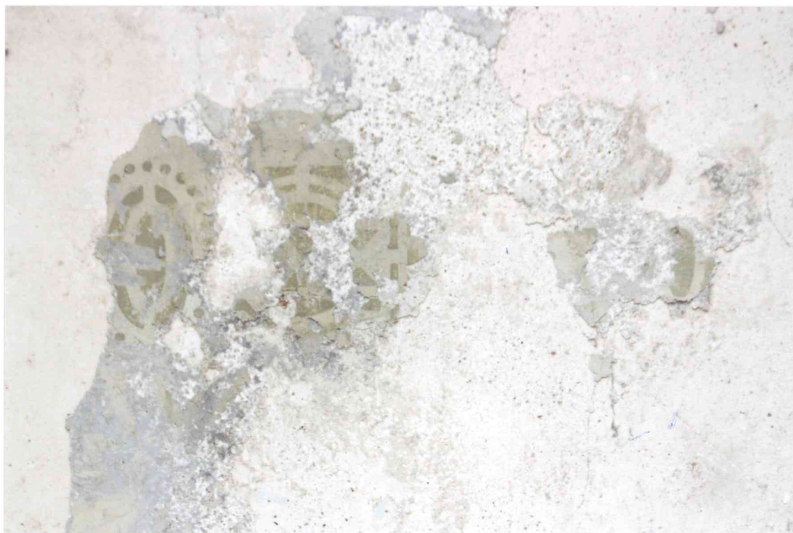
FOT. 8 - Pomieszczenie 0/A, ściana zachodnia, detal fot. 4.
