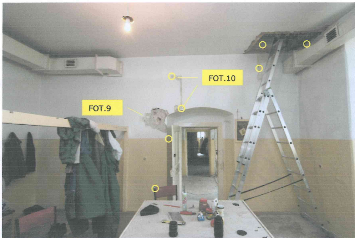
Pom. 0/12 – widok na ścianę zachodnią.
