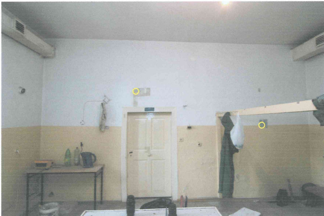
Pom. 0/12 – widok na ścianę wschodnią.
