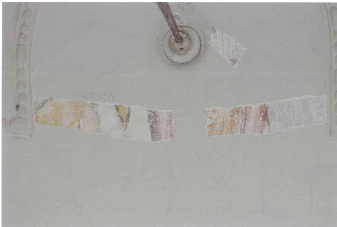
FOT. 7 - Pomieszczenie 0/07, detal fot. 5.
