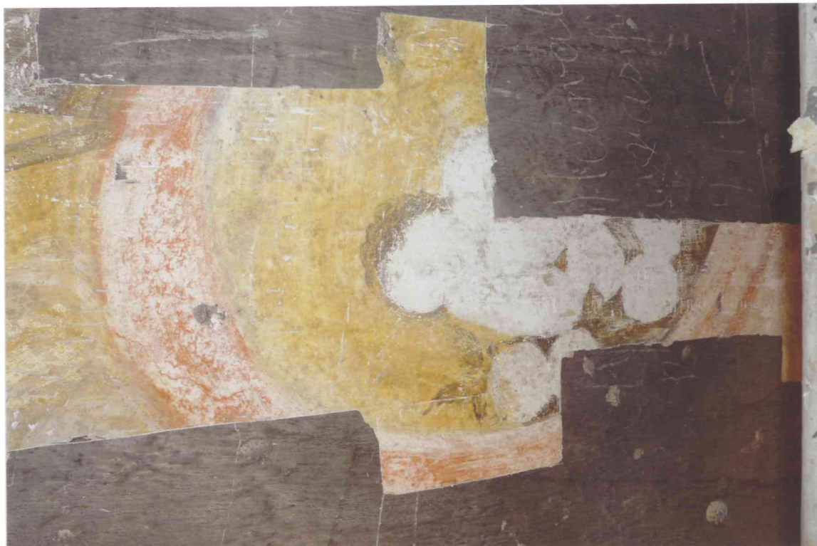
FOT. 15 – Pomieszczenie 0/2A, detal fot.14.
