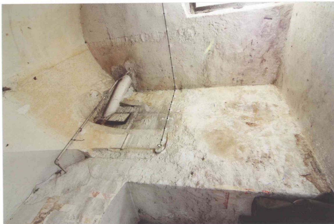
FOT. 20 – Pomieszczenie 0/2B, widok ściany zachodniej (cz. pn.).
