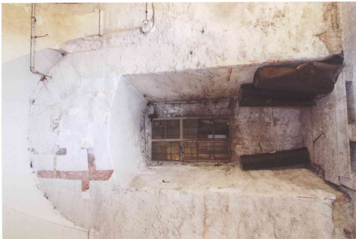
FOT. 21- Pomieszczenie 0/2B, widok ściany zachodniej (cz. pd.).
