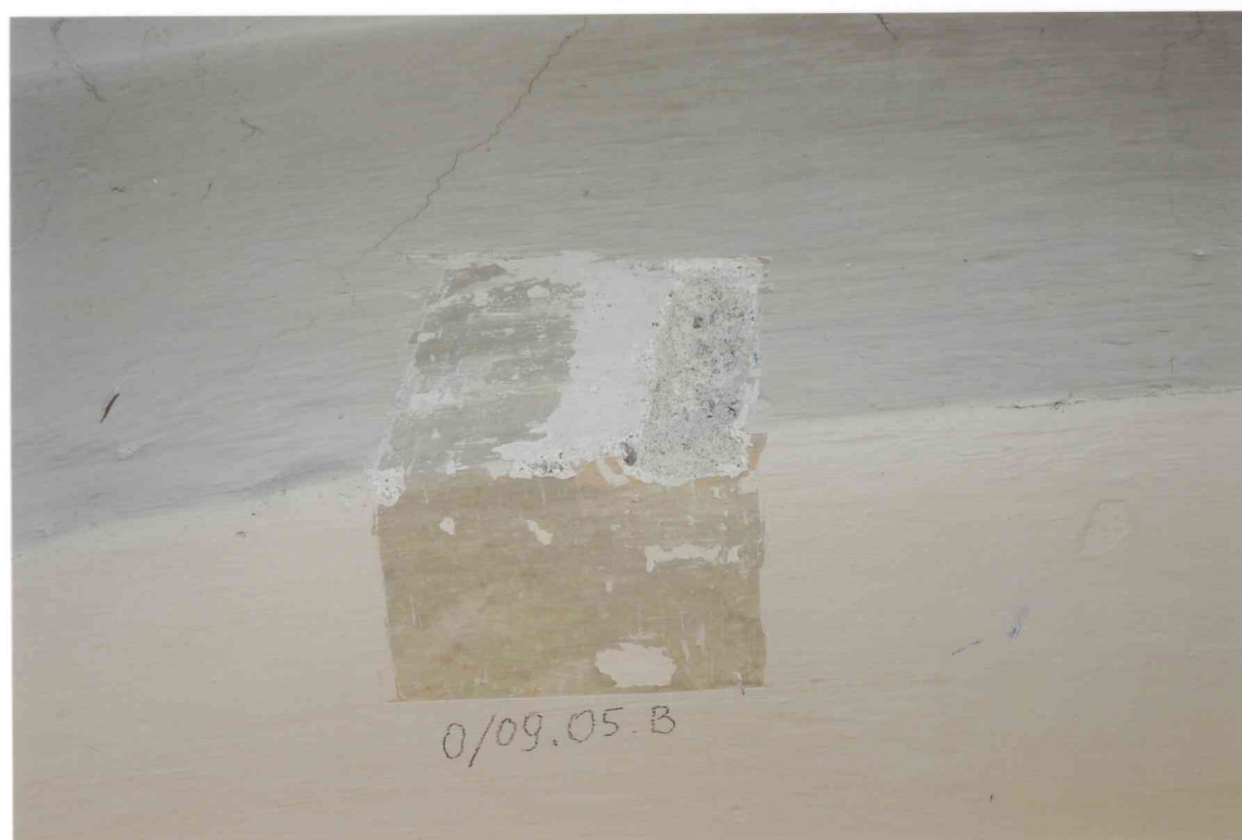
FOT. 2 - Pomieszczenie 0/08-0/09, sklepienie w części południowej.
