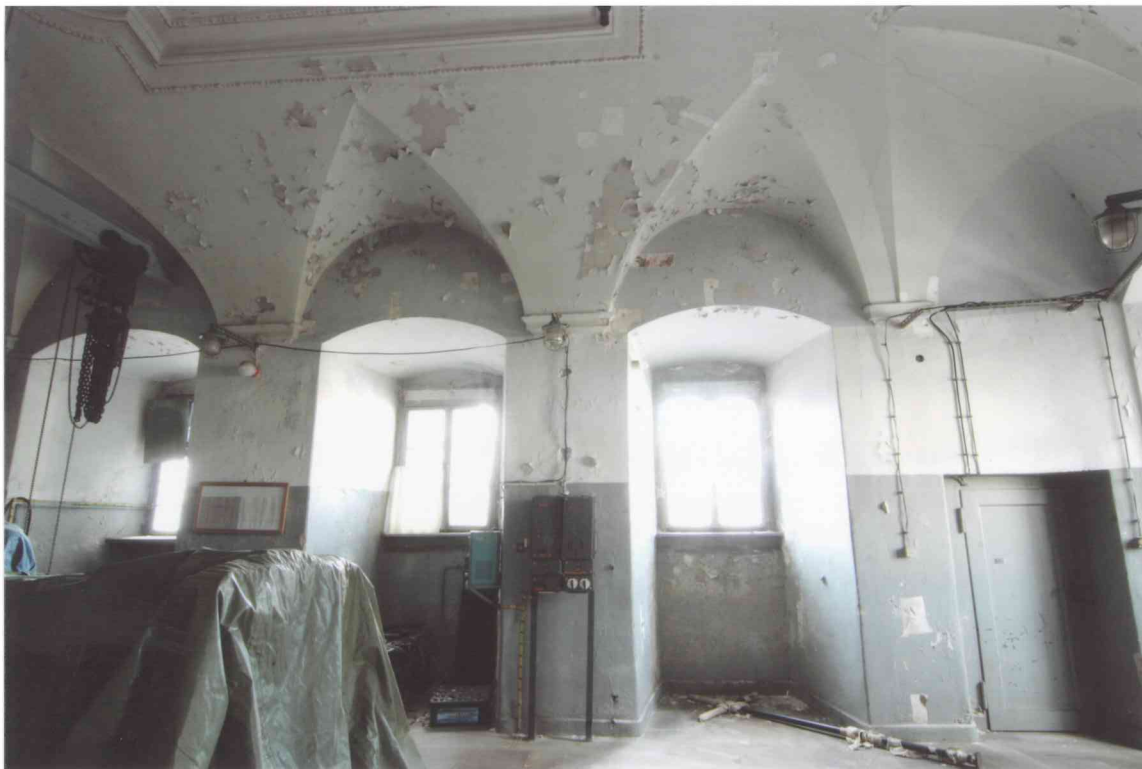
FOT. 3 - Pomieszczenie 0/07, widok ściany północnej.
