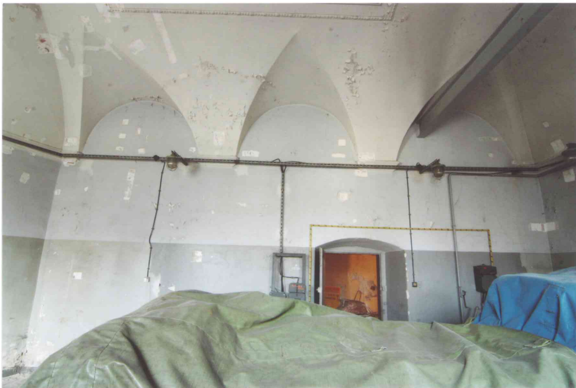
FOT. 1 – Pomieszczenie 0/07, widok ściany południowej.
