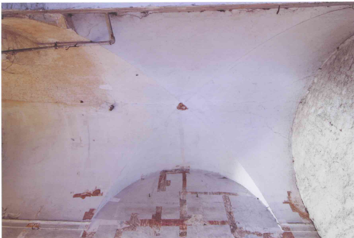
FOT. 25 – Pomieszczenie 0/2B, widok sklepienia.
