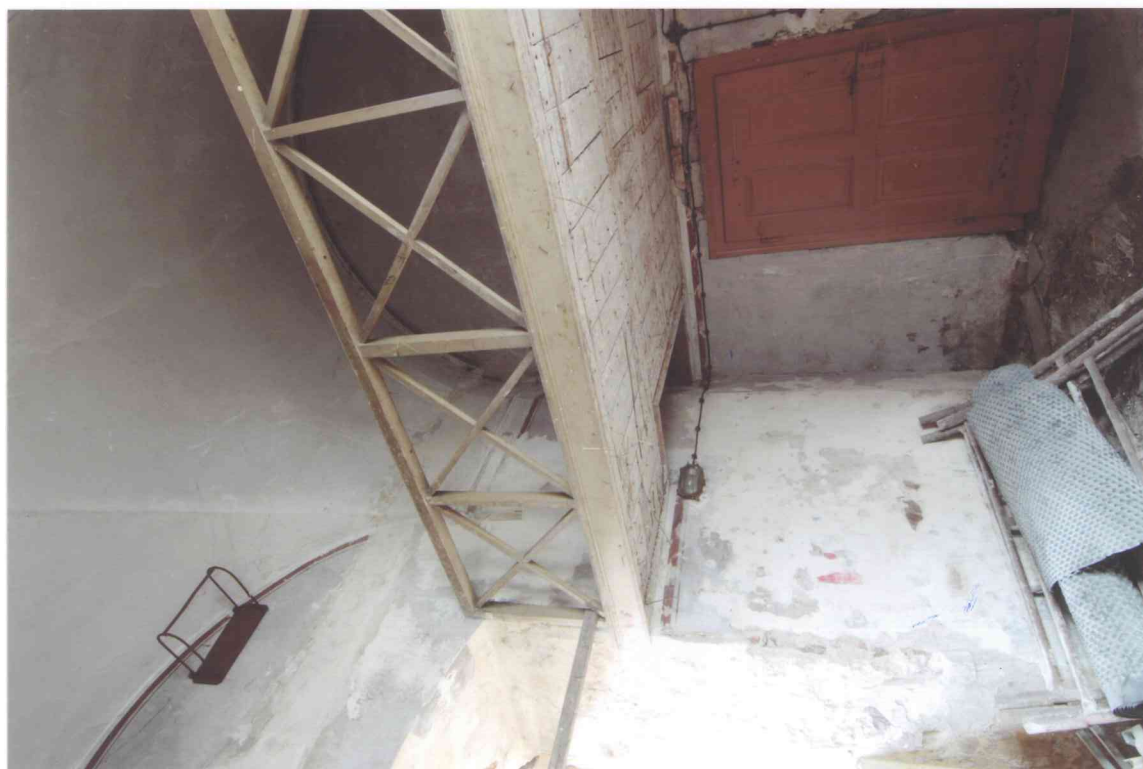
FOT. 4 - Pomieszczenie 0/A, widok ściany zachodniej.
