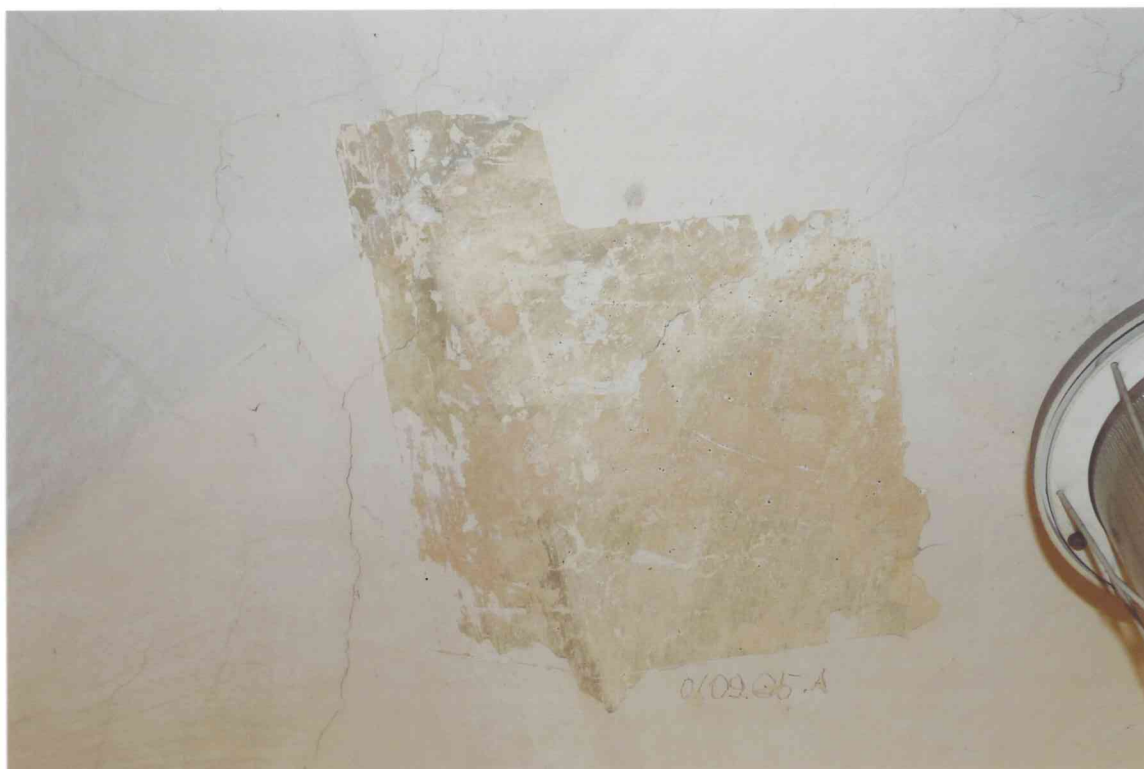
FOT. 1 - Pomieszczenie 0/08-0/09, sklepienie.
