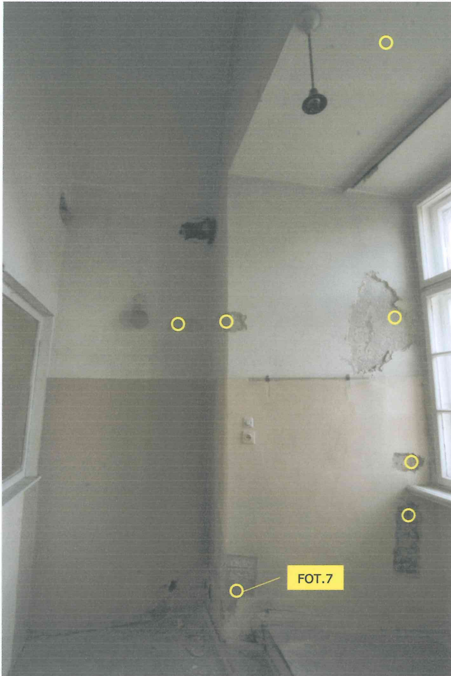
Pom. 0/11 – widok na północną część ściany zachodniej.
