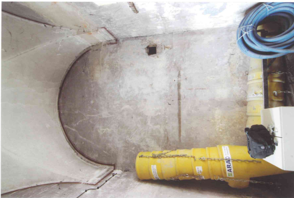
FOT. 3 - Pomieszczenie 0/A, widok ściany południowej.
