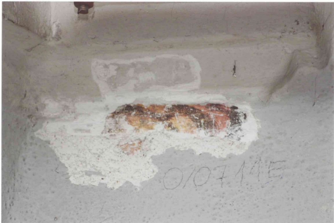
FOT. 18 - Pomieszczenie 0/07, ściana południowa, spływ sklepienia, narożnik wschodni, detal fot. 1.
