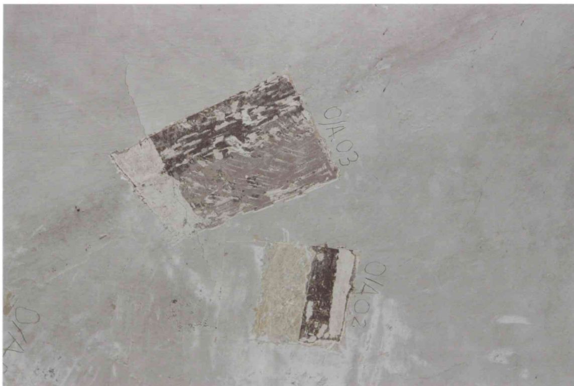
FOT. 5 – Pomieszczenie 0/A, sklepienie, odkrywki stratygraficzne.
