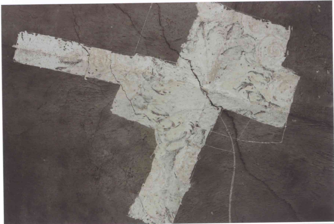
FOT. 8 – Pomieszczenie 0/2A, sklepienie, detal fot. 7 – odkrywka na przecięciu szwów sklepienia.
