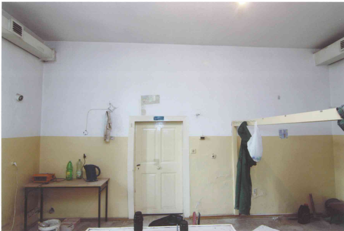
FOT. 3 - Pomieszczenie 0/12, widok ściany wschodniej.
