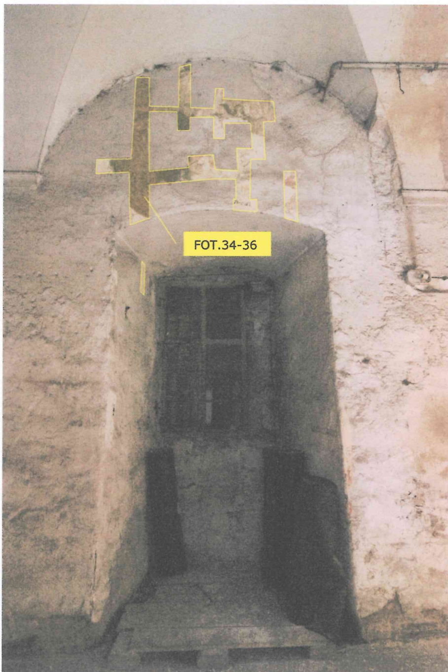
Pom. 0/02 B – widok na ścianę zachodnią.
