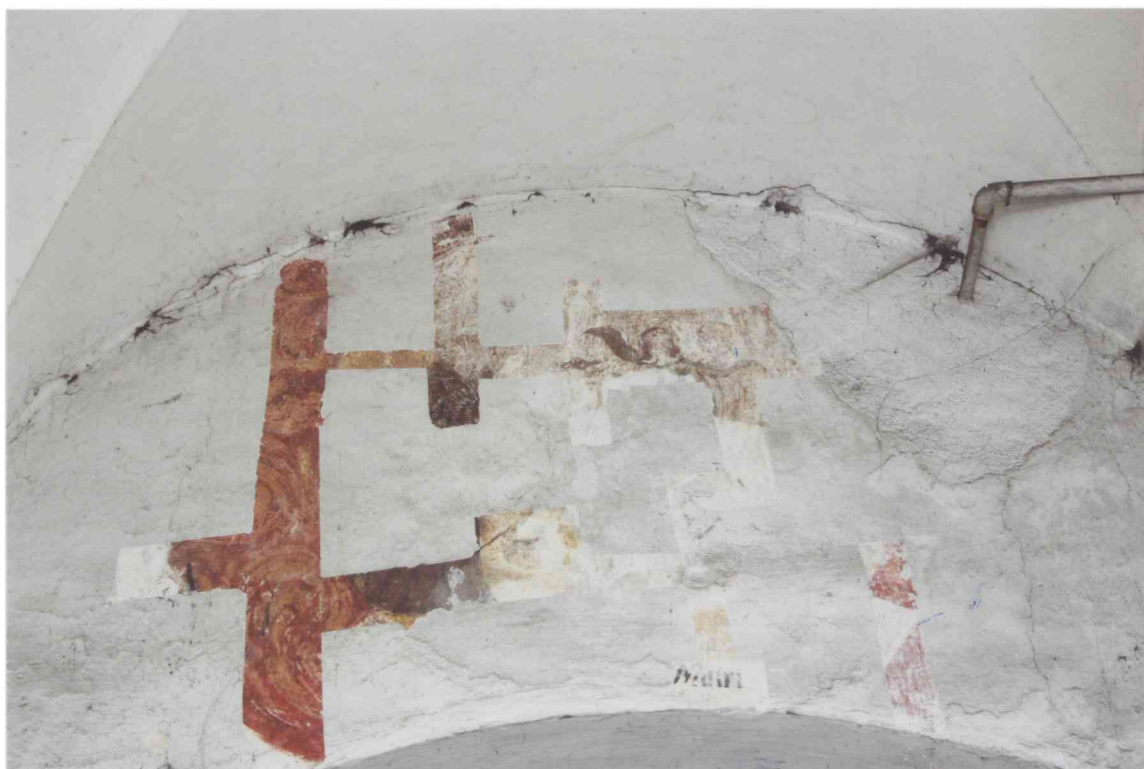
FOT. 34 - Pomieszczenie 0/2B, ściana zachodnia, detal fot. 21.
