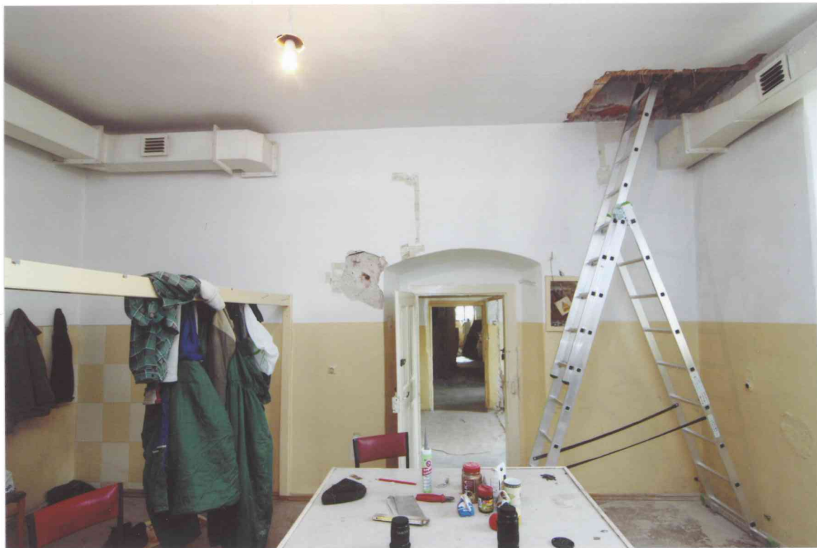
FOT. 1 - Pomieszczenie 0/12, widok ściany zachodniej.
