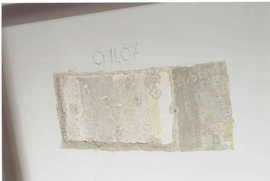
FOT. 11 - Pomieszczenie 0/11, ściana południowa nad wejściem.
