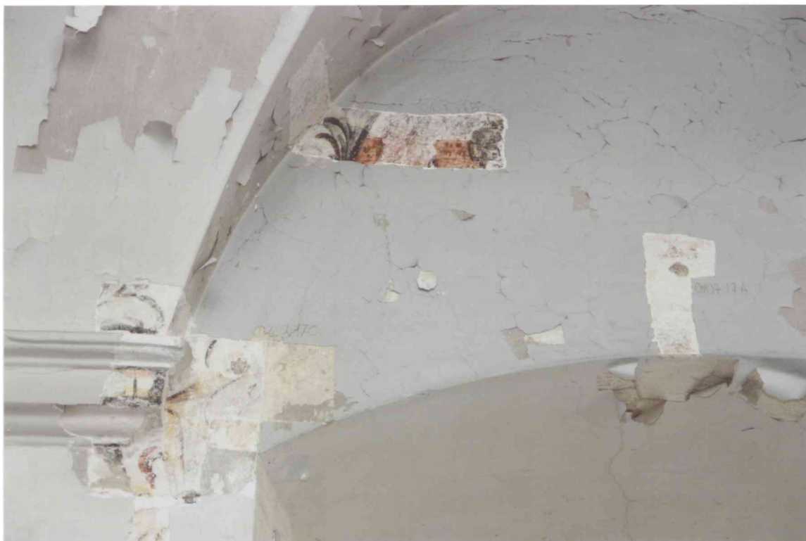
FOT. 19 - Pomieszczenie 0/07, ściana północna, detal fot. 3.
