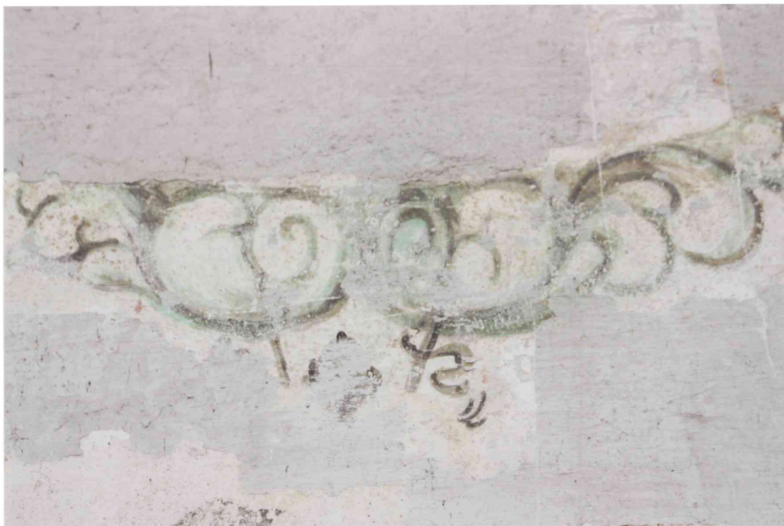
FOT. 33 - Pomieszczenie 0/2B, detal fot. 31.
