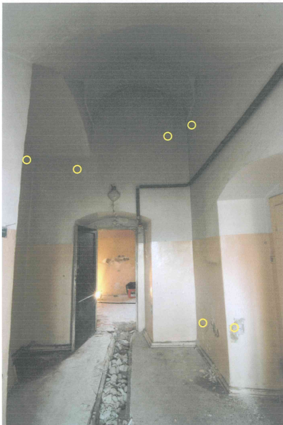
Pom. 0/10 – widok na ścianę południową.
