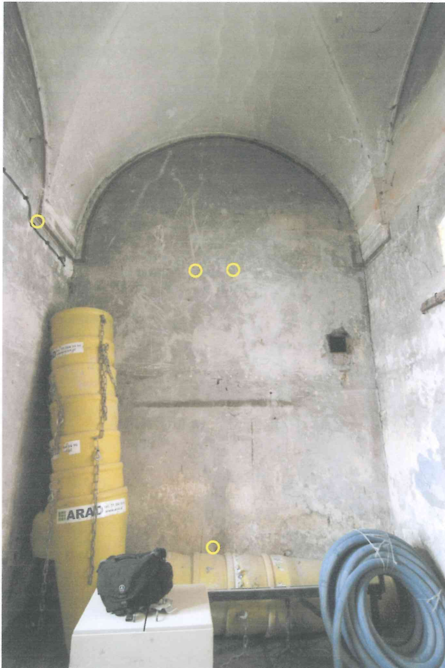
Pom.0/A – widok na ścianę południową.
