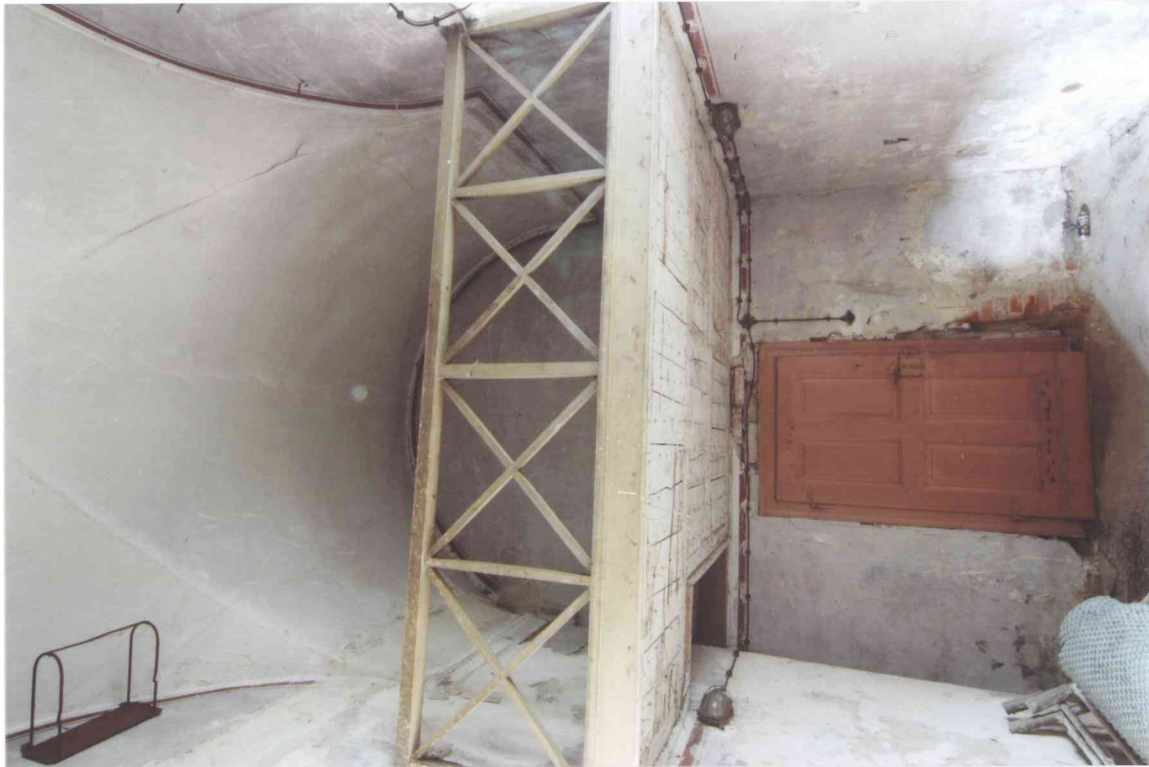
FOT. 1 - Pomieszczenie 0/A, widok ściany północnej.
