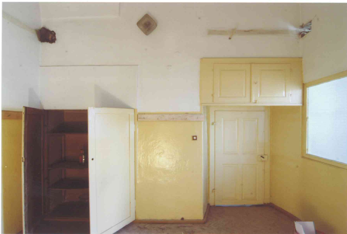
FOT. 1 - Pomieszczenie 0/11, widok ściany zachodniej.
