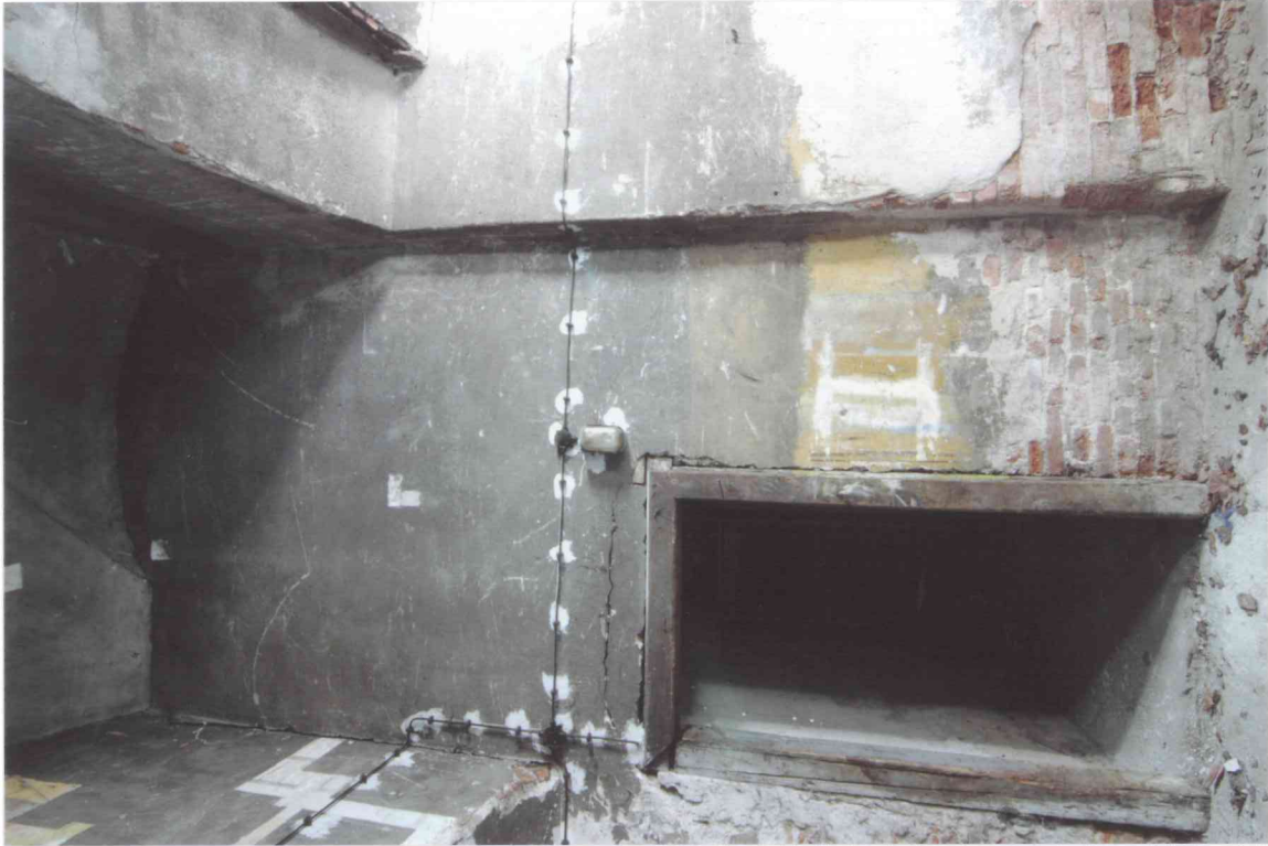
FOT. 5 – Pomieszczenie 0/2A, widok ściany południowej.
