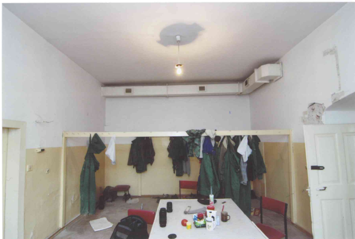
FOT. 4 - Pomieszczenie 0/12, widok ściany południowej.
