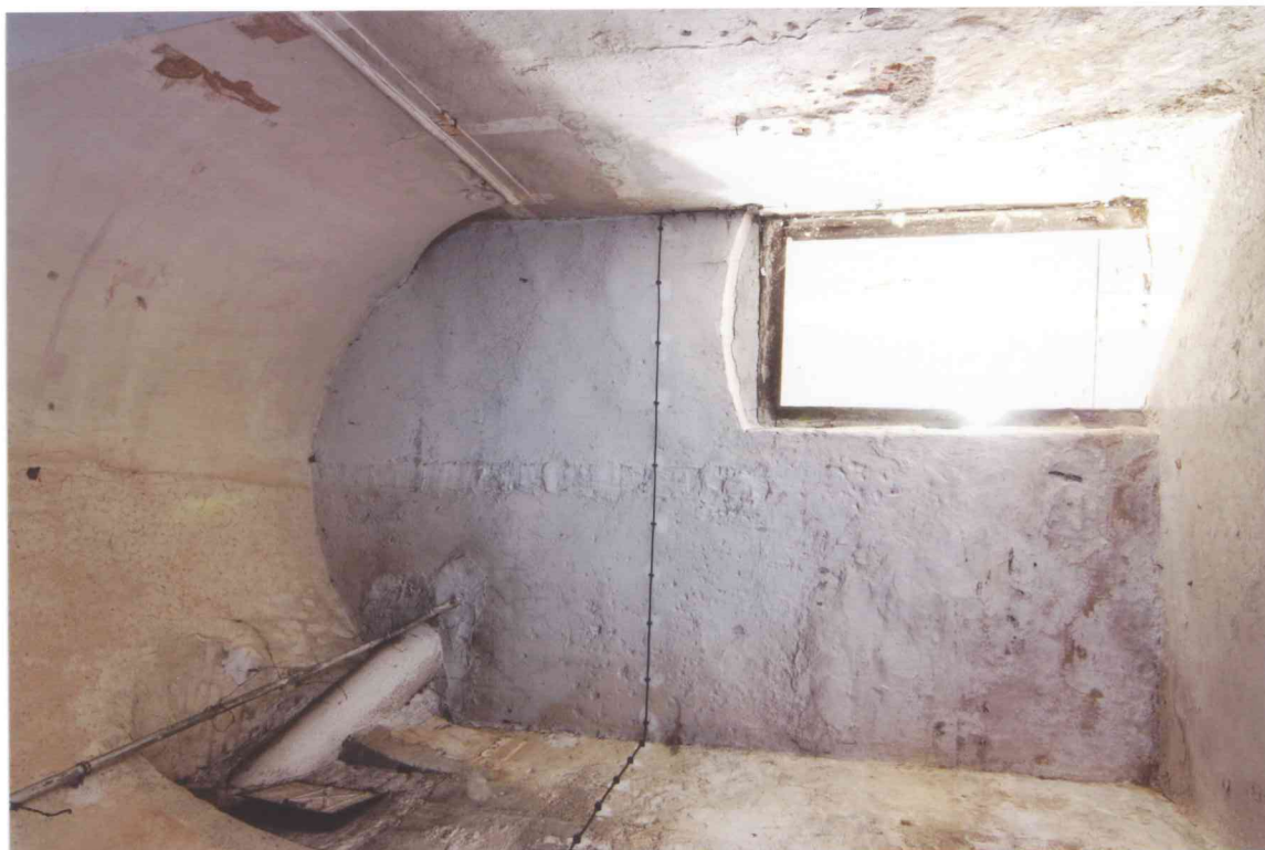
FOT. 19 – Pomieszczenie 0/2B, widok ściany północnej.
