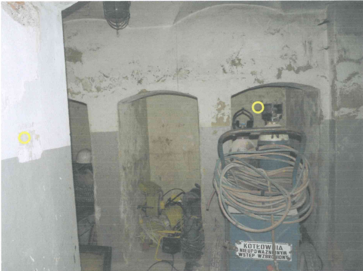
Pom. 0/09 – widok na ścianę zachodnią.
