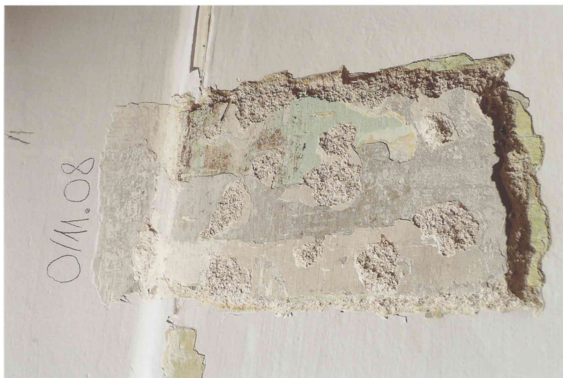
FOT. 12 - Pomieszczenie 0/11, ściana wschodnia pod splywem sklepienia.
