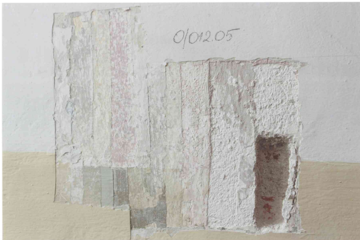
FOT. 11 - Pomieszczenie 0/12, gładz okienny w ścianie północnej, detal fot. 2.
