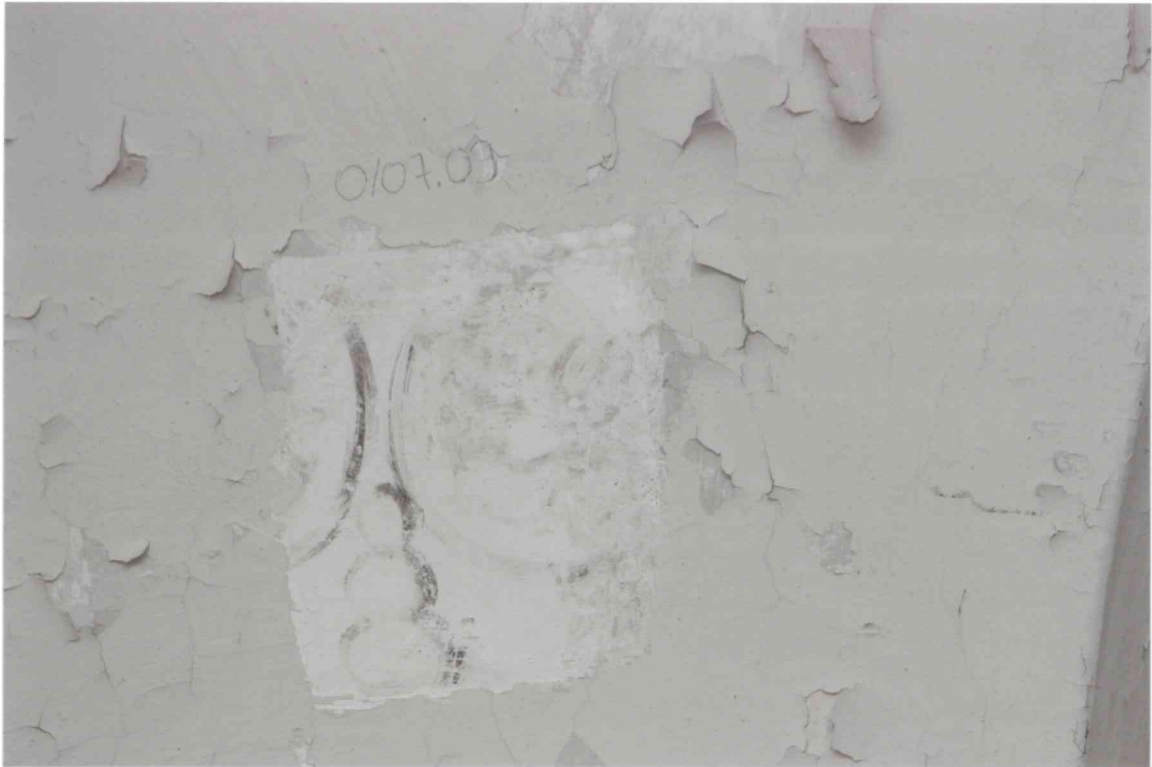
FOT. 17 - Pomieszczenie 0/07, ściana południowa, spływ sklepienia, detal fot. 1.
