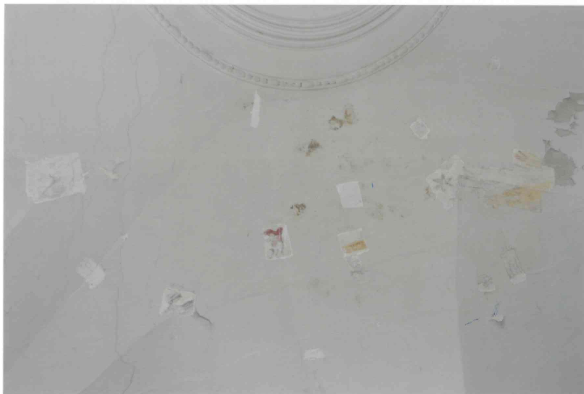
FOT. 6 - Pomieszczenie 0/07, widok części wschodniej sklepienia.
