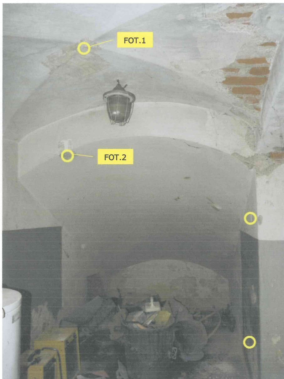
Pom. 0/09 – widok na sklepienie oraz ścianę południową.
