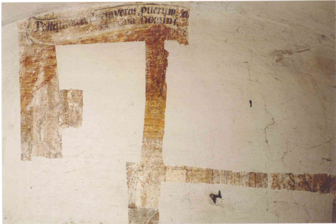
FOT. 27 – Pomieszczenie 0/2B, detal fot. 26.
