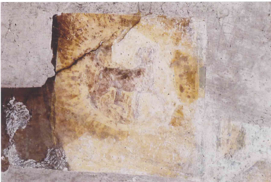
FOT. 36 - Pomieszczenie 0/2B, detal fot. 34.
