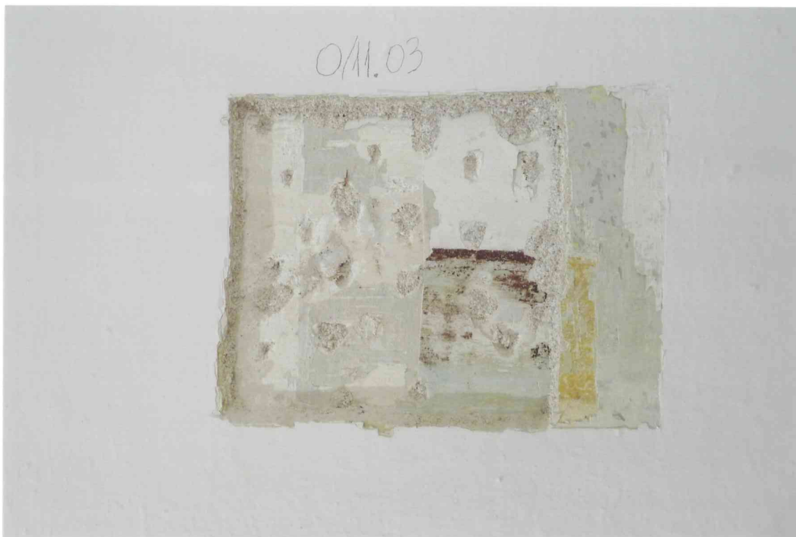
FOT. 9 - Pomieszczenie 0/11, ściana zachodnia, detal fot.1.
