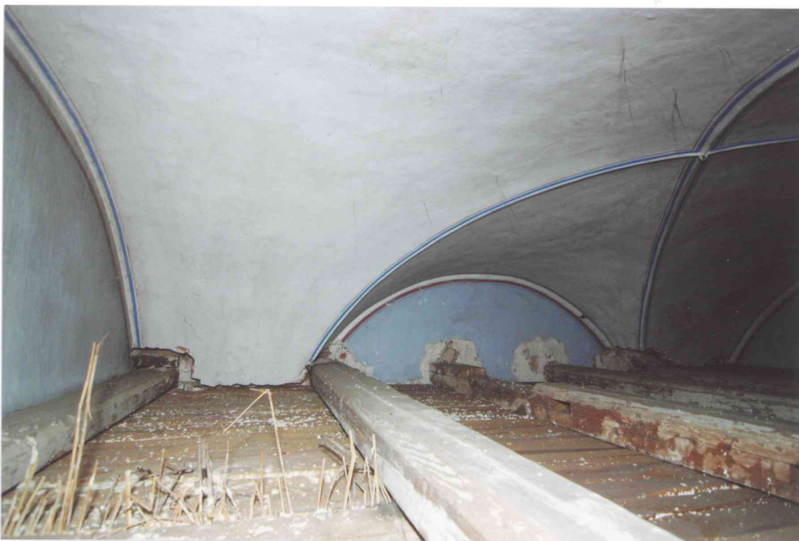
FOT. 5 - Pomieszczenie 0/12, widok sklepienia nad wtórnym stropem.
