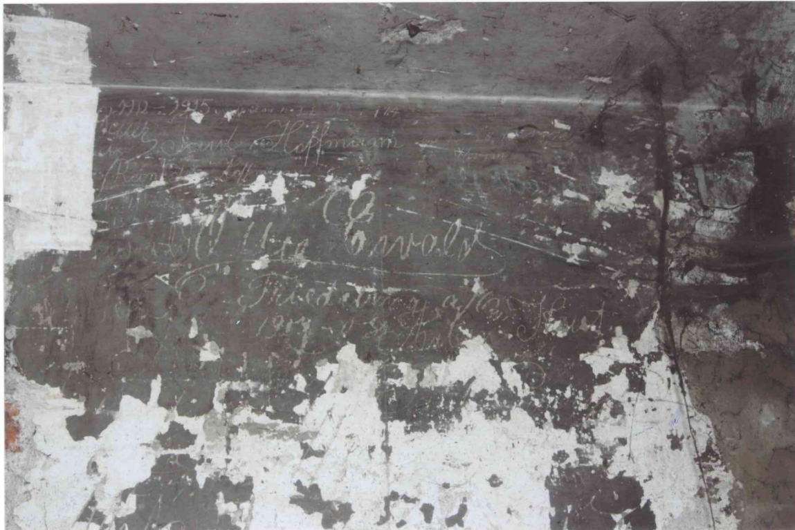
FOT. 6 – Pomieszczenie 0/2A, ściana wschodnia, detal fot. 3 – napisy.
