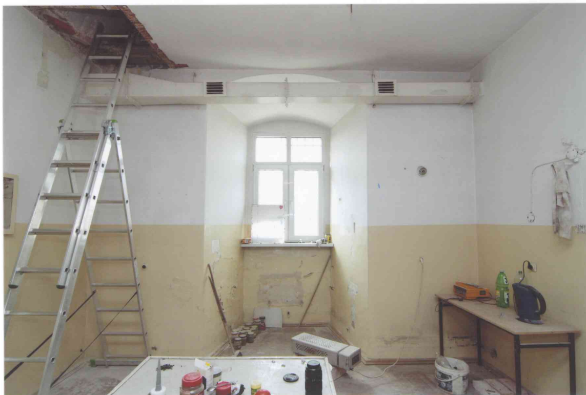
FOT. 2 - Pomieszczenie 0/12, widok ściany północnej.
