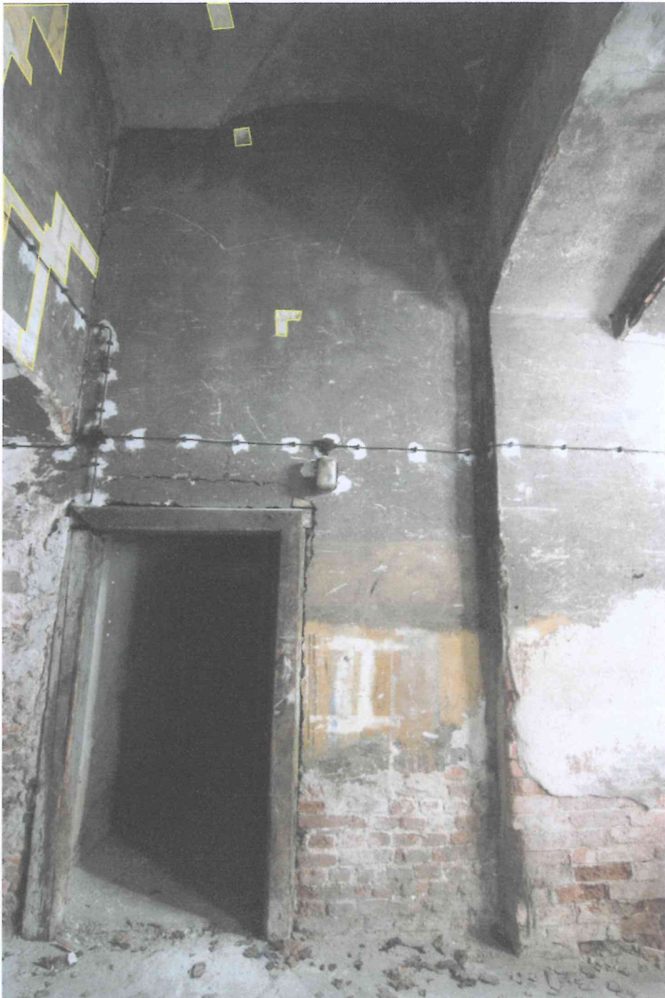
Pom. 0/02 A – widok na ścianę południową.
