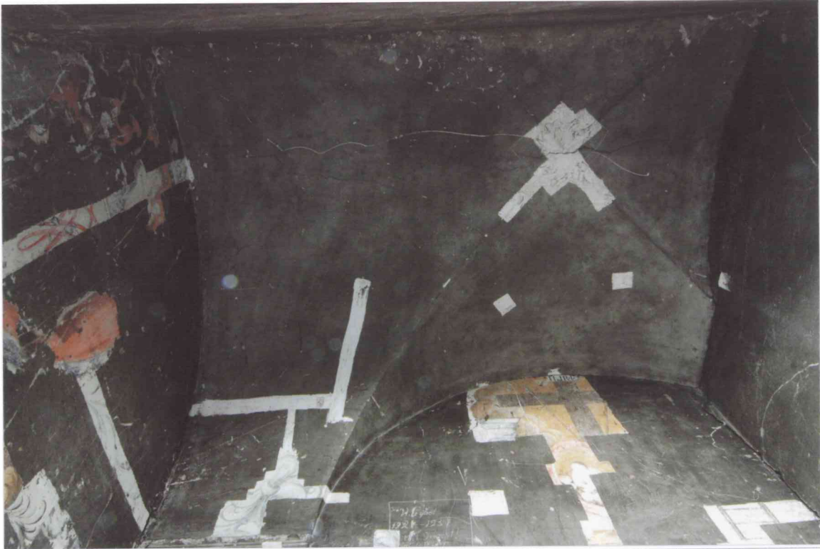
FOT. 7 – Pomieszczenie 0/2A, widok sklepienia.
