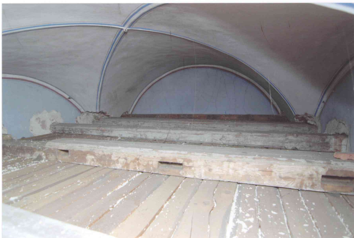
FOT. 6 - Pomieszczenie 0/12, widok sklepienia nad wtórnym stropem.
