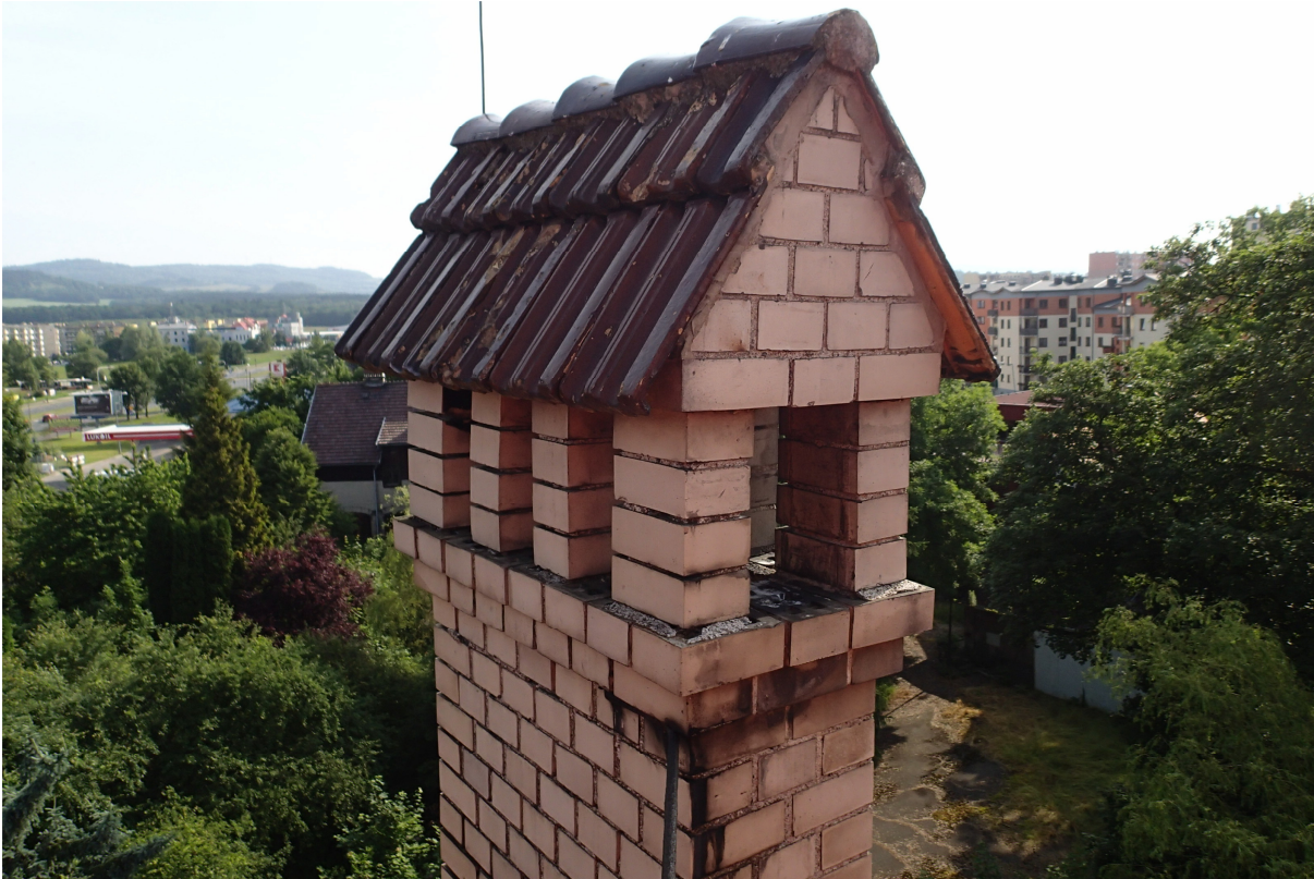
FOTOGRAFIA nr 1. Widok ozdobnej czapki kominowej do odtworzenia szt 5.
