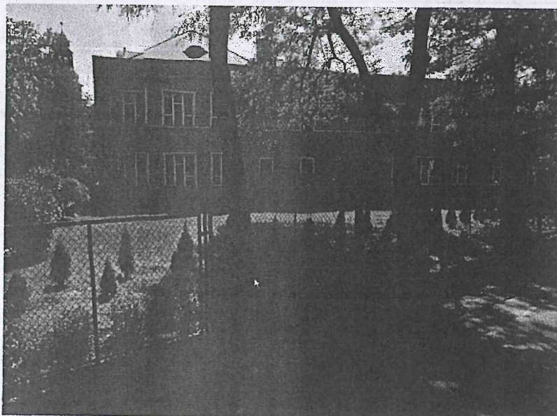
Widok istniejących przęseł przeznaczonych do wymiany
