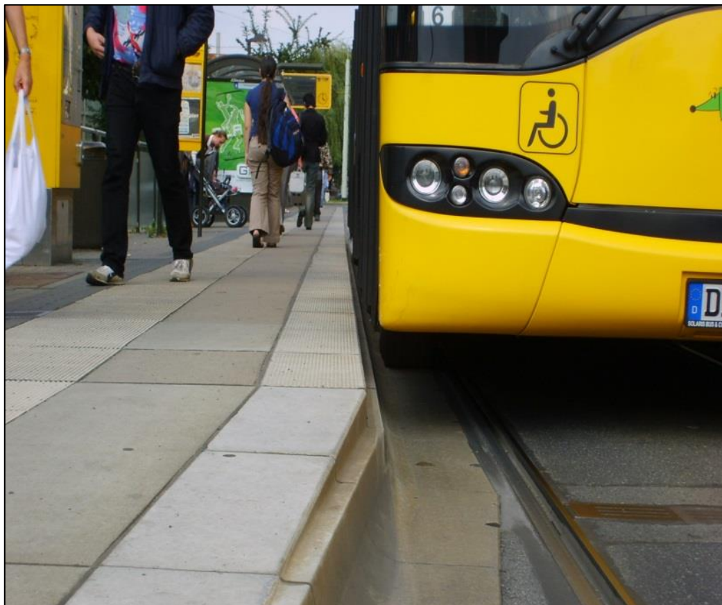
Rys. 30 Zalecane ukształtowanie krawędzi peronowej (Drezno – Niemcy) 58
