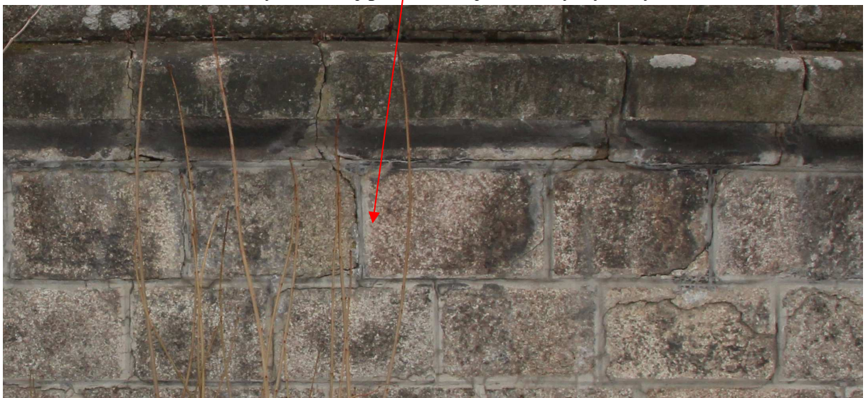
Fot. 6.2 Spękanie ciosów kamiennych i spoin wraz z powierzchniowymi ubytkami kamienia ściany czołowej południowej od strony Rybnicy.
