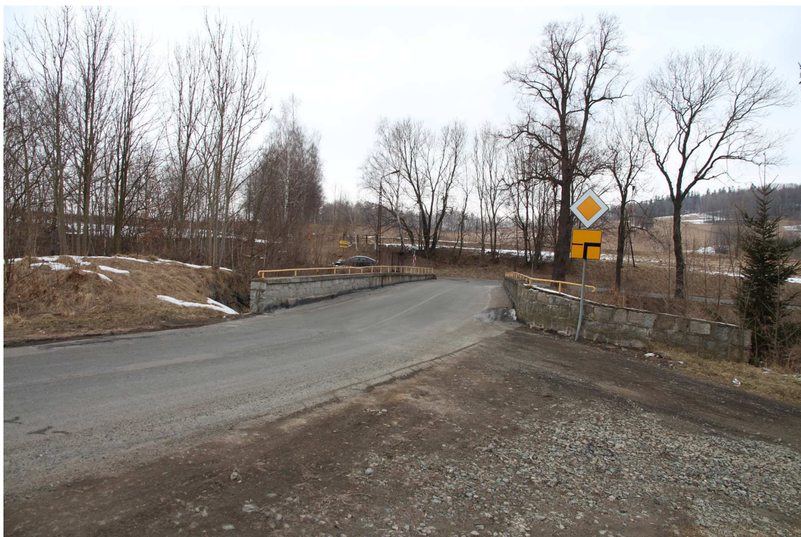
Fot. 5.1 Wjazd na obiekt od strony Rybnicy
