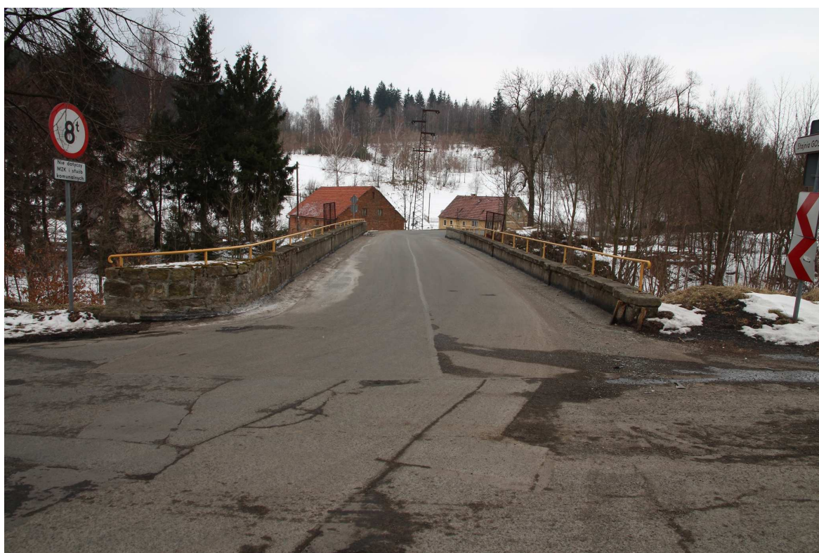
Fot. 5.2 Wjazd na obiekt od strony Jeleniej Góry
