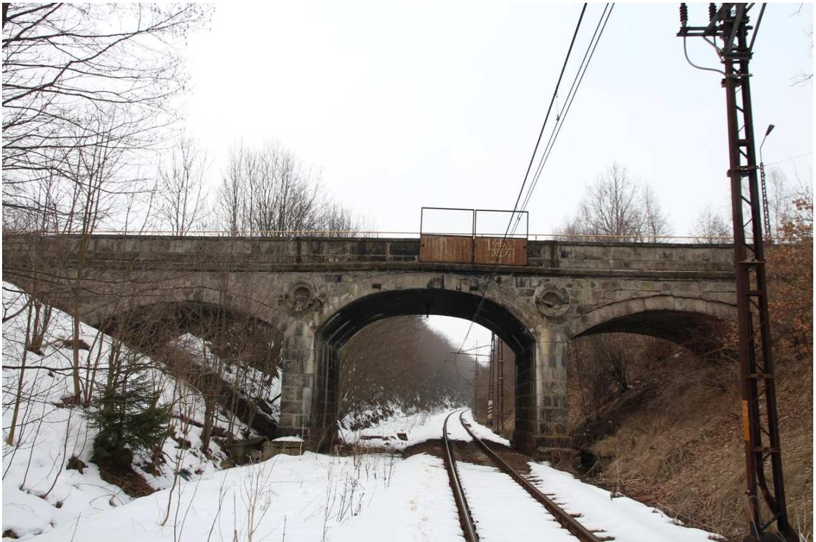
Fot. 5.3 Widok z boku od strony południowej (linia kolejowa od Jeleniej Góry)
