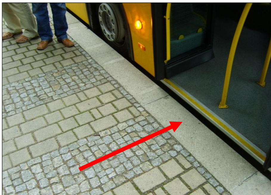
Rys. 31 Strefa wejściowa – inny rodzaj nawierzchni naprzeciwko pierwszych drzwi autobusu 62
