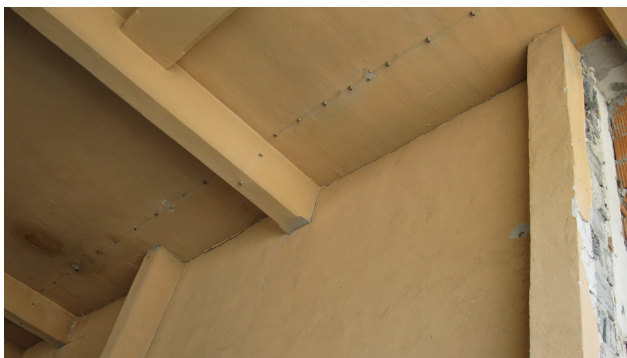
istniejącej ścianki działowej na parterze.
