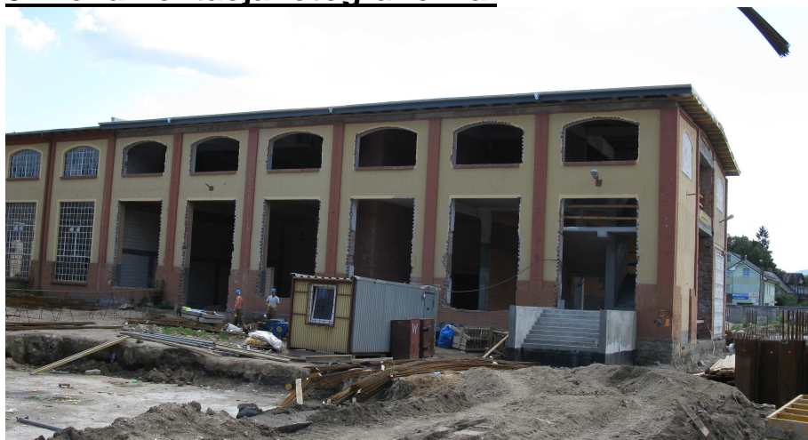
widok ogólny hali od strony elewacji północno-zachodniej
