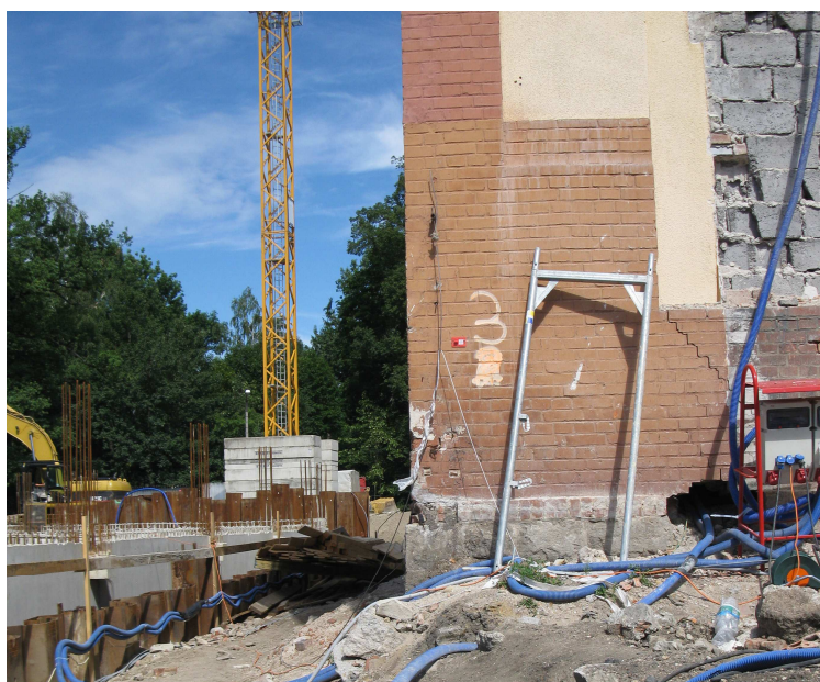
od strony elewacji południowo-wschodniej
