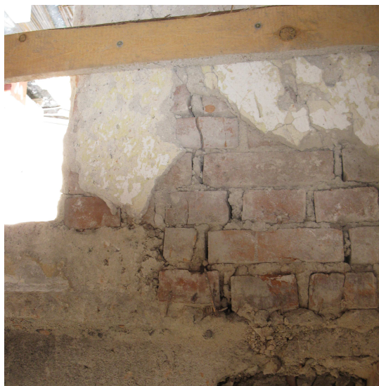
północno-zachodniej ( od wewnątrz)
